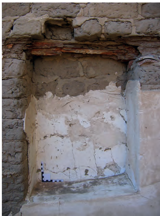
Abb. 21: Raum GB 5.2.1, Westwand, Boden der nördlichen Nische mit bräunlicher Bemalung; 2006
