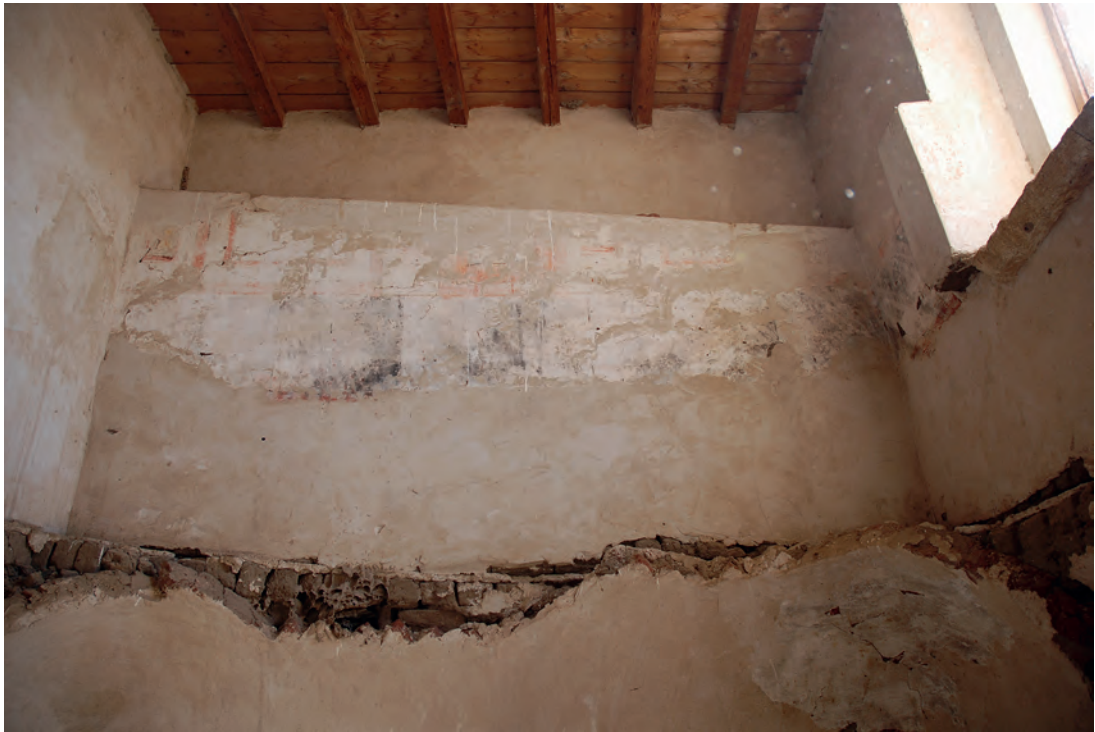
Abb. 4: Obergeschoss, 1. Raum, Ostwand; 2008
