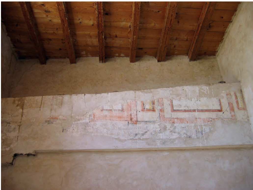
Abb. 17: Obergeschoss, 1. Raum, Westwand; 2005
