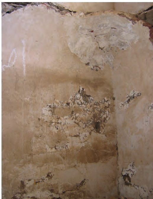
Abb. 11: Erdgeschoss, 1. Raum, Südostecke; 2005
