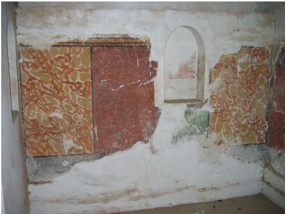
Abb. 9: Obergeschoss, 1. Raum, Westwand; 2006
