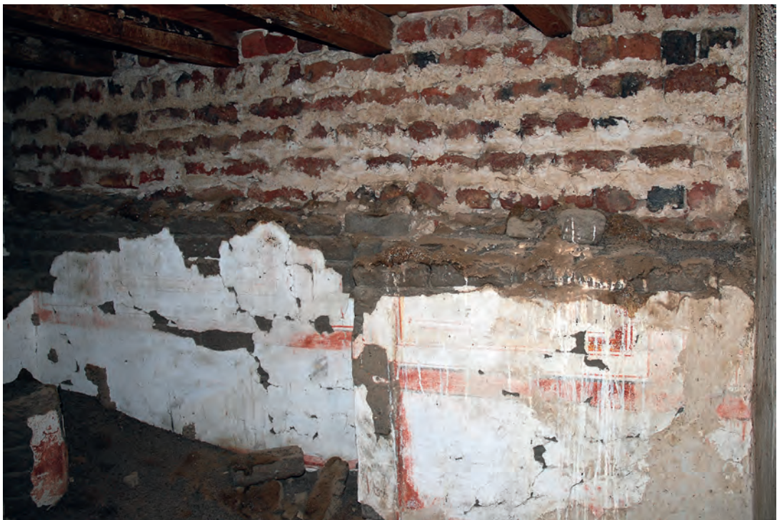
Abb. 20: Obergeschoss, 2. Raum, Ostwand; 2008
