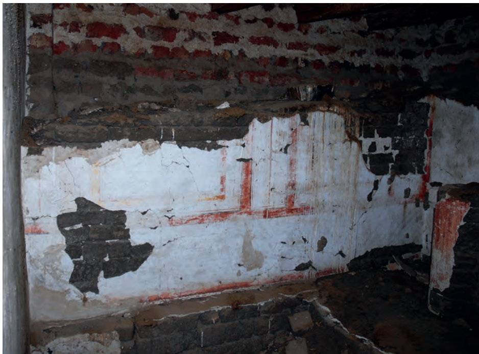
Abb. 18: Obergeschoss, 2. Raum, Westwand; 2008
