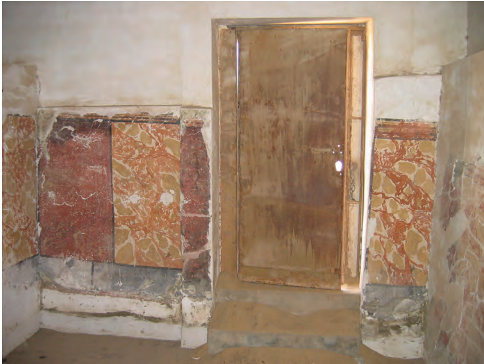
Abb. 8: Obergeschoss, 1. Raum, Nordwand; 2006
