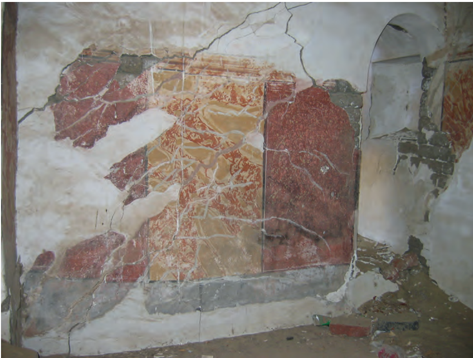
Abb. 10: Obergeschoss, 1. Raum, Ostwand; 2006
