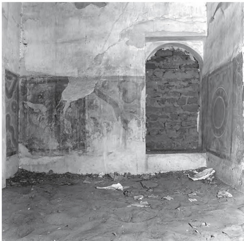
Abb. 24: Südseite von Raum GB 6.2.2; 1987
