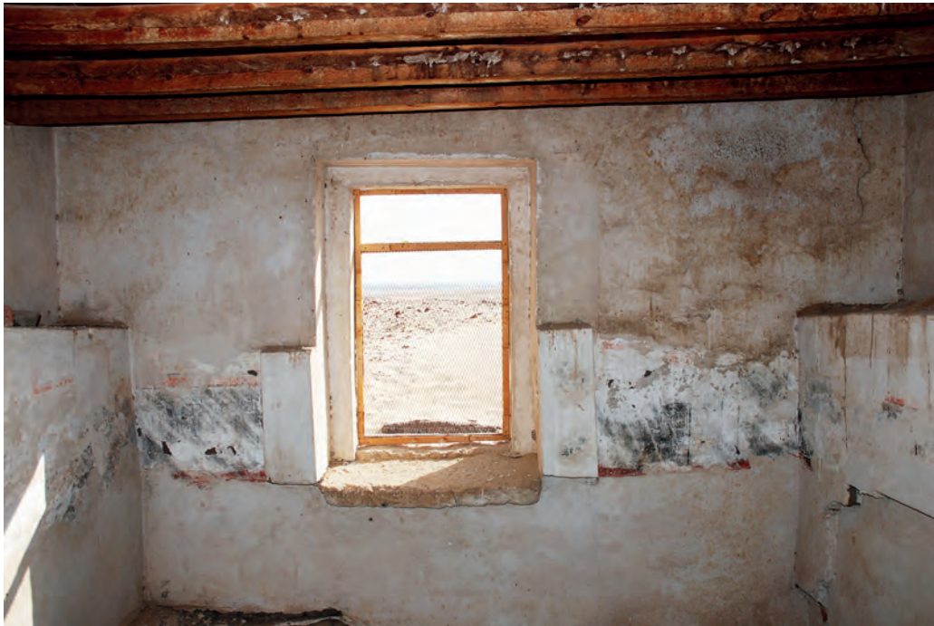
Abb. 16: Obergeschoss, 1. Raum, Südwand; 2008
