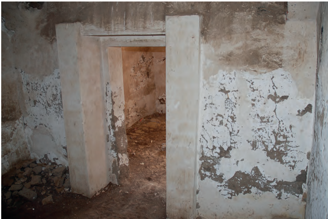
Abb. 12: Erdgeschoss, 2. Raum, Südwand von Westen; 2008
