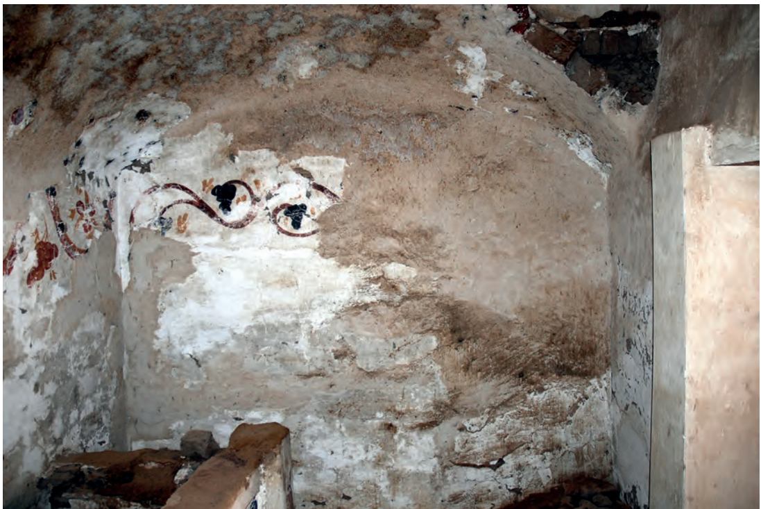
Abb. 14: Erdgeschoss, 2. Raum, Ostwand; 2008
