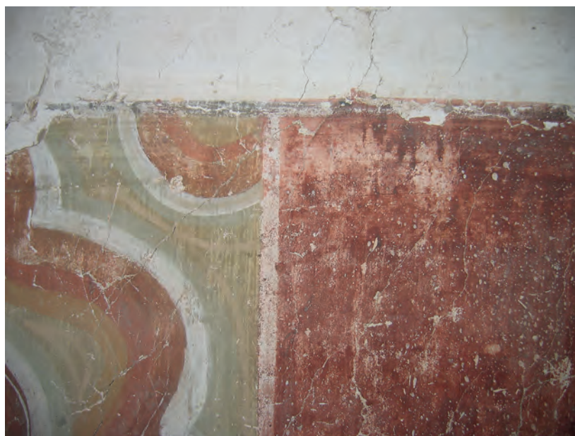
Abb. 8: Vorraum, Nordwand, Detail; 2007
