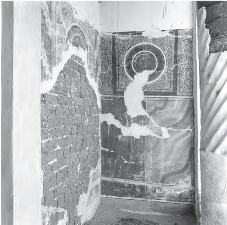
Abb. 40: Nordwand der Vorhalle GB 7.2.1; 1987
