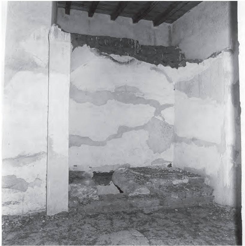
Abb. 21: Westseite von Raum GB 6.2.3 mit dem abgedeckten Grabschacht in dem Annex; 1987
