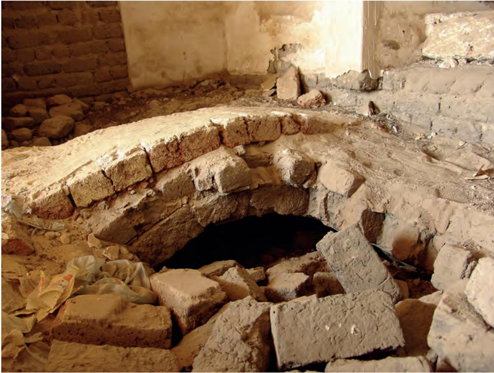
Abb. 8: Gewölbeausbruch im Fußboden in Raum GB 6.2.3; 2006
