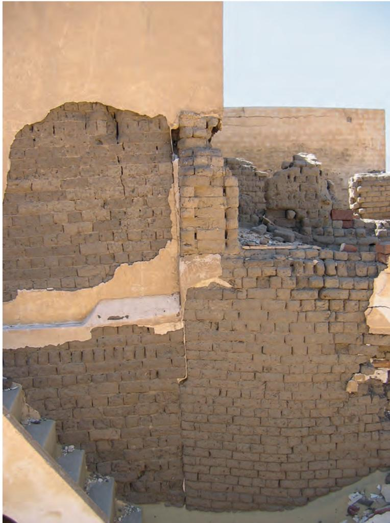
Abb. 12: Putzreste an der Nordwestecke im Unter- und Obergeschoss; 2005
