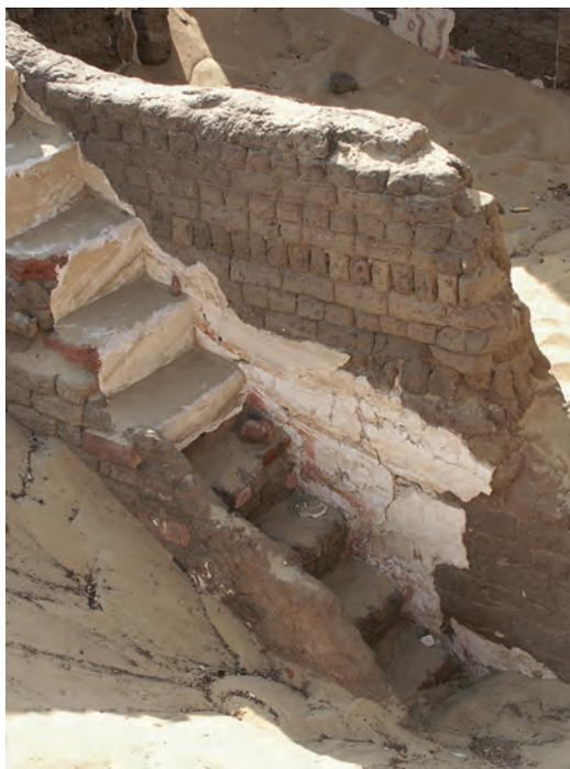
Abb. 13: GB 5, Straßentreppe. Treppenstufen aus gebrannten Ziegeln mit rot bemaltem Estrich; 2006
