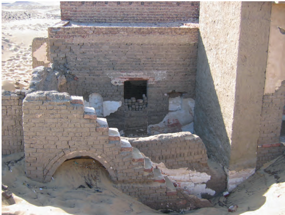
Abb. 12: GB 5, Ostansicht. Straßentreppe zum oberen Geschoss und dahinter die Ostfassade mit Resten des ursprünglichen Fassadenputzes. Rückseitig Raum GB 5.2.1 mit der Westwand und zentraler, zugesetzter Tür zu Raum GB 5.2.2, zwei Nischen und Wandmalereiesteren; 2006
