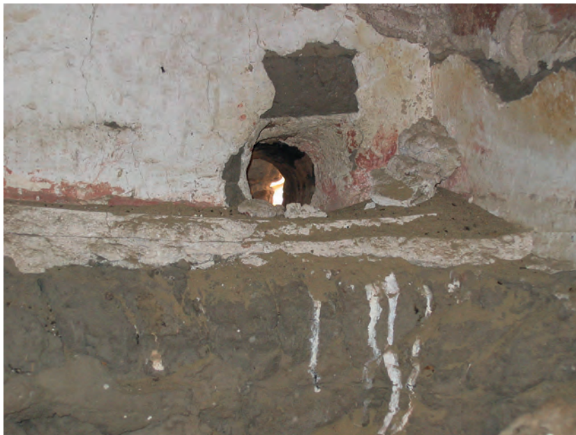
Abb. 25: Raum GB 7.3.3, Westwand nahe Nordwestecke, Wasserabfluss aus einem Amphorenhal; 2006
