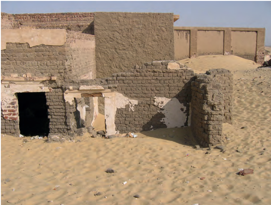
Abb. 10: Südfassade (GB 5.2.3), östliche Hälfte mit dem Zugang zu Raum GB 5.2.1 (= bauzeitlicher Haupteingang in das Geschoss GB 5.2); 2007
