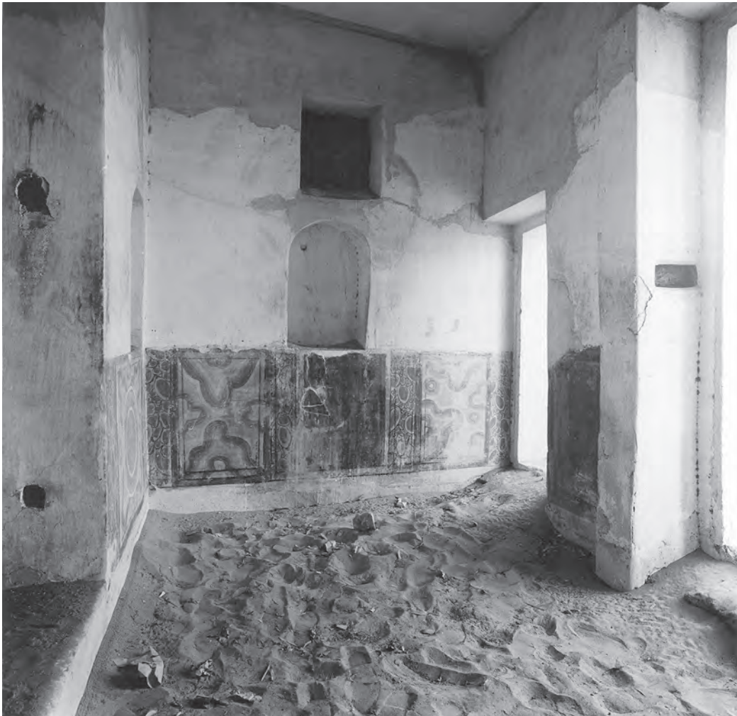
Abb. 18: Nordseite von Raum GB 6.2.2; 1987
