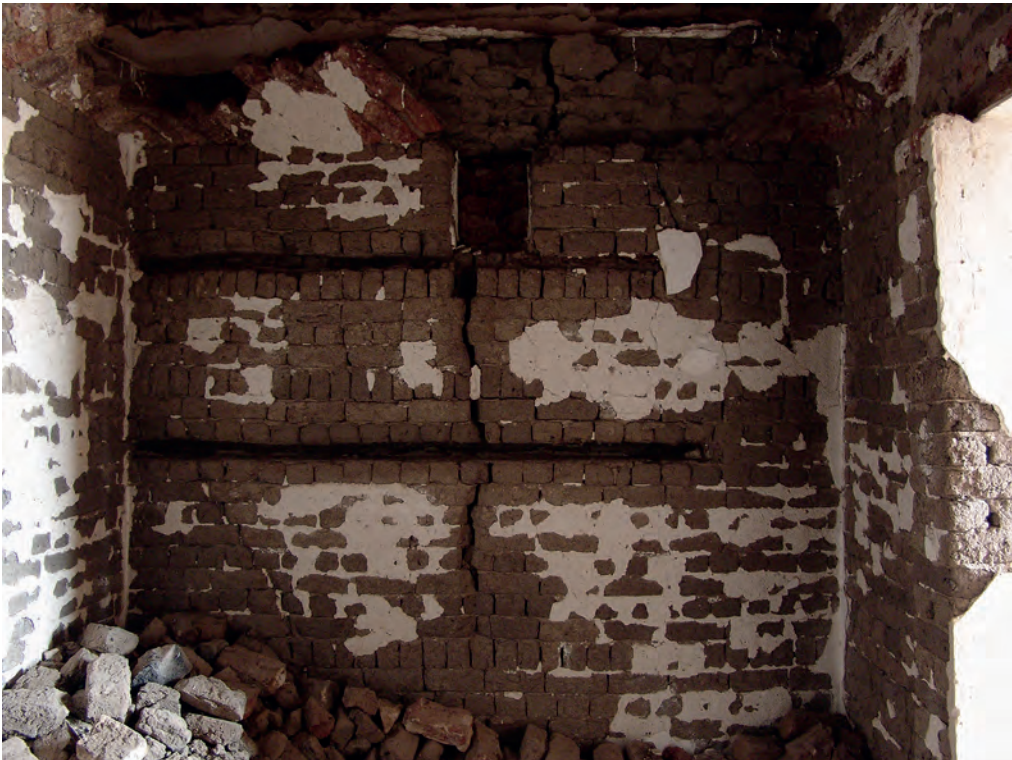
Abb. 26: Raum GB 7.2.3, Holzbewehrung in der Nordwand; 2006
