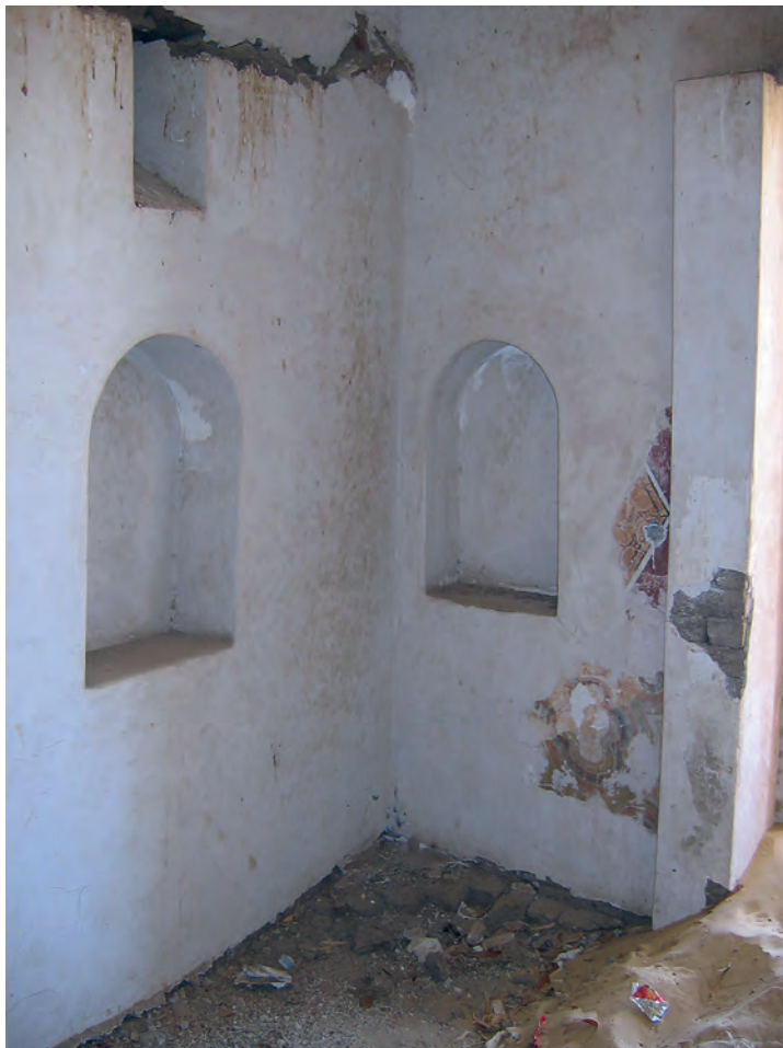
Abb. 20: Blick in die Nordostecke von Raum GB 7.2.2; 2005
