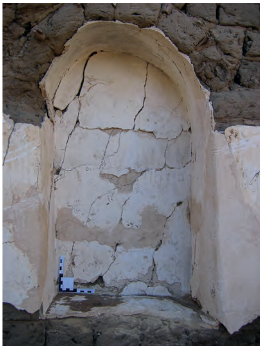
Abb. 20: Raum GB 5.2.1, Westwand, Boden der südlichen Rundbogennische mit Talgspuren; 2006
