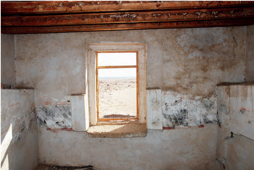
Abb. 16: Obergeschoss, 1. Raum, Südwand; 2008
