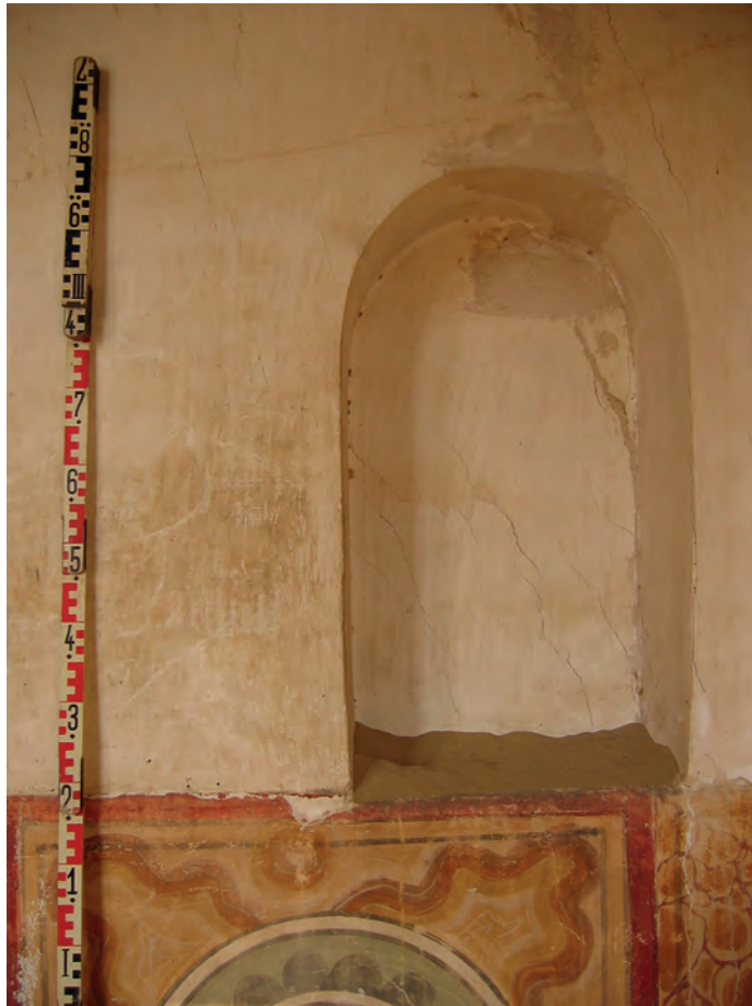
Abb. 28: Graffiti auf der Westwand von Raum GB 6.2.2; diese befinden sich links neben der Nische auf Höhe der Zahl 7 der Messlatte; 2010
