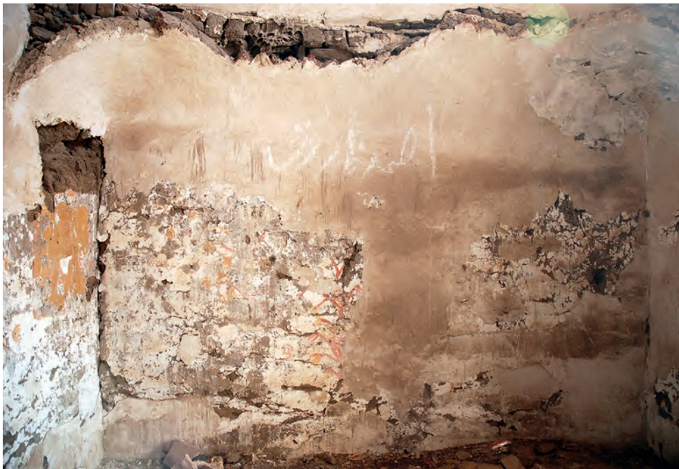
Abb. 8: Erdgeschoss, 1. Raum, Ostwand; 2005
