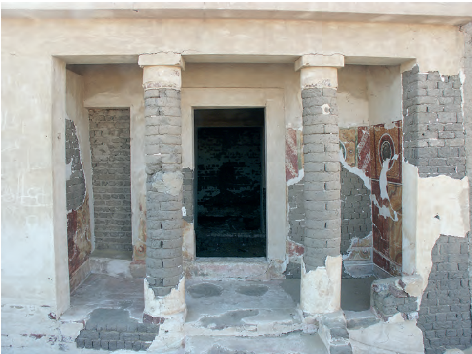
Abb. 7 b: Vorhalle GB 7.2.1; 2007
