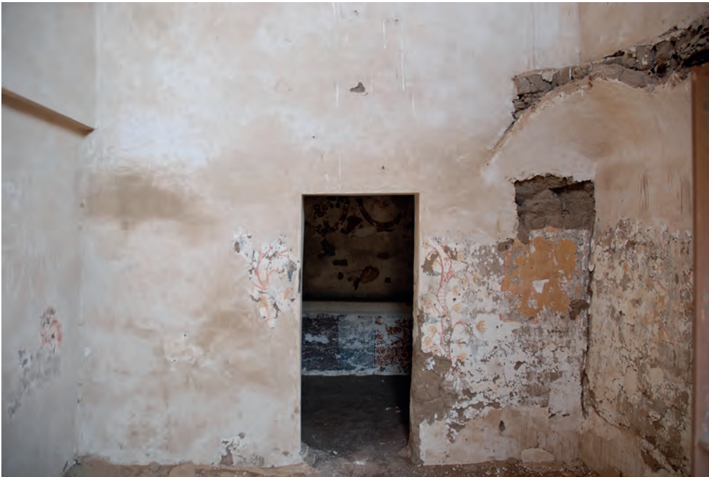
Abb. 21: Erdgeschoss, 1. Raum, Nordwand; 2008
