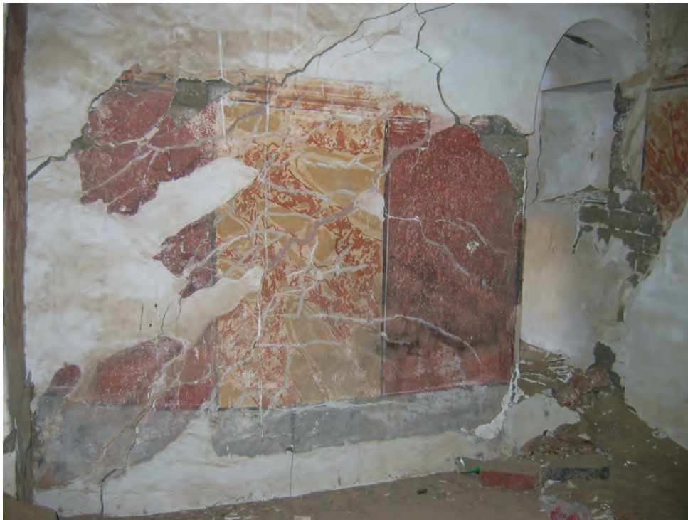
Abb. 10: Obergeschoss, 1. Raum, Ostwand; 2006
