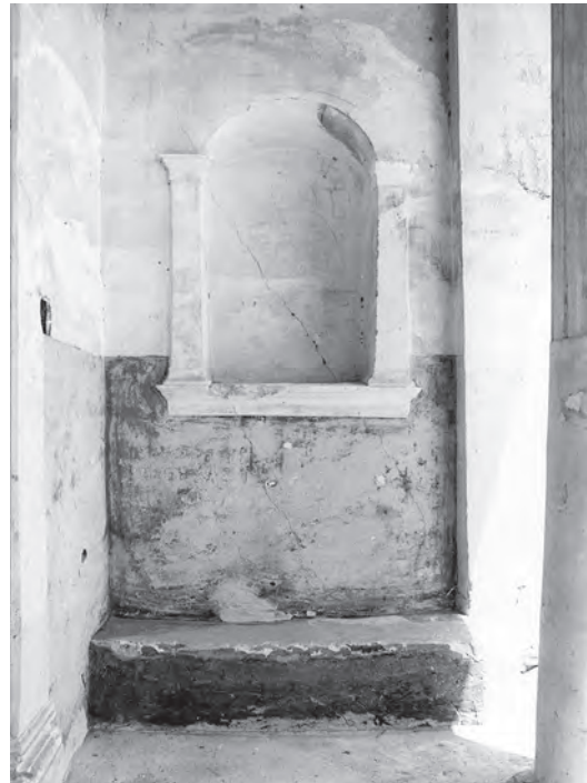
Abb. 4: Vorhalle, Nische in Ostwand; 1987
