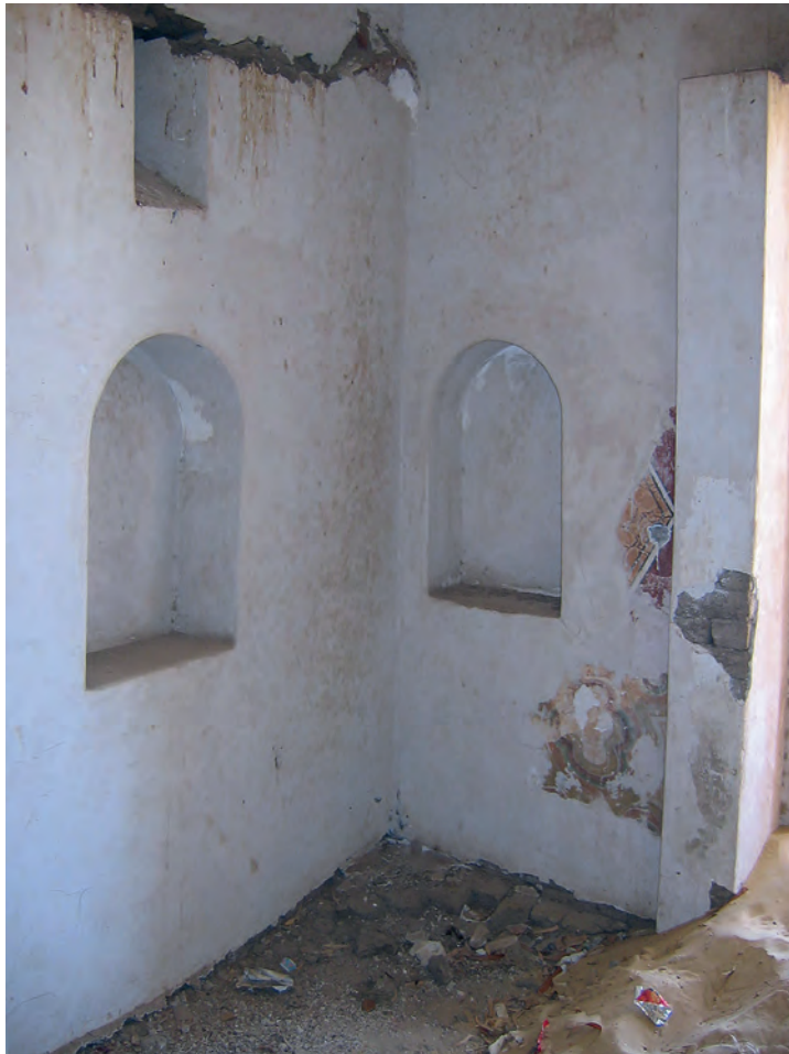
Abb. 20: Blick in die Nordostecke von Raum GB 7.2.2; 2005
