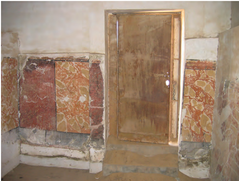
Abb. 8: Obergeschoss, 1. Raum, Nordwand; 2006
