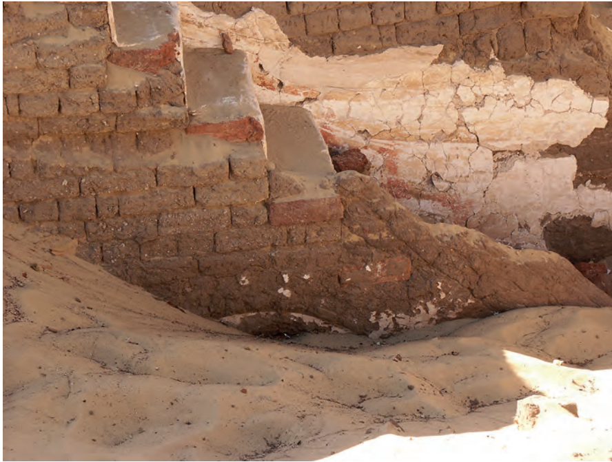
Abb. 14: GB 5, Straßentreppe. Treppenstufen aus gebrannten Ziegeln mit aufgesetzter Wange aus ungebrannten Ziegeln. Freigelegter Scheitel des nördlichen, tiefer gelegenen Substruktionsbogens mit Spuren von Lehmputz und Kalküberzug; 2006
