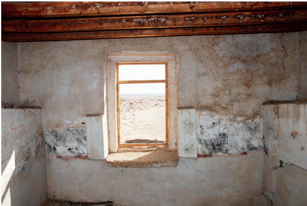
Abb. 16: Obergeschoss, 1. Raum, Südwand; 2008
