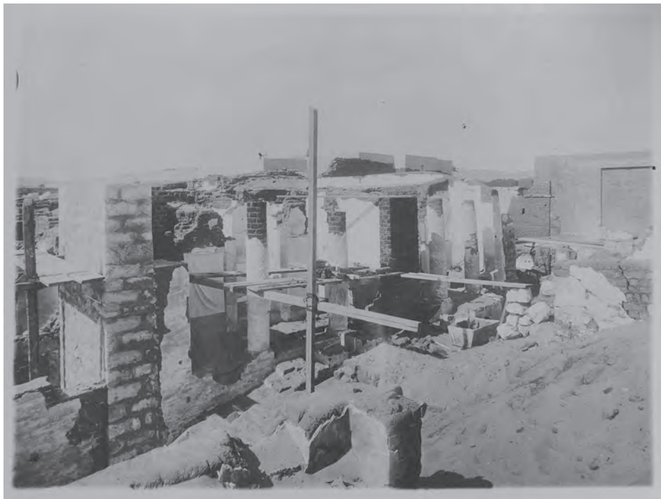
Abb. 4 c: Rekonstruktion der Grabbauten GB 6–7 unter der Leitung von Sami Gabra; 1934 (?)
