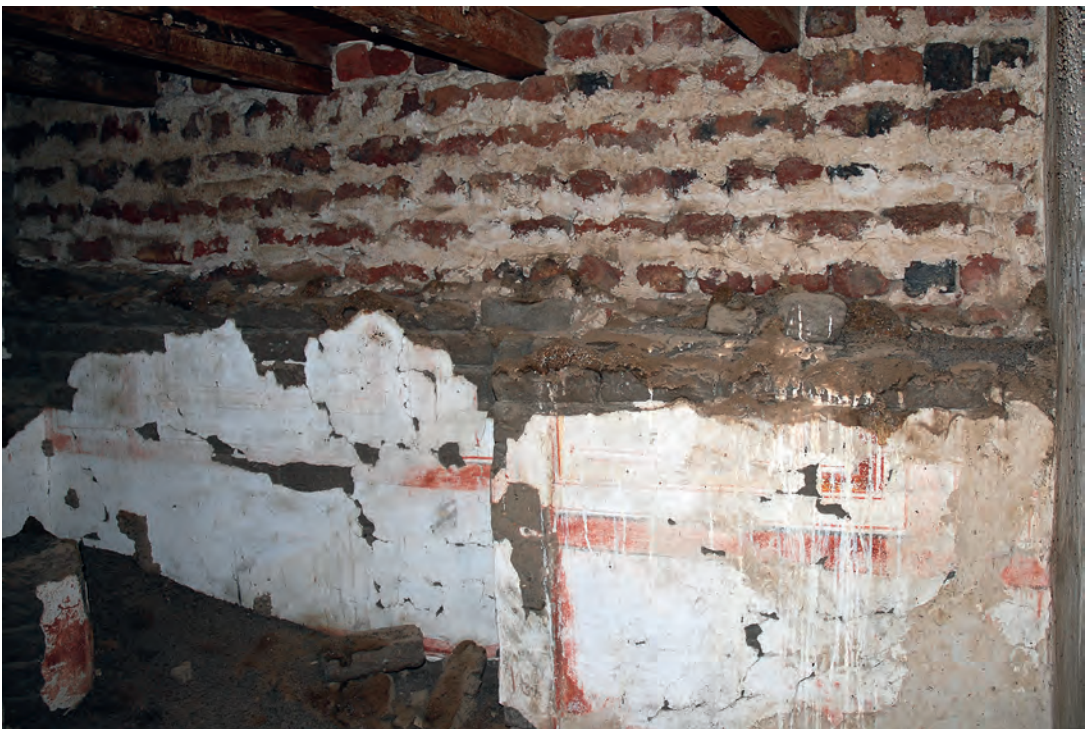
Abb. 20: Obergeschoss, 2. Raum, Ostwand; 2008
