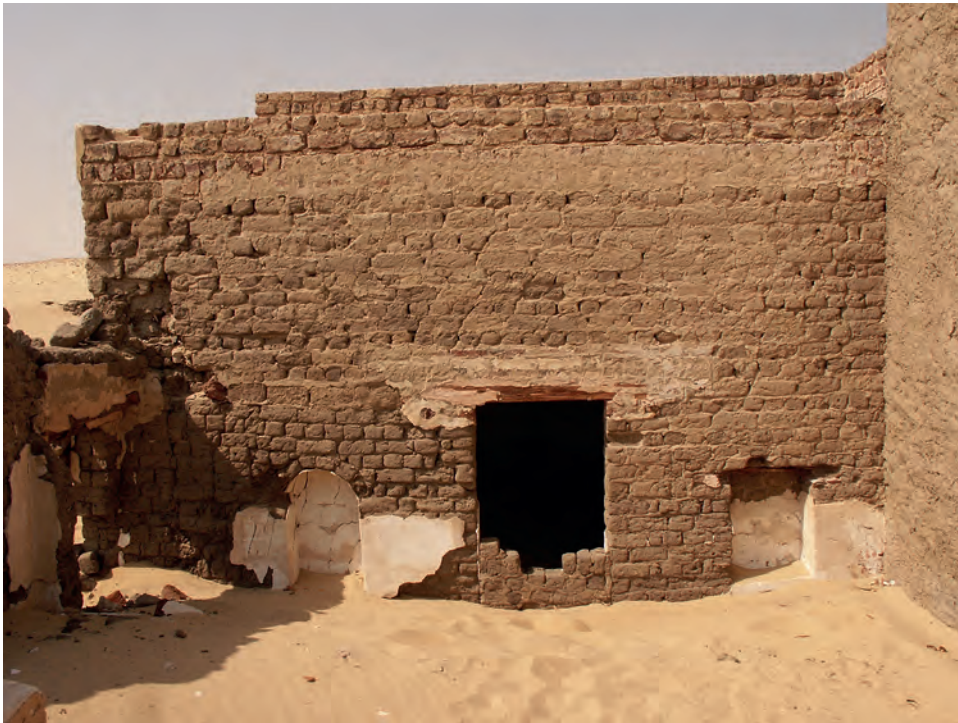
Abb. 19: Raum GB 5.2.1, Westwand mit zwei Nischen und zugesetzter Tür, Ansicht von Osten; 2006
