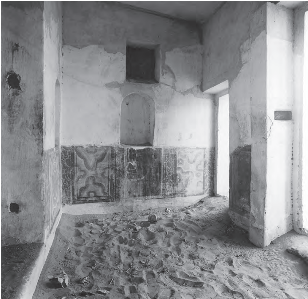
Abb. 18: Nordseite von Raum GB 6.2.2; 1987
