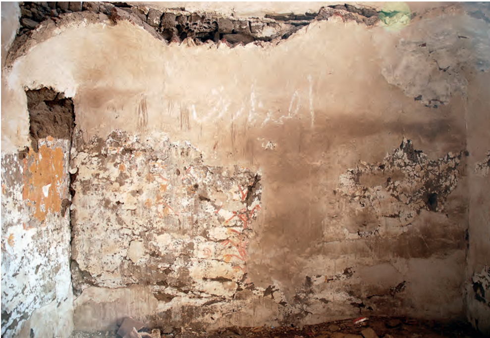
Abb. 8: Erdgeschoss, 1. Raum, Ostwand; 2005
