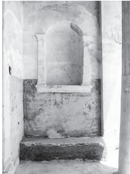
Abb. 4: Vorhalle, Nische in Ostwand; 1987
