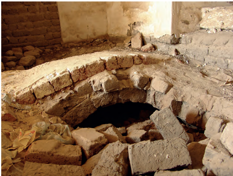
Abb. 8: Gewölbeausbruch im Fußboden in Raum GB 6.2.3; 2006
