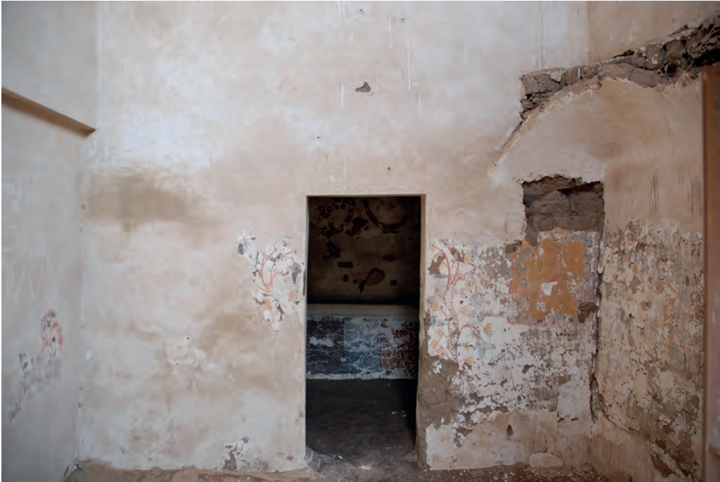
Abb. 21: Erdgeschoss, 1. Raum, Nordwand; 2008
