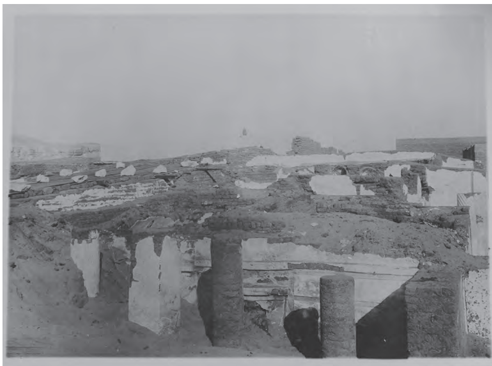
Abb. 3: GB 5, Südansicht während der Arbeiten Sami Gabras; 1930er-Jahre
