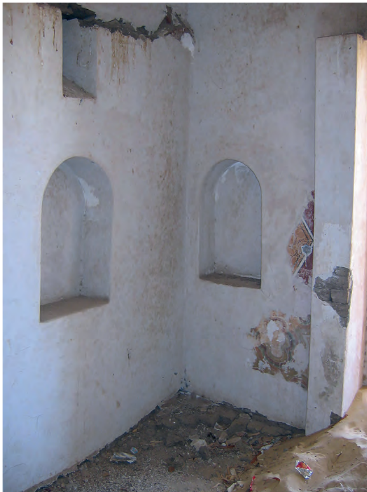
Abb. 20: Blick in die Nordostecke von Raum GB 7.2.2; 2005
