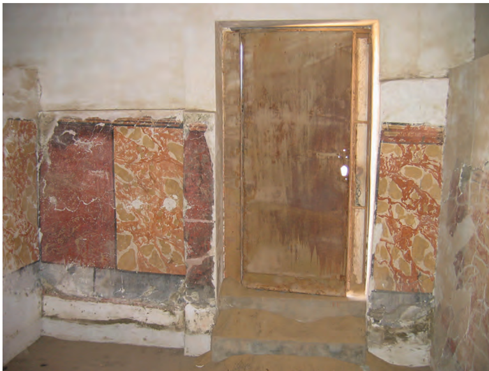
Abb. 8: Obergeschoss, 1. Raum, Nordwand; 2006
