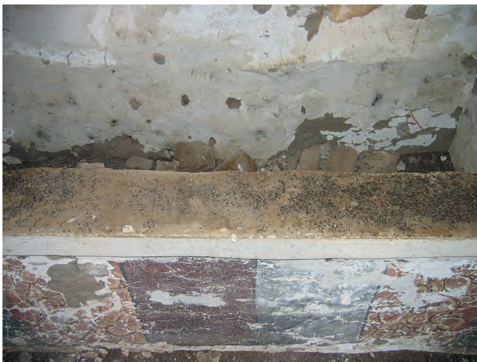
Abb. 24: Erdgeschoss, 2. Raum, Detail Nordwand; 2005
