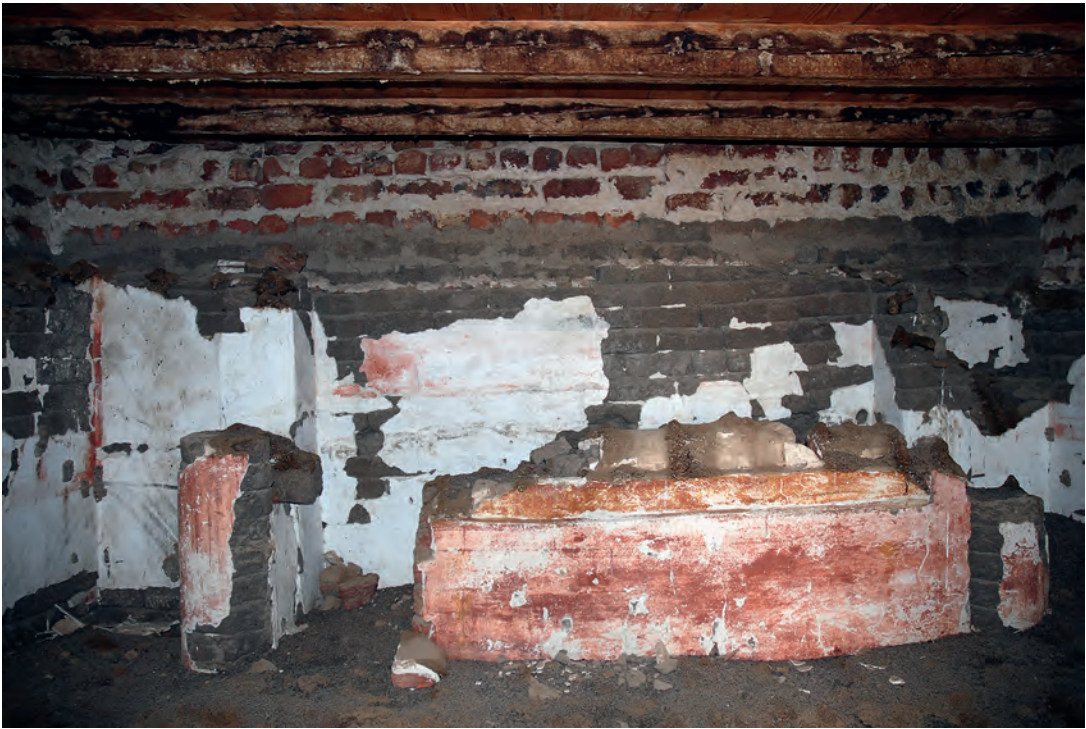
Abb. 19: Obergeschoss, 2. Raum, Nordwand; 2008
