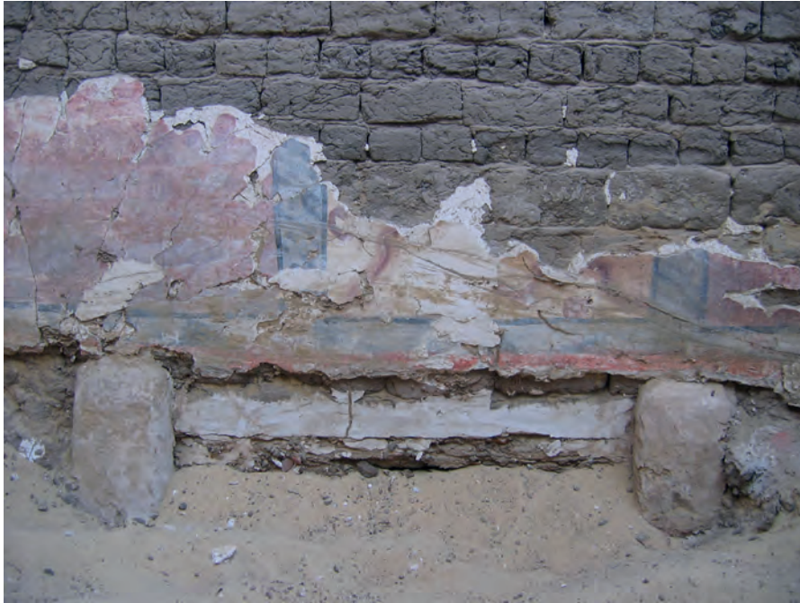
Abb. 17: Raum 5.2.1, Ostwand. Reste der Wandmalerei mit Gesteinsimitation (oben) sowie Sturz und gemauerte Türvorlagen der ehemaligen Haupttür zu Raum GB 5.1.1 (unten). Deutlich sichtbar sind hinter der abgeplatzten Wandmalerei die unterschiedlichen Ziegelformate und -farben vom unteren und mittleren Geschoss sowie die modernen Reparaturen und Ergänzungen an Sturz und Malerei; 2006
