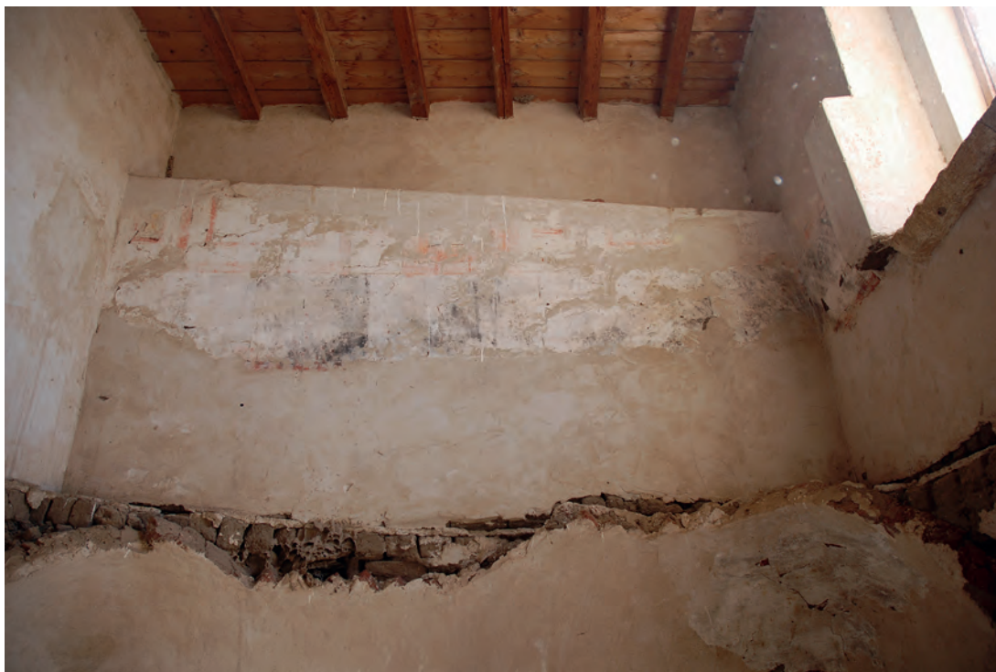
Abb. 4: Obergeschoss, 1. Raum, Ostwand; 2008
