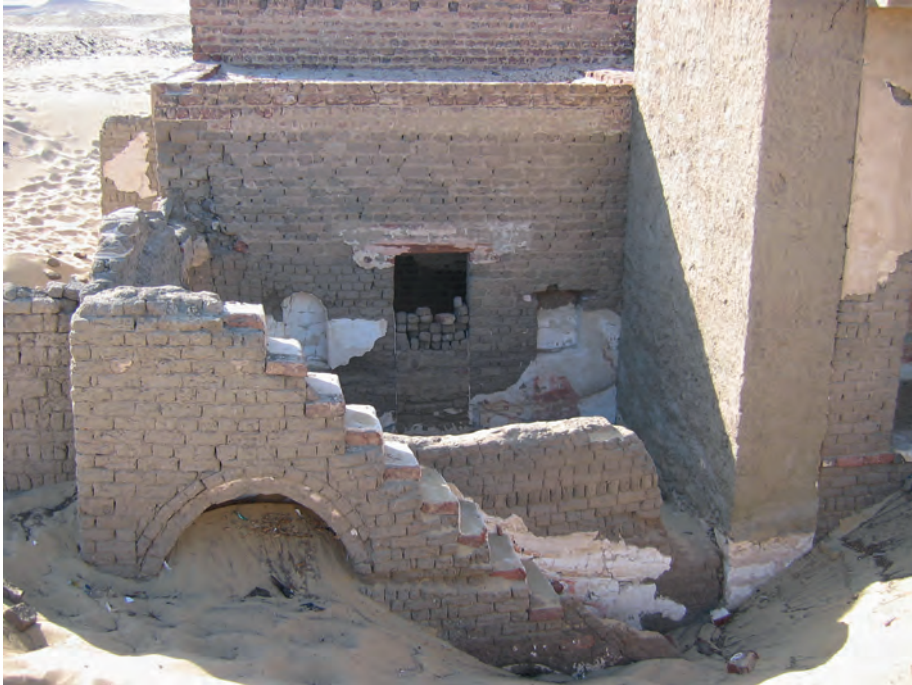
Abb. 12: GB 5, Ostansicht. Straßentreppe zum oberen Geschoss und dahinter die Ostfassade mit Resten des ursprünglichen Fassadenputzes. Rückseitig Raum GB 5.2.1 mit der Westwand und zentraler, zugesetzter Tür zu Raum GB 5.2.2, zwei Nischen und Wandmalereiesteren; 2006
