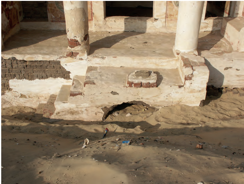
Abb. 14 a: Oberer Treppenabsatz mit den Resten eines kleinen Altars vor der Vorhalle GB 6.2.1; 2007
