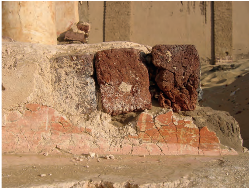
Abb. 15: Treppenstufe mit zwei Phasen der Bemalung des Estrichs im Bereich der Vorhalle GB 7.2.1; 2007
