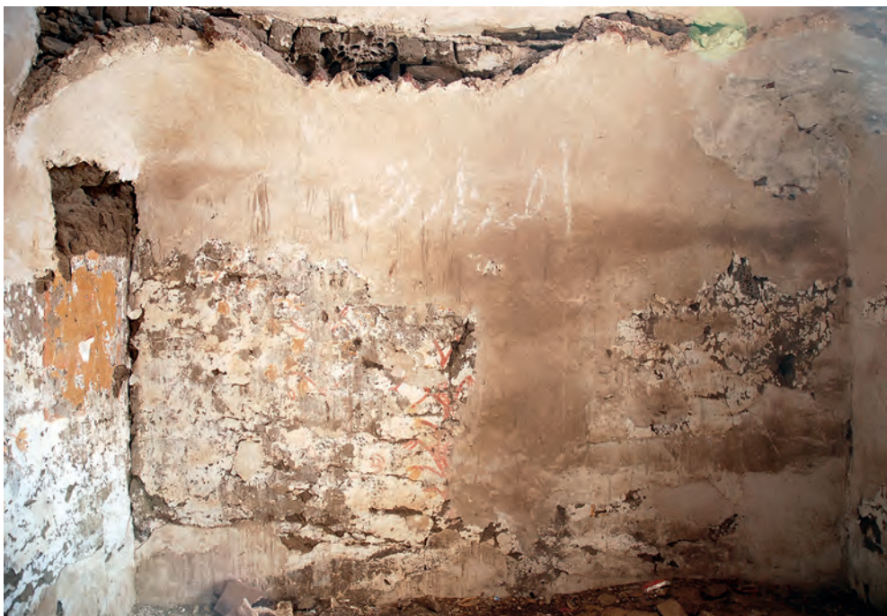
Abb. 8: Erdgeschoss, 1. Raum, Ostwand; 2005
