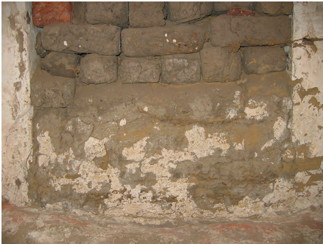
Abb. 26: Raum GB 5.2.2, Ostwand. In der Antike sekundär zugesetzter Durchgang zu Raum GB 5.2.1. Die oberen drei Lagen aus wiederverwendeten Ziegeln wurden später hinzugefügt (Rekonstruktion), Blick nach Osten; 2006
