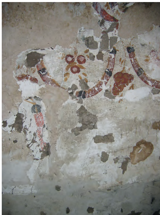
Abb. 23: Erdgeschoss, 2. Raum, Detail Nordwand; 2005
