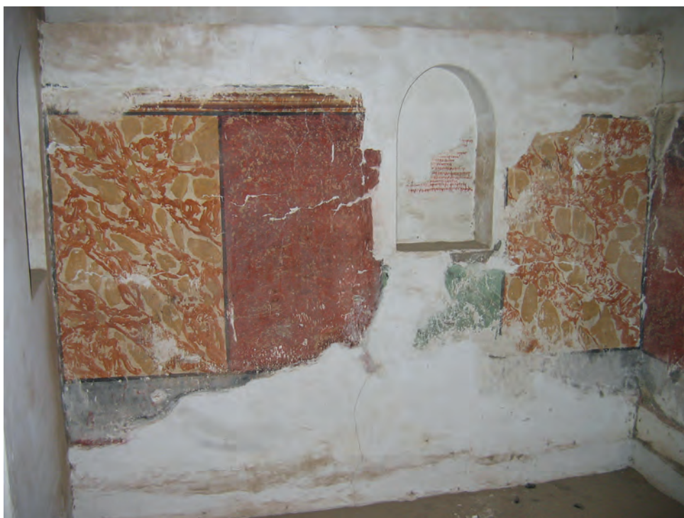
Abb. 9: Obergeschoss, 1. Raum, Westwand; 2006
