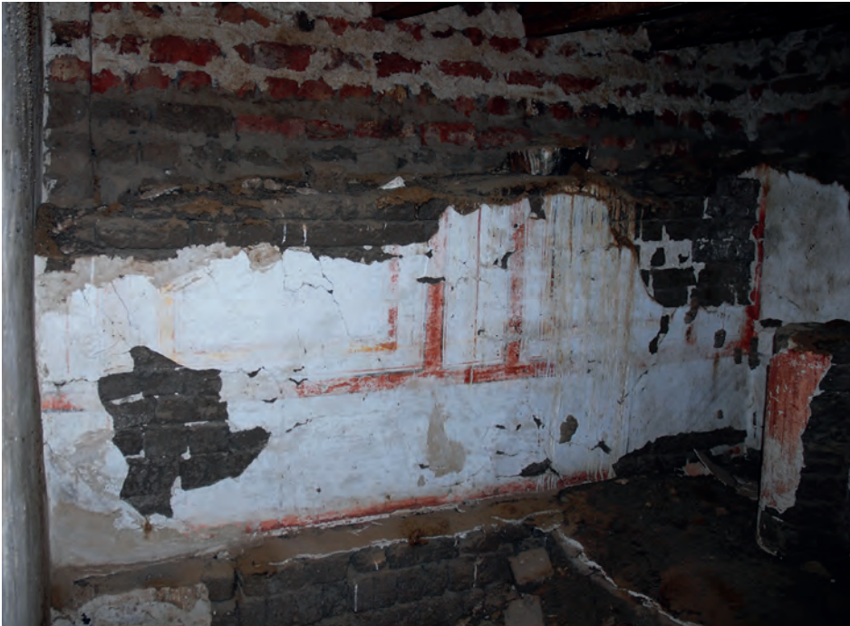
Abb. 18: Obergeschoss, 2. Raum, Westwand; 2008
