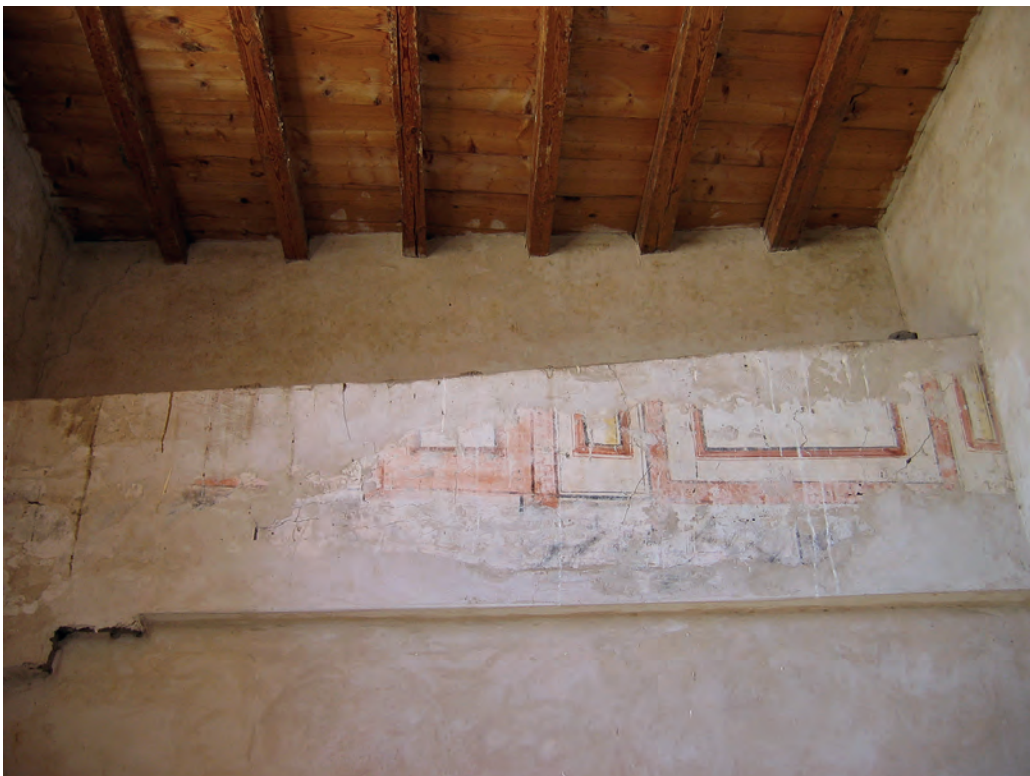
Abb. 17: Obergeschoss, 1. Raum, Westwand; 2005
