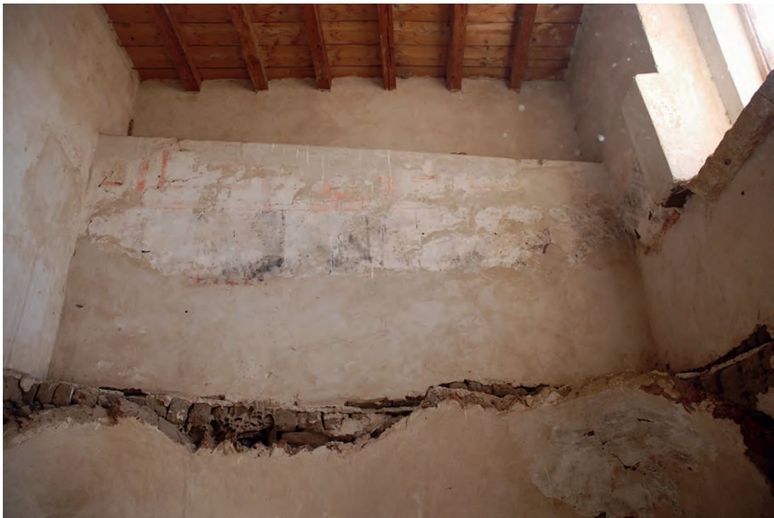
Abb. 4: Obergeschoss, 1. Raum, Ostwand; 2008
