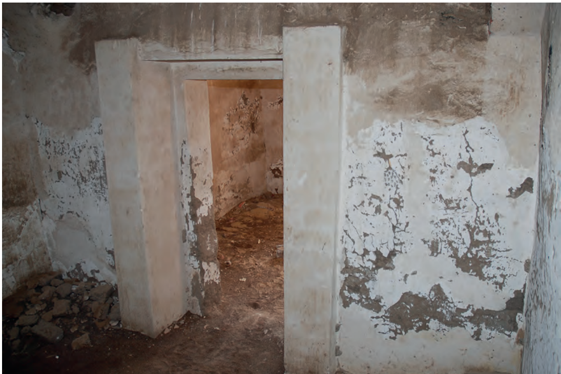
Abb. 12: Erdgeschoss, 2. Raum, Südwand von Westen; 2008
