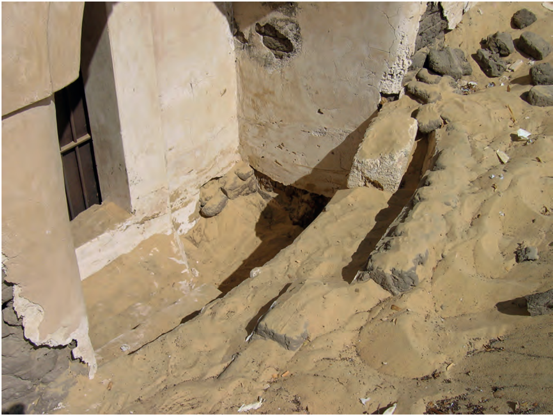
Abb. 15: Erdgeschoss, Eingang von Westen; 2006
