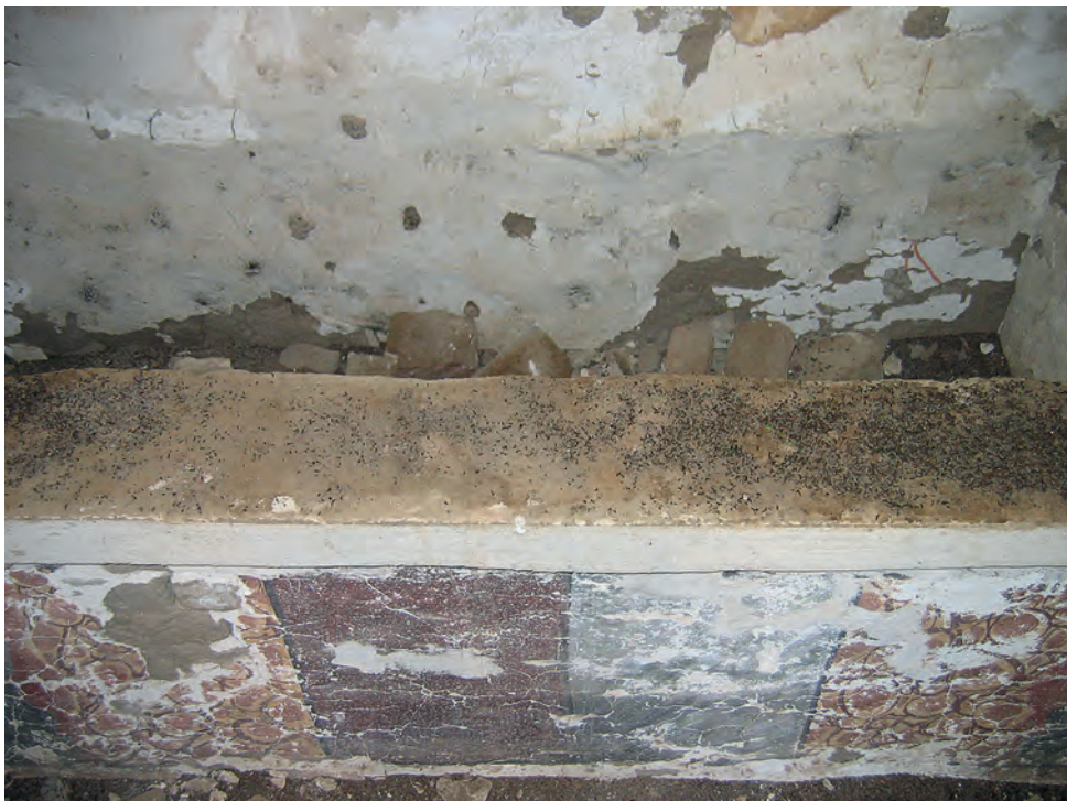
Abb. 24: Erdgeschoss, 2. Raum, Detail Nordwand; 2005
