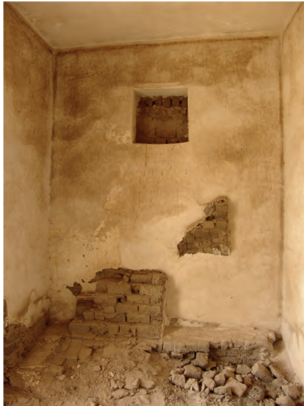
Abb. 23: Blick auf die Südwand in Raum GB 7.2.2 mit den Überresten der Treppe; 2006
