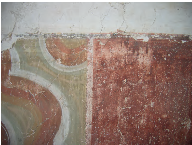
Abb. 8: Vorraum, Nordwand, Detail; 2007
