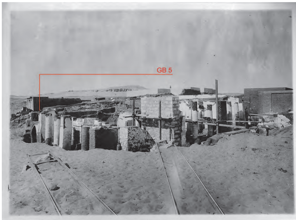
Abb. 2: GB 5, Ansicht von Südosten während der Arbeiten Sami Gabras; 1930er-Jahre
