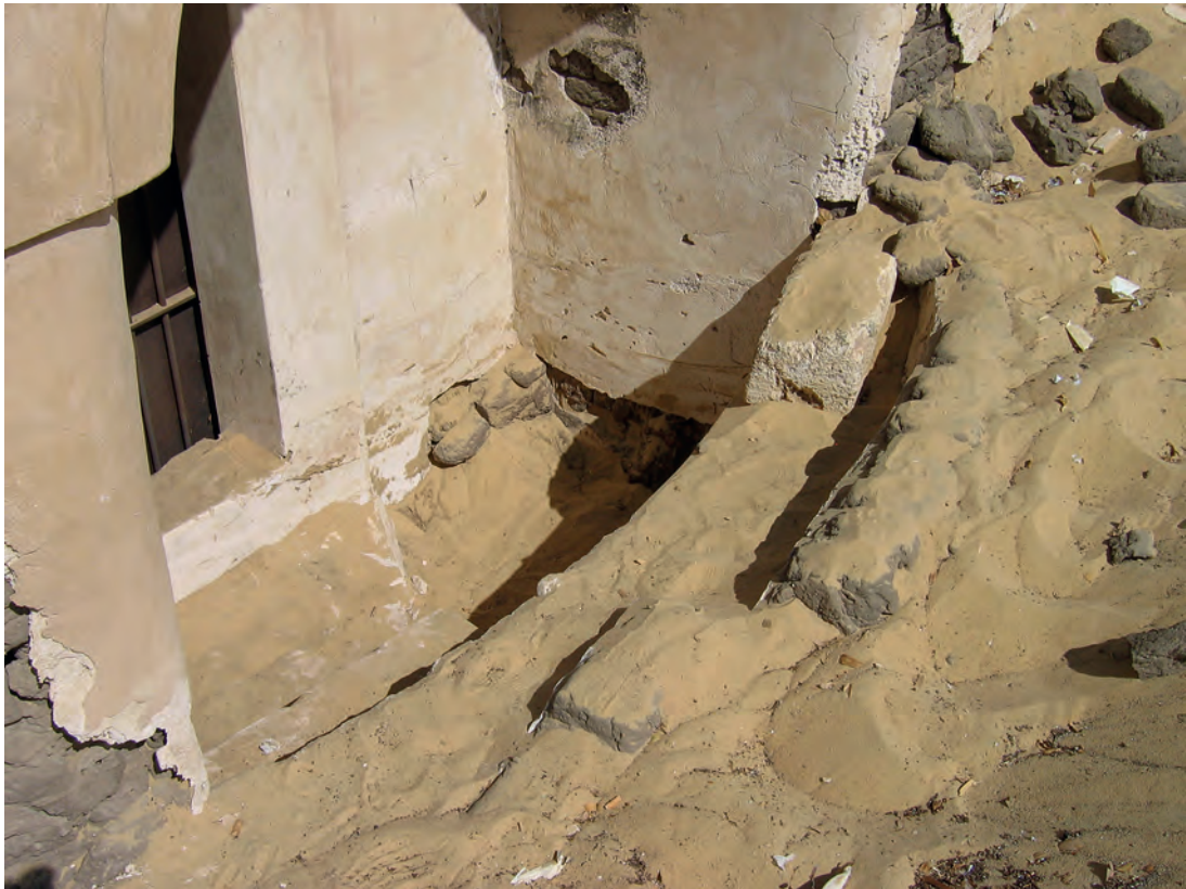
Abb. 15: Erdgeschoss, Eingang von Westen; 2006
