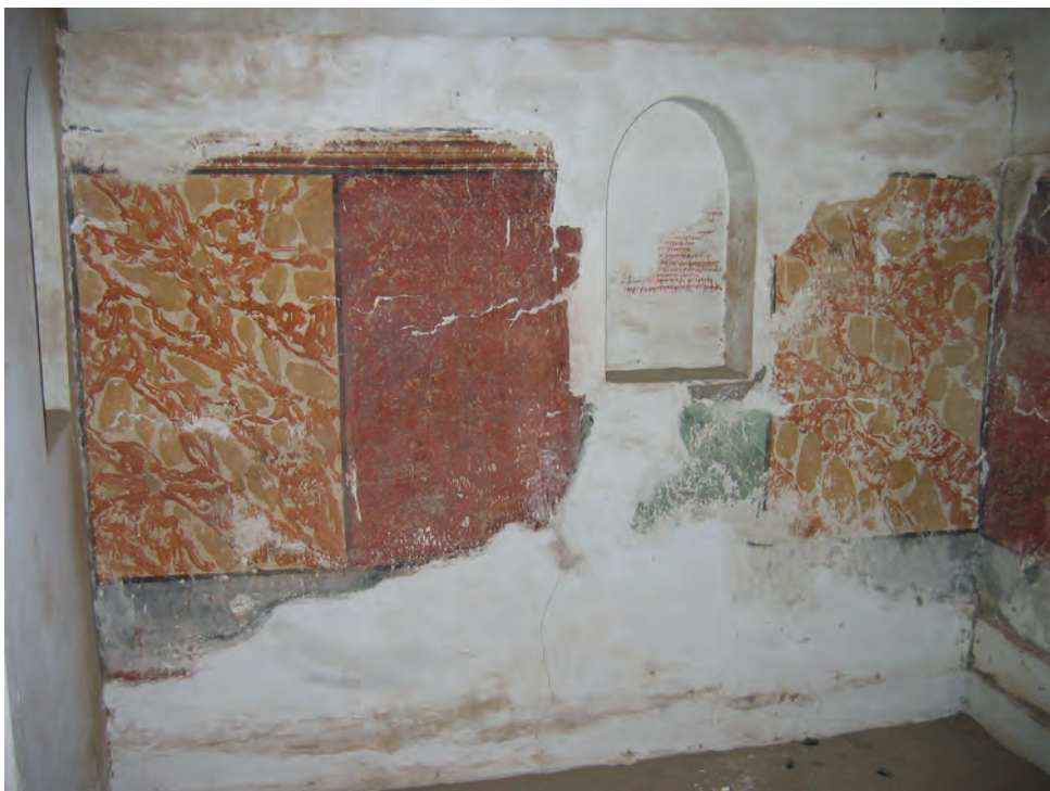
Abb. 9: Obergeschoss, 1. Raum, Westwand; 2006
