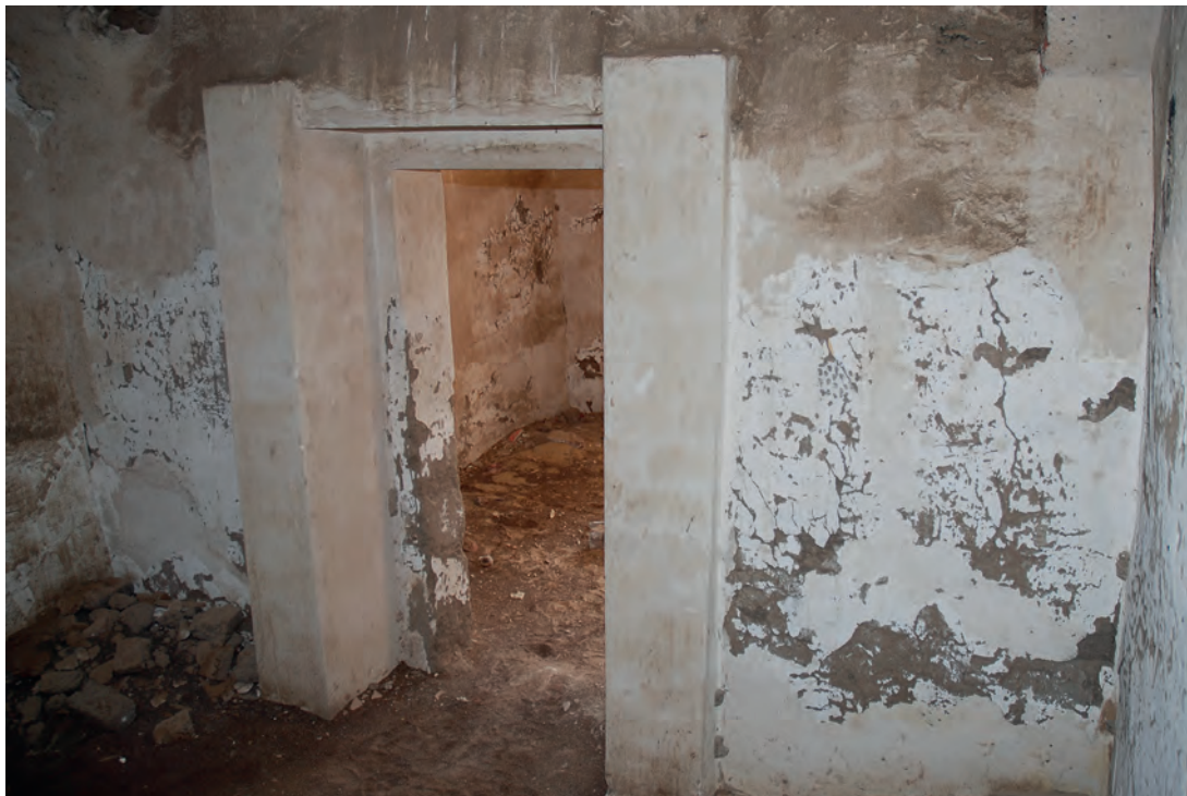
Abb. 12: Erdgeschoss, 2. Raum, Südwand von Westen; 2008
