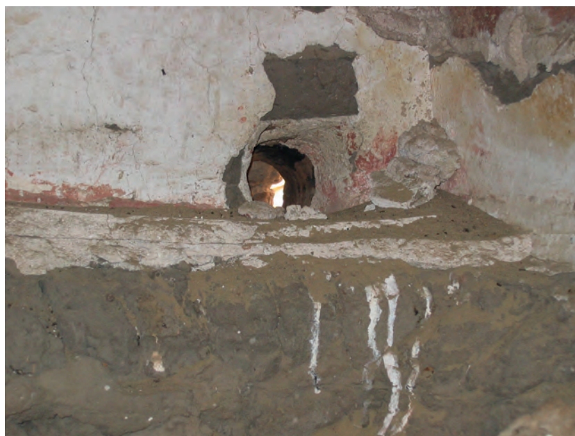
Abb. 25: Raum GB 7.3.3, Westwand nahe Nordwestecke, Wasserabfluss aus einem Amphorenhals; 2006
