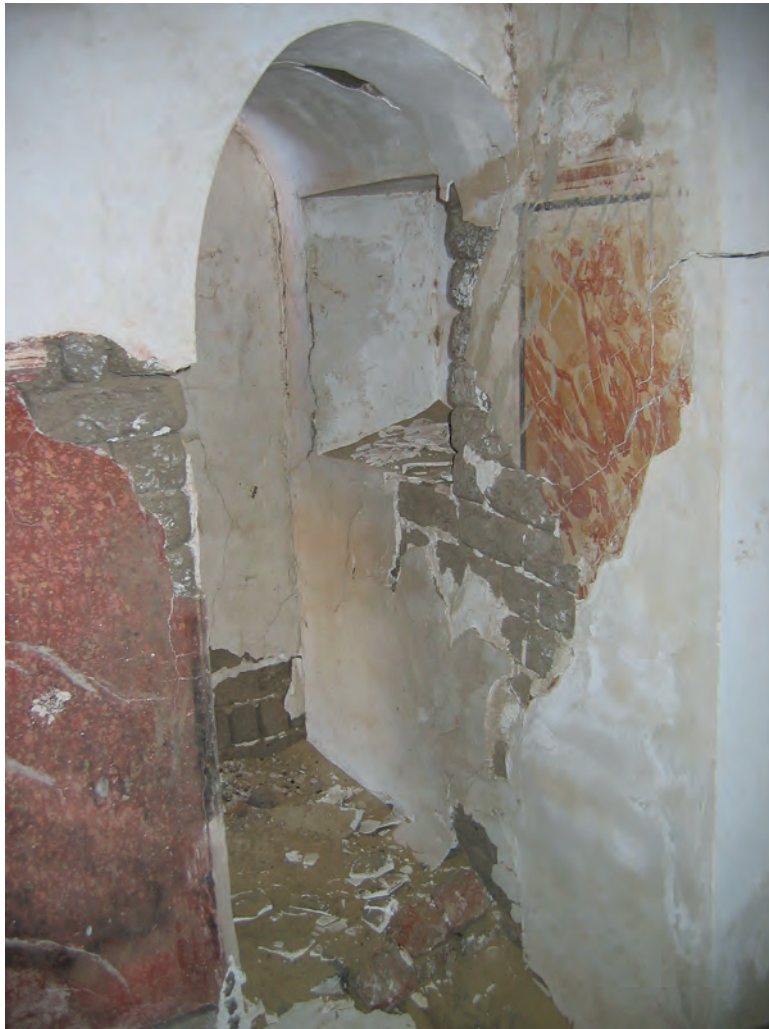
Abb. 11: Obergeschoss, 1. Raum, Ostwand, Seitenkammer; 2006
