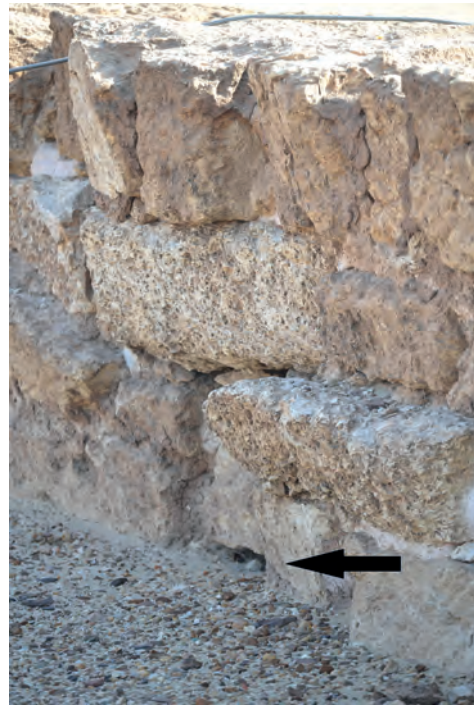
Abb. 5 b: GB 44: Öffnung vom Dach aus zum Wasserspeier hin; 2021
