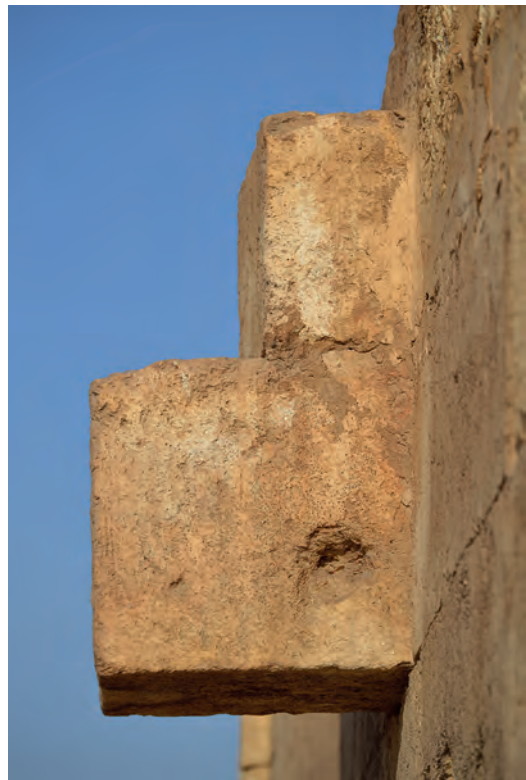
Abb. 7 b: Wasserspeier am Grab des Petosiris (GB 50), Südseite; 2021
