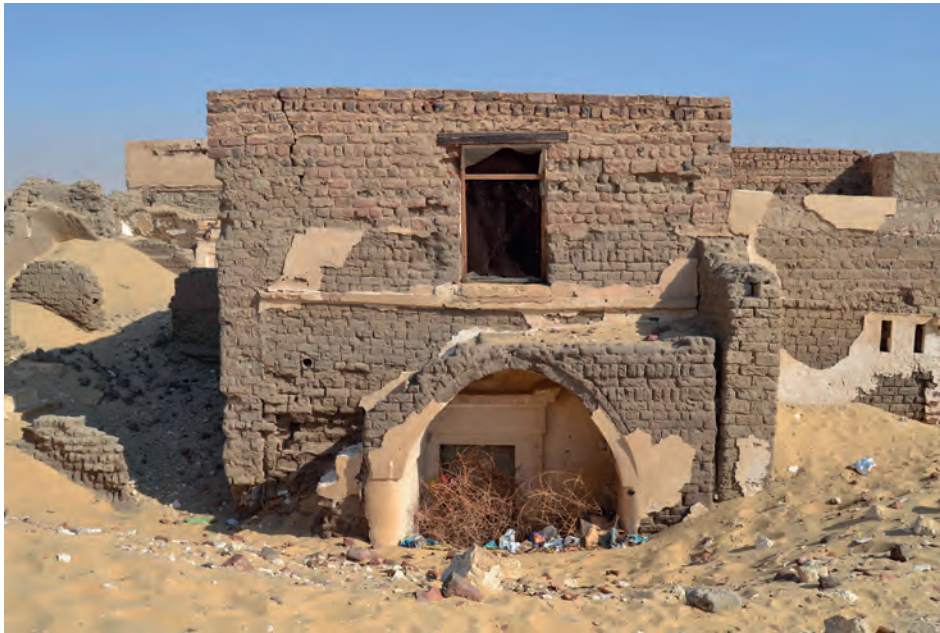
Abb. 9 a: GB 4, ein Keramikrohr ragt links neben dem Eingang aus der Wand; 2021
