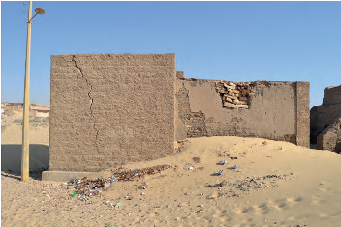
Abb. 10 a: Moderne Dachentwässerung an GB 30: das Ausflussloch befindet sich im oberen Abschnitt in der Mitte der Wand; 2021
