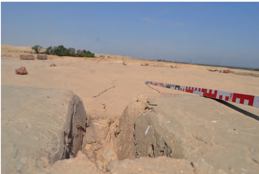
Abb. 10 c: Moderne Dachentwässerung an GB 30: Blick auf das Dach; 2021
