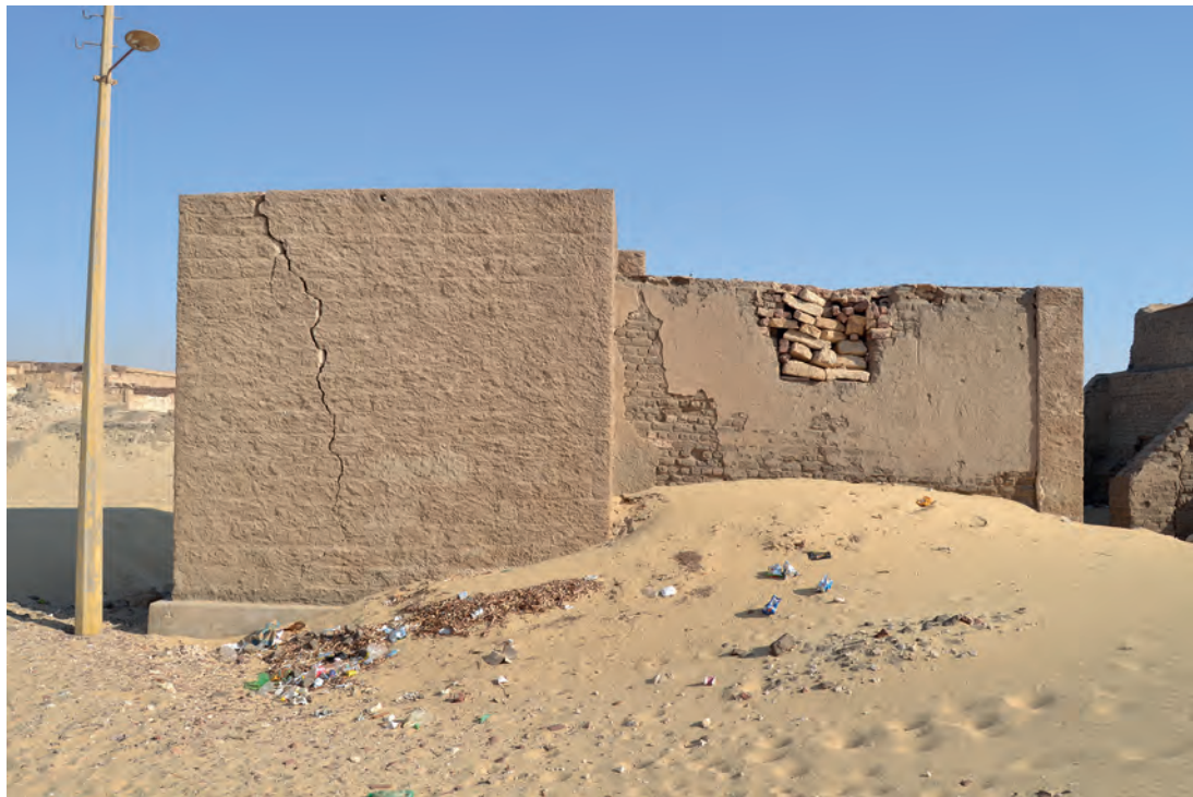
Abb. 10 a: Moderne Dachentwässerung an GB 30: das Ausflussloch befindet sich im oberen Abschnitt in der Mitte der Wand; 2021
