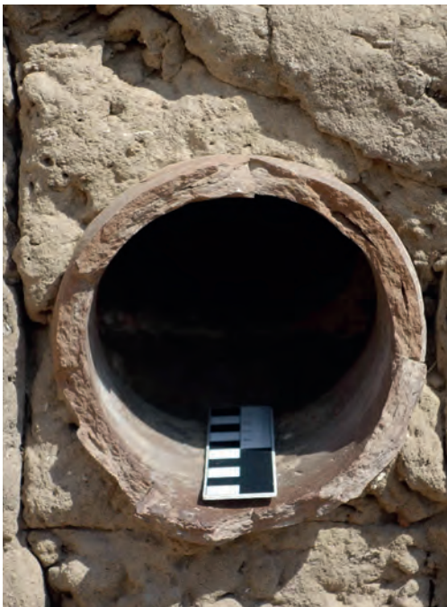
Abb. 9 b: GB 4, Detailaufnahme des Keramikrohres, das aus der Wand hervorrägt; 2021
