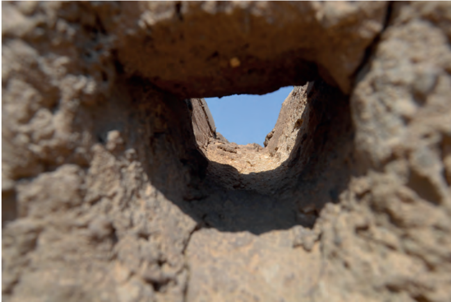
Abb. 10 b: Moderne Dachentwässerung an GB 30: Einblick in den Ausfluss; 2021
