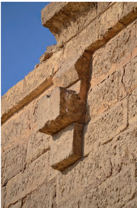
Abb. 6 a: Wasserspeier an GB 48, Seitenansicht; 2021
