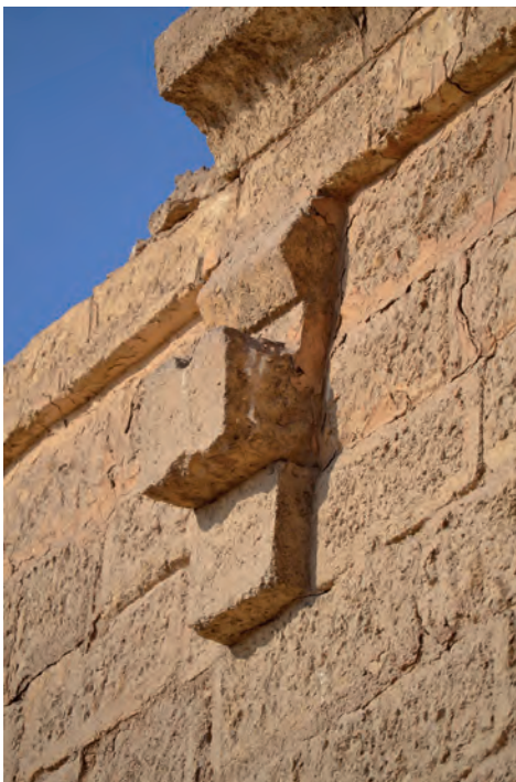
Abb. 6 a: Wasserspeier an GB 48, Seitenansicht; 2021
