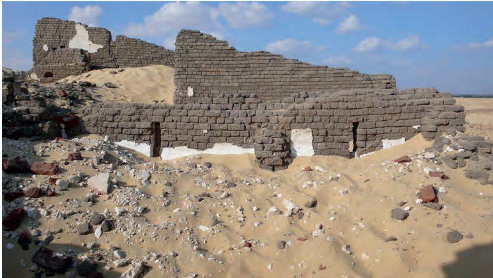
Abb. 33: GB 202, Gewölbeaufleger der Hängekuppel in der Nordwand von Raum GB 202.1.1 (links) und Raum GB 202.2.2 (rechts); 2010
