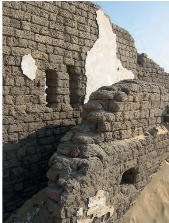
Abb. 32: GB 204.2.4, Rundbogennische mit Fensteröffnungen, Außenansicht von Süden; 2010
