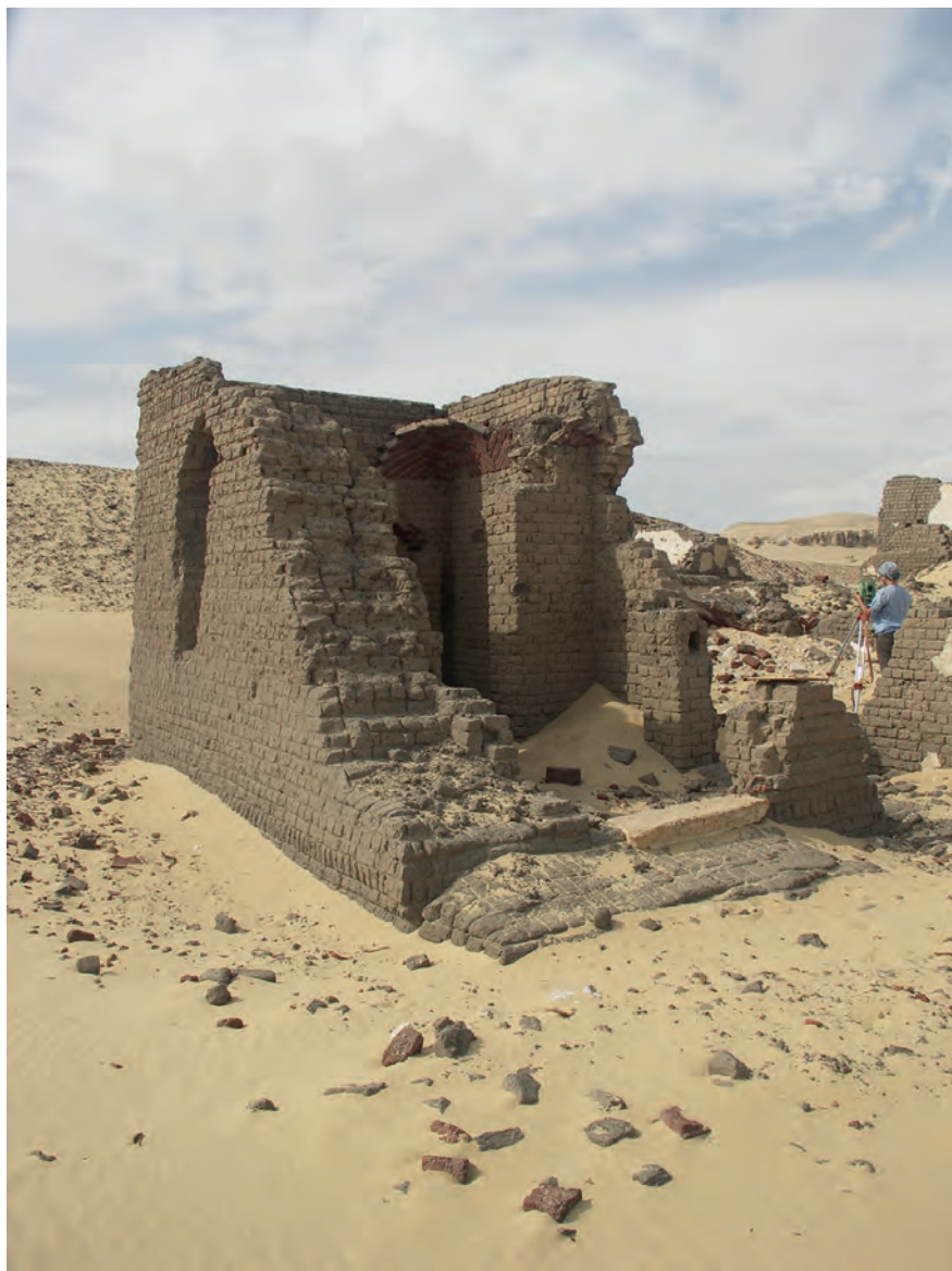
Abb. 8: GB 200, Aufnahme von Südosten; 2010
