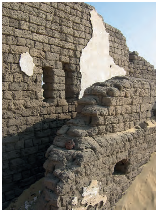
Abb. 32: GB 204.2.4, Rundbogennische mit Fensteröffnungen, Außenansicht von Süden; 2010
