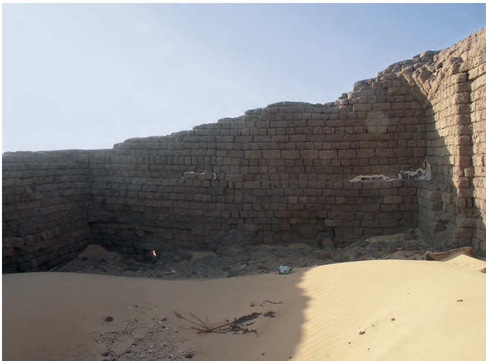
Abb. 29: GB 204.2.3, Südwand mit Grablege in Form eines Alkovens; 201
