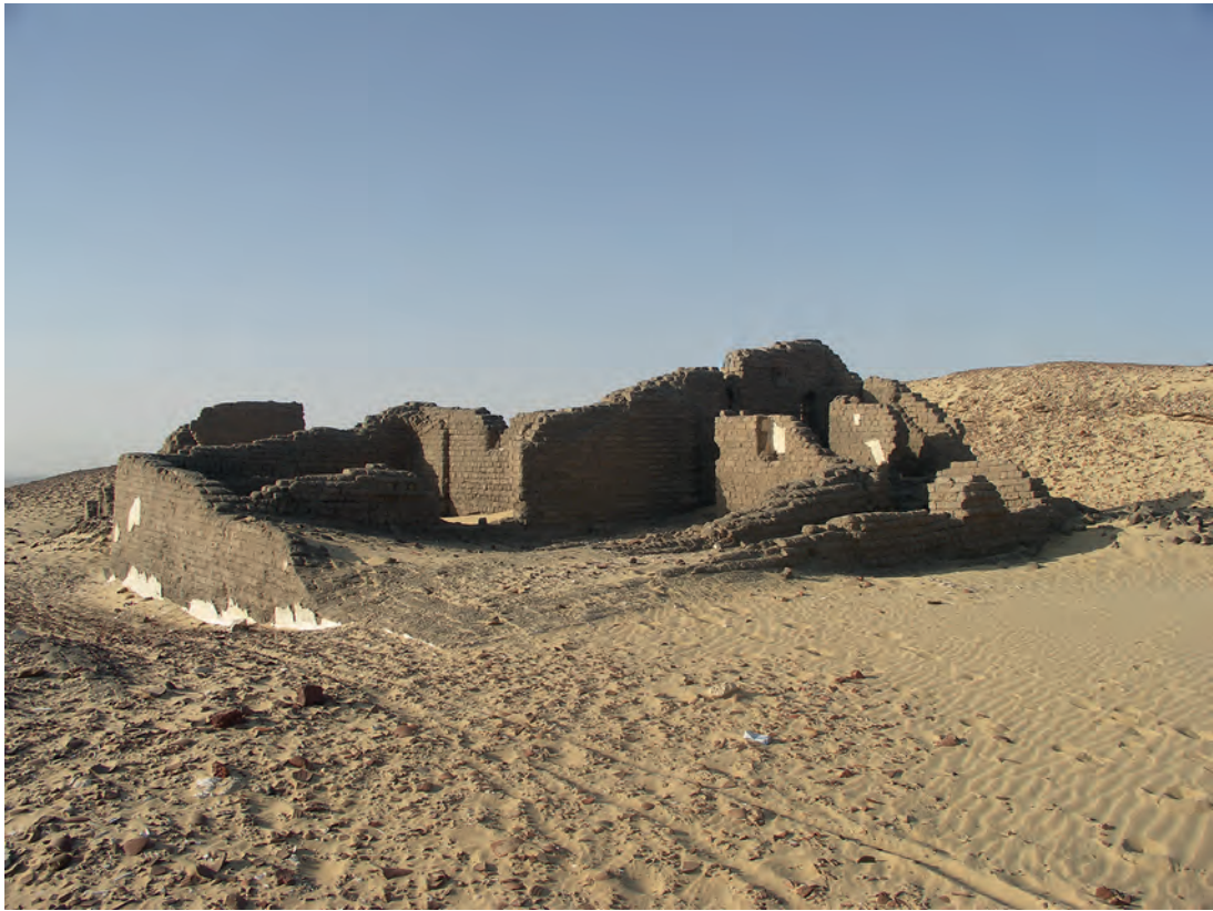
Abb. 26: GB 204, Aufnahme von Nordosten; 2010
