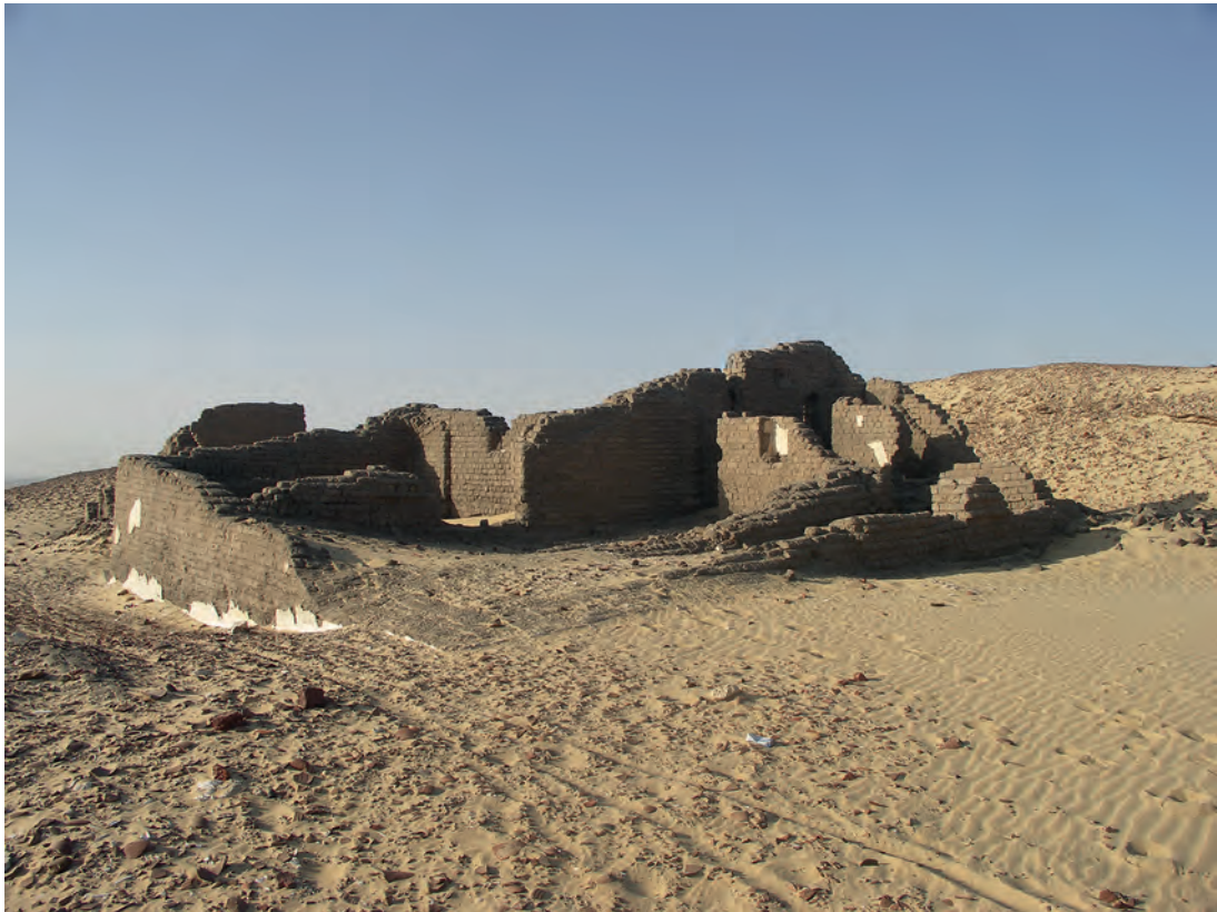
Abb. 26: GB 204, Aufnahme von Nordosten; 2010
