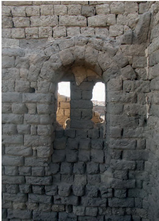
Abb. 31: GB 204.2.4, Rundbogennische mit Fensteröffnungen in der Südwand, Innenansicht von Norden; 2010
