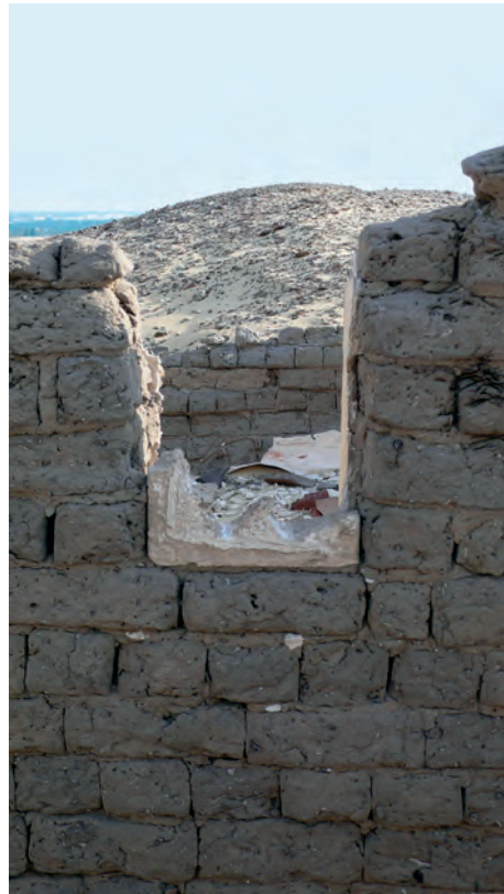
Abb. 16: GB 201.1.2, Außenansicht des Fensters von Norden mit unvollständig erhaltenem Fenstergitter aus Kalkstein; 2008
