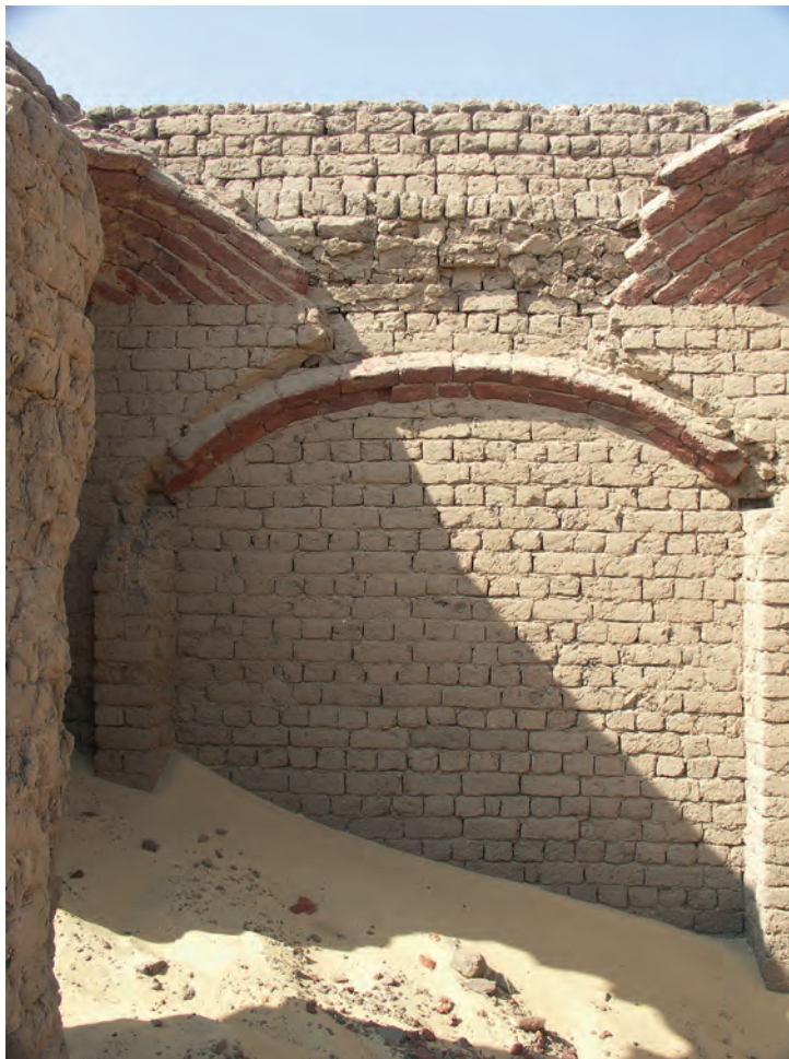
Abb. 12: GB 200.2.2, Westwand, Grablege mit Baldachinkonstruktion in Raum; 2010
