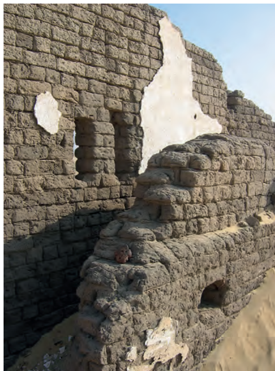
Abb. 32: GB 204.2.4, Rundbogennische mit Fensteröffnungen, Außenansicht von Süden; 2010
