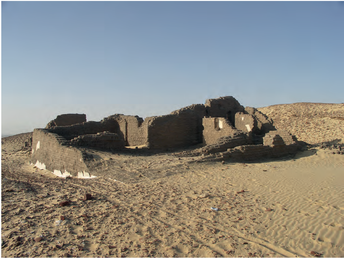
Abb. 26: GB 204, Aufnahme von Nordosten; 2010
