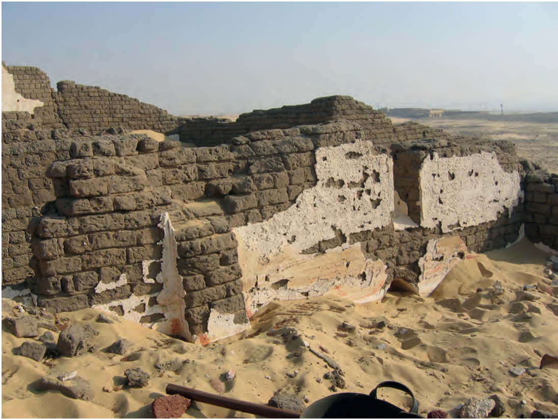
Abb. 14: GB 201, Nordwand, Ansicht von Südwesten mit Fenstern in beiden Räumen und dazwischen Wandvorlage mit Resten von Kalkputz und Malerei; 2008
