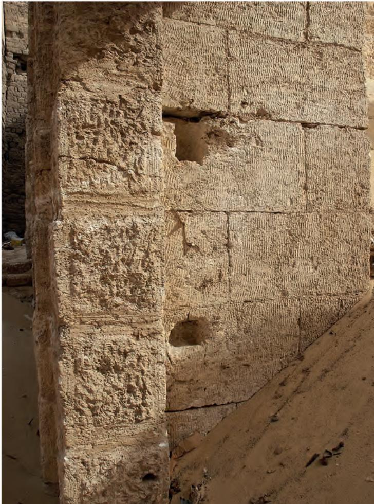
Abb. 12: Verriegelungslöcher in der Eingangstür (östliche Laibung); 2007
