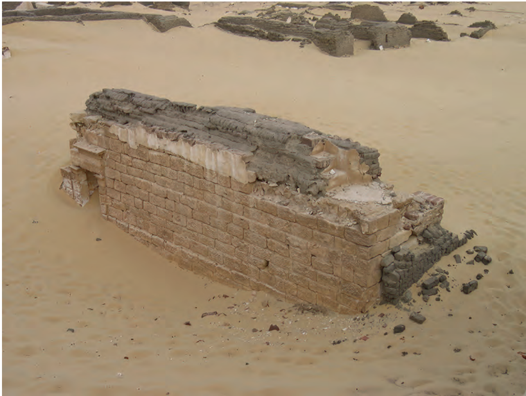
Abb. 10: Ansicht der Westwand von Südwesten; 2006
