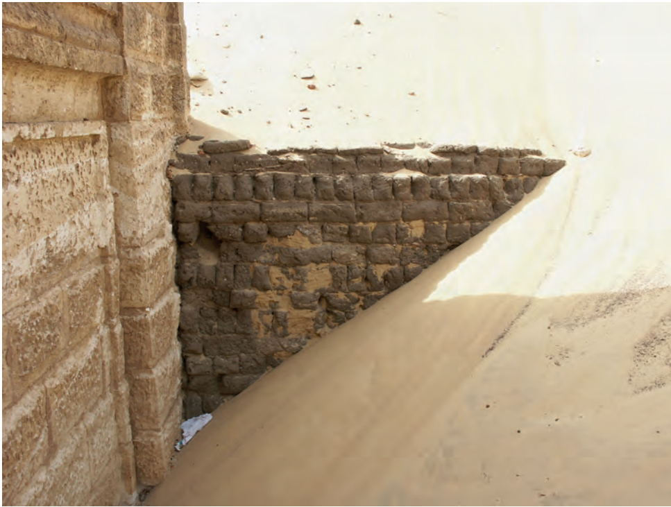
Abb. 14: Nordwestecke der Fassade mit angebaute Lehmziegelmauer; 2007
