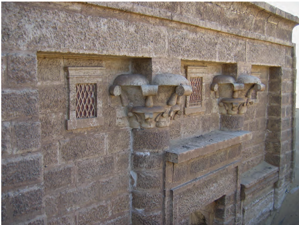
Abb. 4: Oberer Bereich der Fassade von Nordosten; 2007
