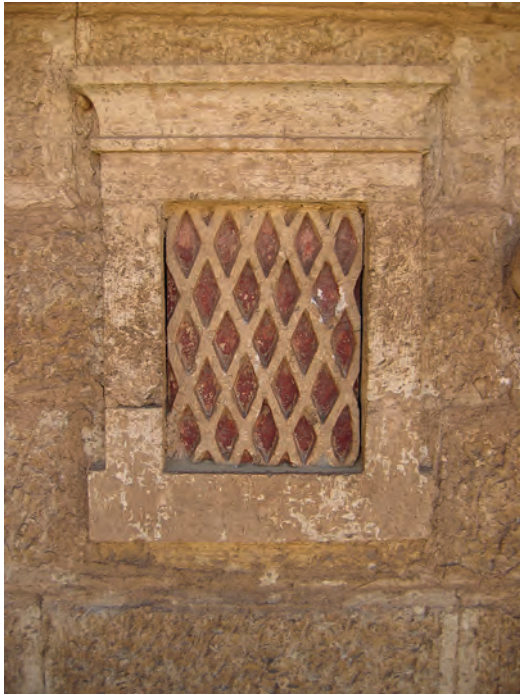
Abb. 6: Fassade, östliches Fenster; 2006
