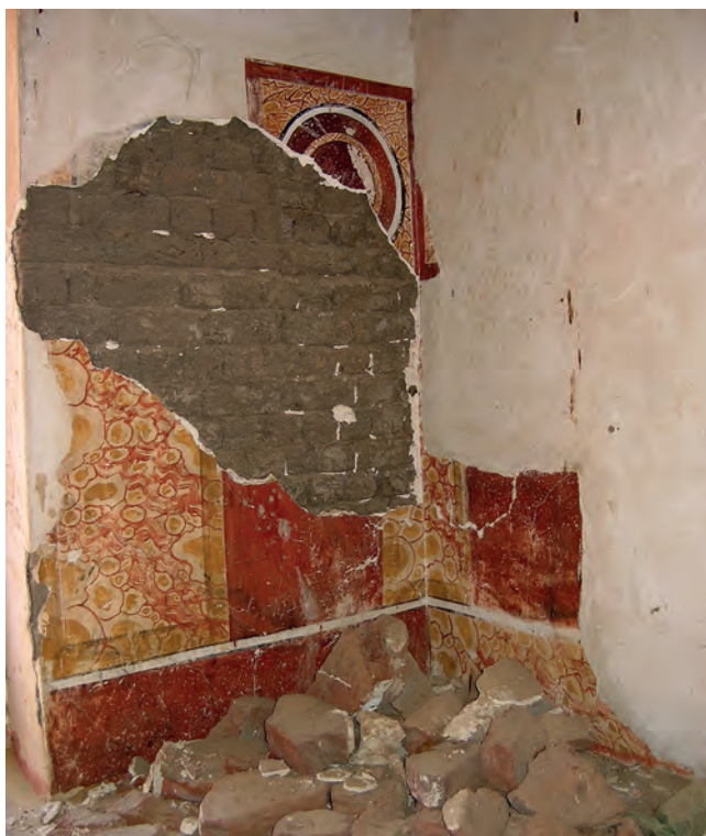
Abb. 33: GB 16, Obergeschoss, erster Raum, Nordostwand; 2005
