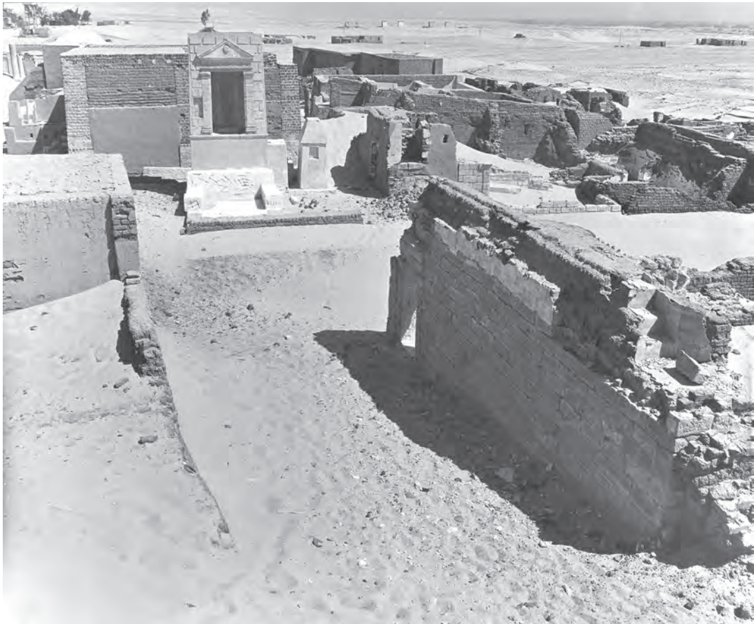
Abb. 23: Westfassade von Südwesten; 1973
