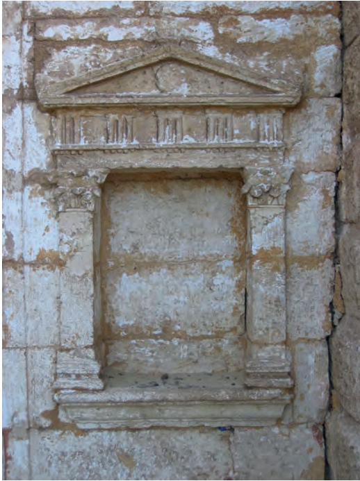
Abb. 8: GB 15, westliche Fassadennische; 2007
