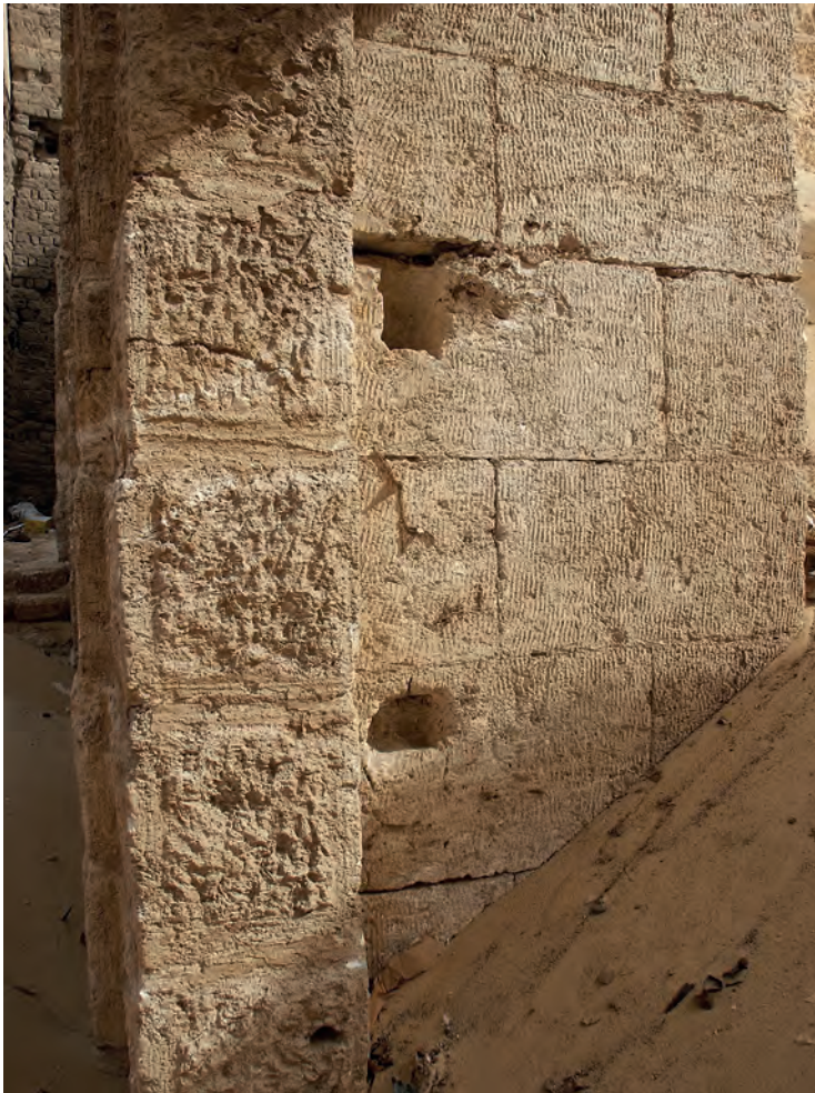
Abb. 12: Verriegelungslöcher in der Eingangstür (östliche Laibung); 2007
