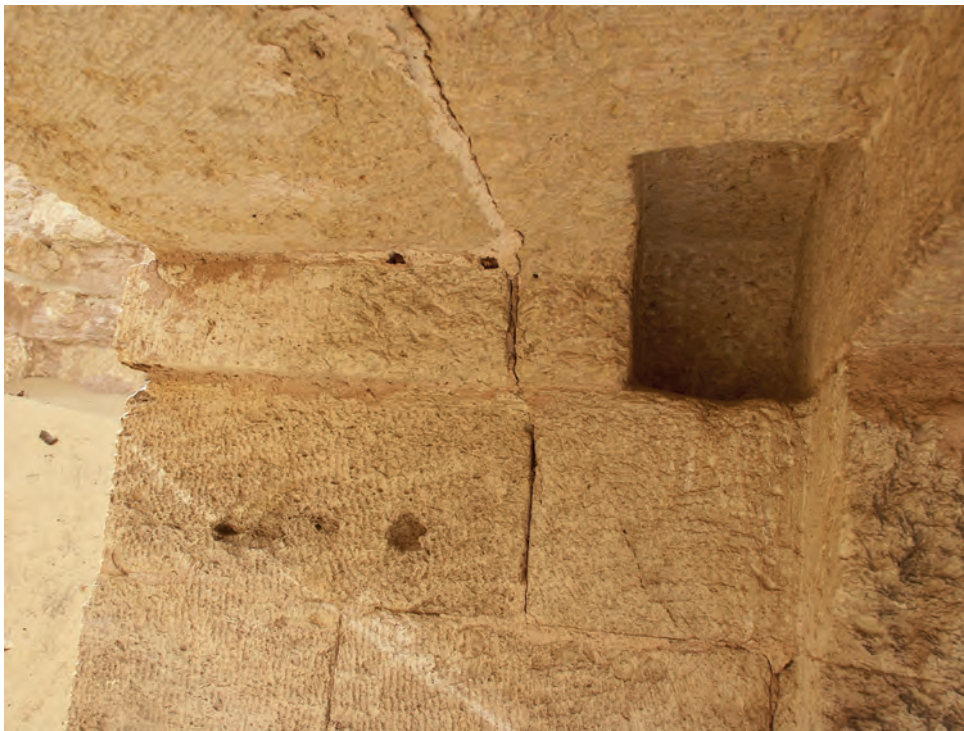
Abb. 13: Angelloch in der westlichen Ecke des Türsturzes; 2007
