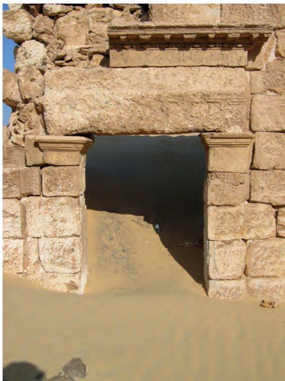
Abb. 11: Tür im nördlichen Bereich der Westwand; 2005
