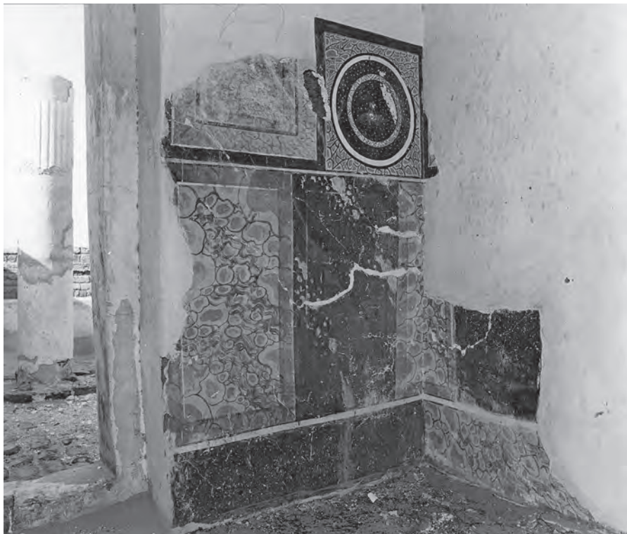
Abb. 32: GB 16, Obergeschoss, erster Raum, Nordostwand; 1973
