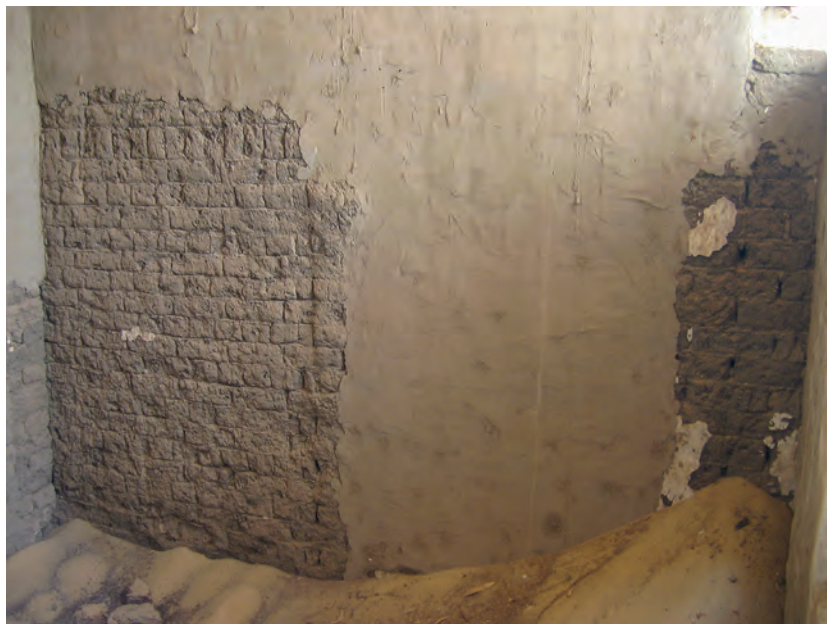
Abb. 9: GB 20, Grabfeiler des Hermokrates, Nordwand des südlich anschließenden Grabhauses; 2006
