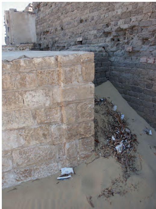
Abb. 10: GB 15, Südostecke mit Pilaster; 2007
