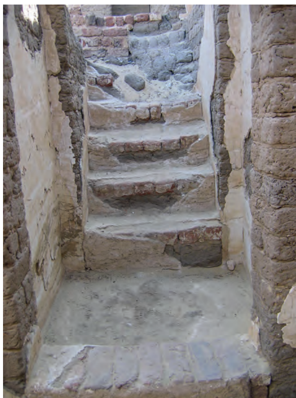
Abb. 21: GB 17, Treppe auf die Terrasse; 2006
