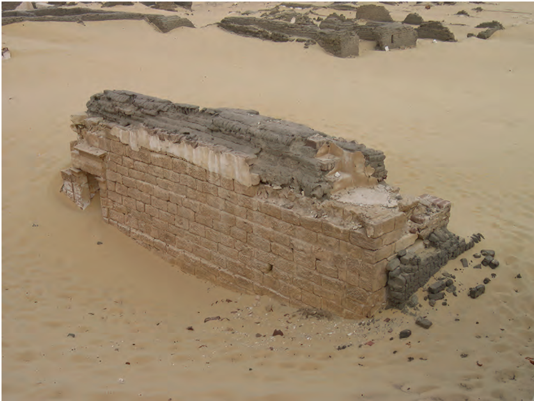
Abb. 10: Ansicht der Westwand von Südwesten; 2006
