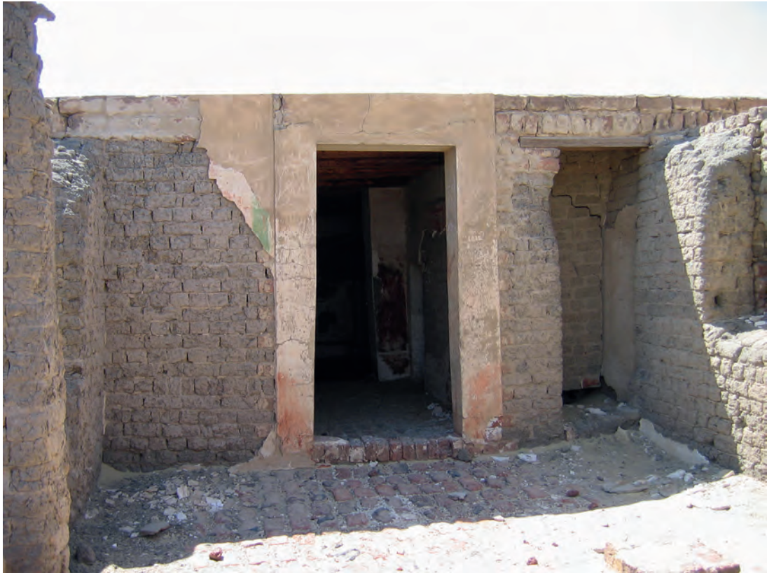
Abb. 1: GB 16, Ansicht des Obergeschosses mit Vorhalle; 2005
