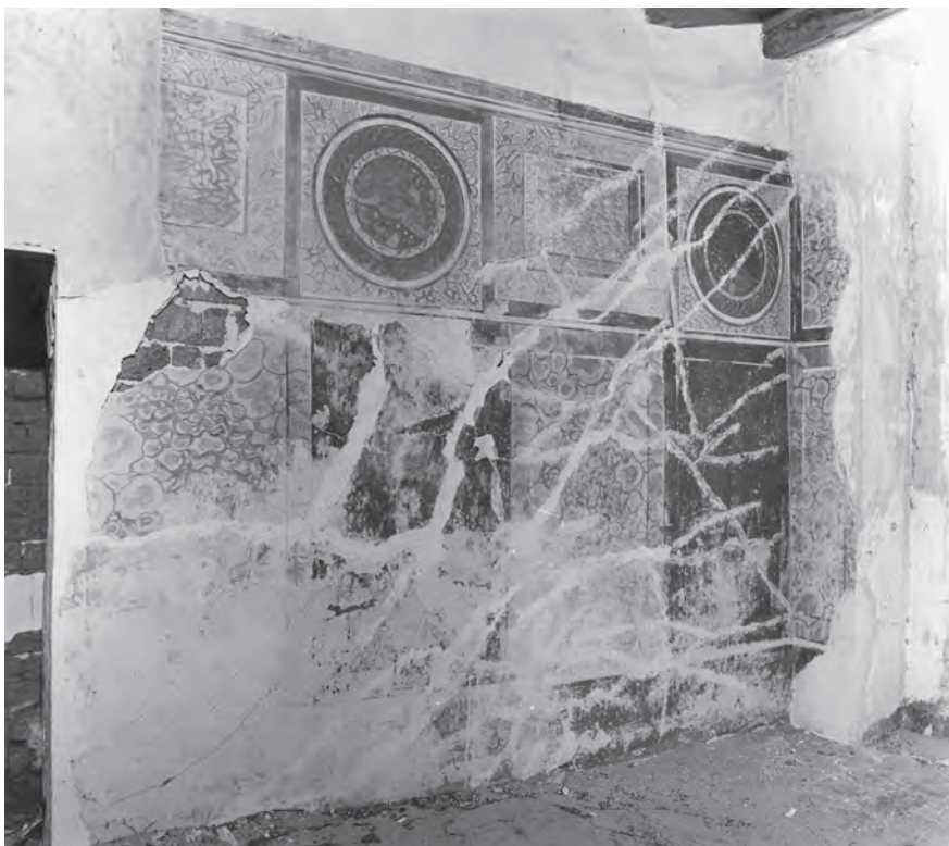
Abb. 3: GB 16, Obergeschoss, erster Raum, Westwand; 1973
