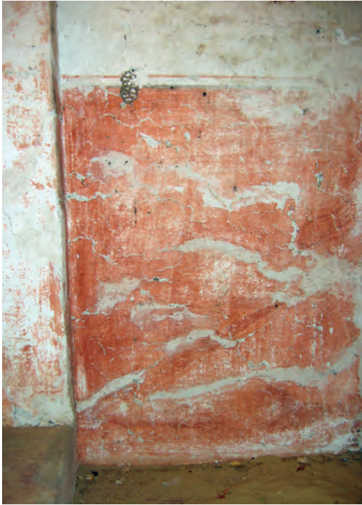
Abb. 23: GB 11, Untergeschoss, Eingangsbereich, Westwand; 2007
