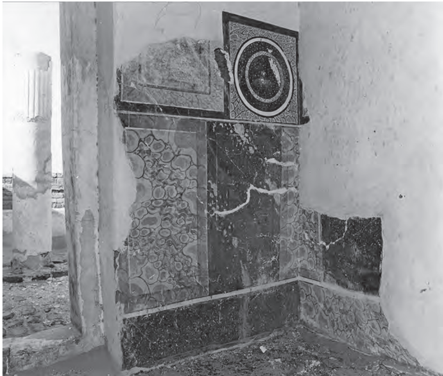
Abb. 32: GB 16, Obergeschoss, erster Raum, Nordostwand; 1973
