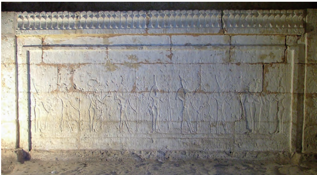
Abb. 18: GB 15, Innenraum, Ansicht der Grabeinfassung; 2007
