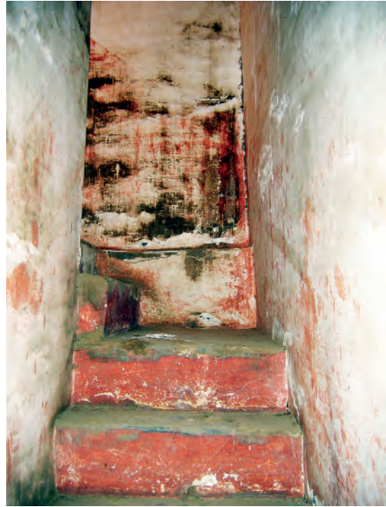
Abb. 24: GB 11, Untergeschoss, Treppe zum Obergeschoss; 2007
