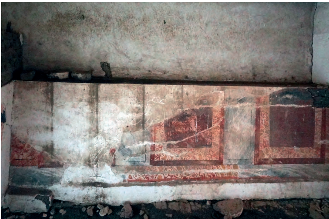
Abb. 43: GB 16, Obergeschoss, zweiter Raum, Westwand; 2019
