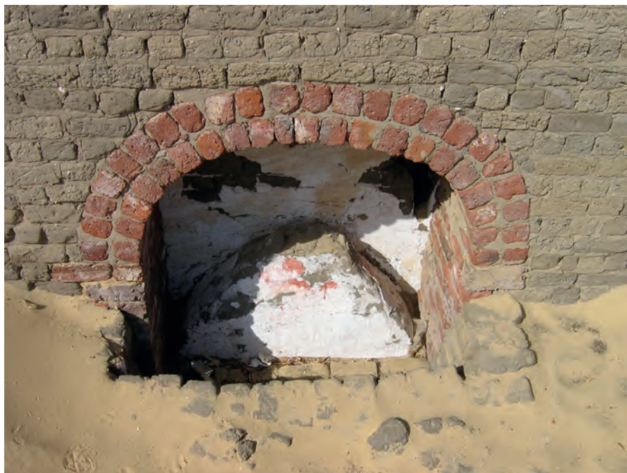
Abb. 20: GB 16, Erdgeschoss, Grabpfeiler an der östlichen Außenwand; 2007
