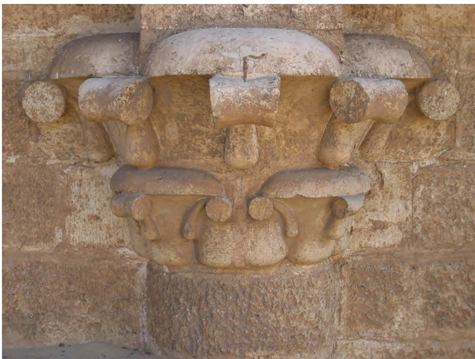
Abb. 5: Fassade, westliches Lilienkapitell; 2007
