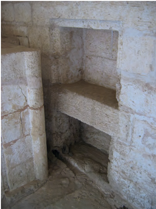
Abb. 16: GB 15, Innenraum, Westseite mit zwei übereinanderliegenden Nischen; 2007
