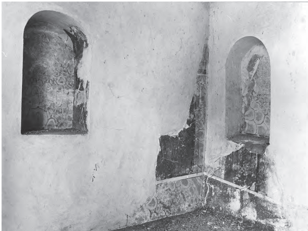
Abb. 35: GB 16, Obergeschoss, erster Raum, Ost- und östliche Südwand; 1973
