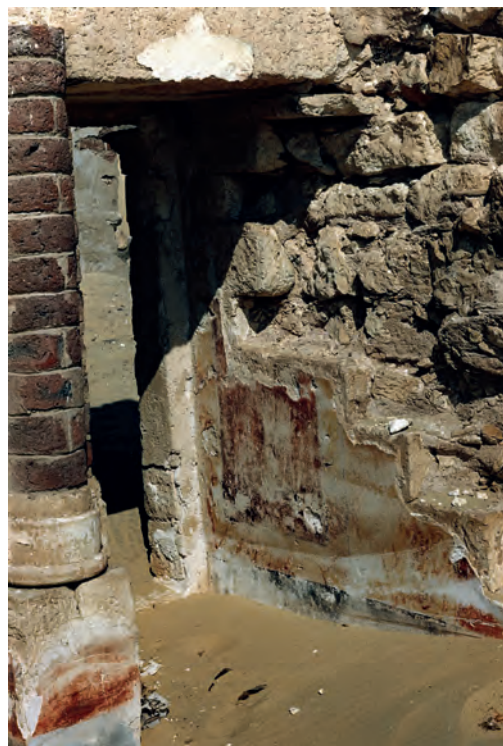
Abb. 12: Türbereich von Südosten; 1988
