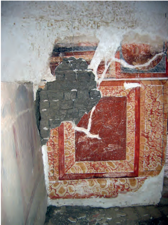
Abb. 40: GB 16, Obergeschoss, zweiter Raum, westliche Nordwand; 2005
