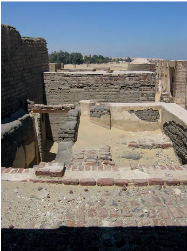
Abb. 23: GB 16, Obergeschoss, Vorhalle und Terrasse; 2005
