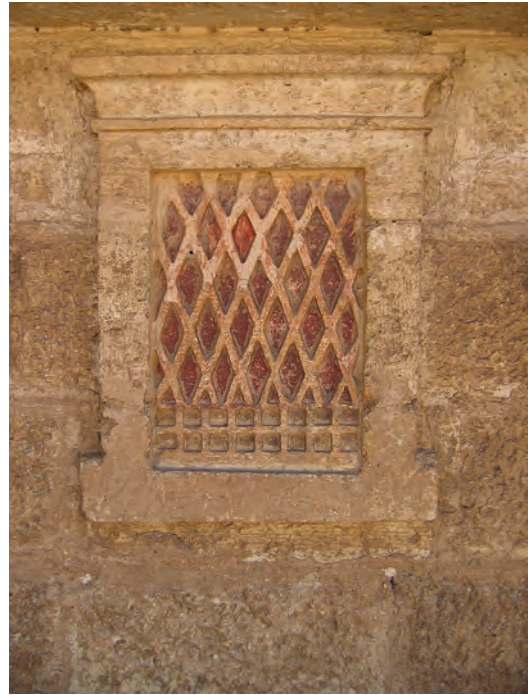
Abb. 7: Fassade, mittleres Fenster; 2006
