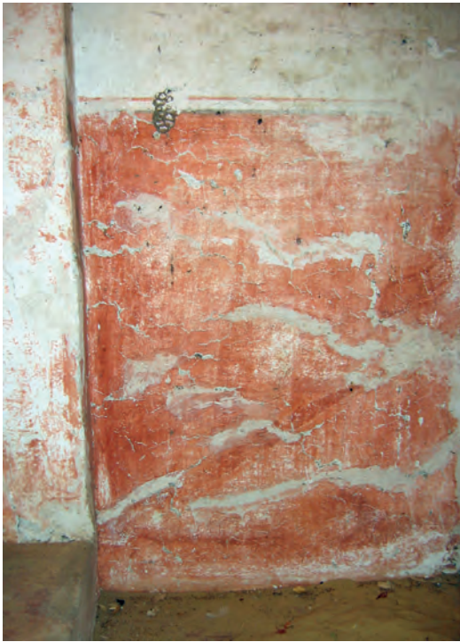
Abb. 23: GB 11, Untergeschoss, Eingangsbereich, Westwand; 2007
