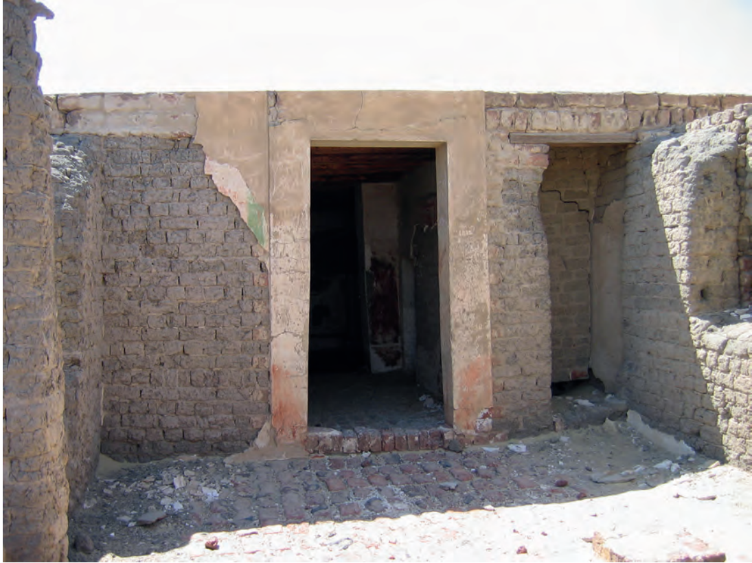
Abb. 1: GB 16, Ansicht des Obergeschosses mit Vorhalle; 2005
