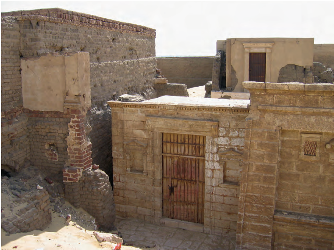
Abb. 1: GB 15, Fassade nach erneuter Freilegung; 2007
