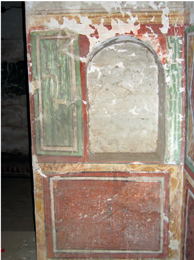
Abb. 9: GB 13, Obergeschoss, 1. Raum, westliche Südwand; 2006
