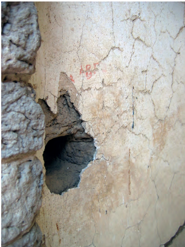
Abb. 29: GB 16, Obergeschoss, Eingang in das Treppenhaus, Ostwand, Teil einer Verschlussvorrichtung und Graffito; 2006
