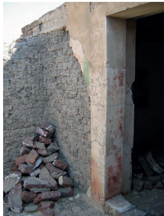
Abb. 28: GB 16, Obergeschoss, Nordwand, Reste von Wandmalerei östlich des Eingangs, Detail; 2005
