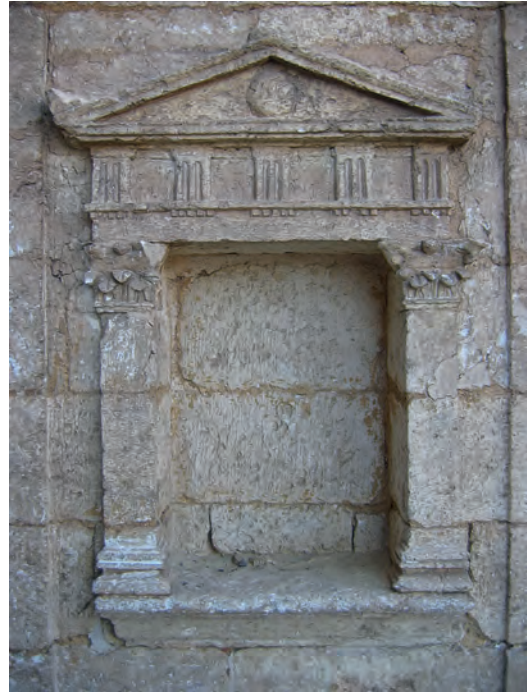
Abb. 9: GB 15, östliche Fassadennische; 2007
