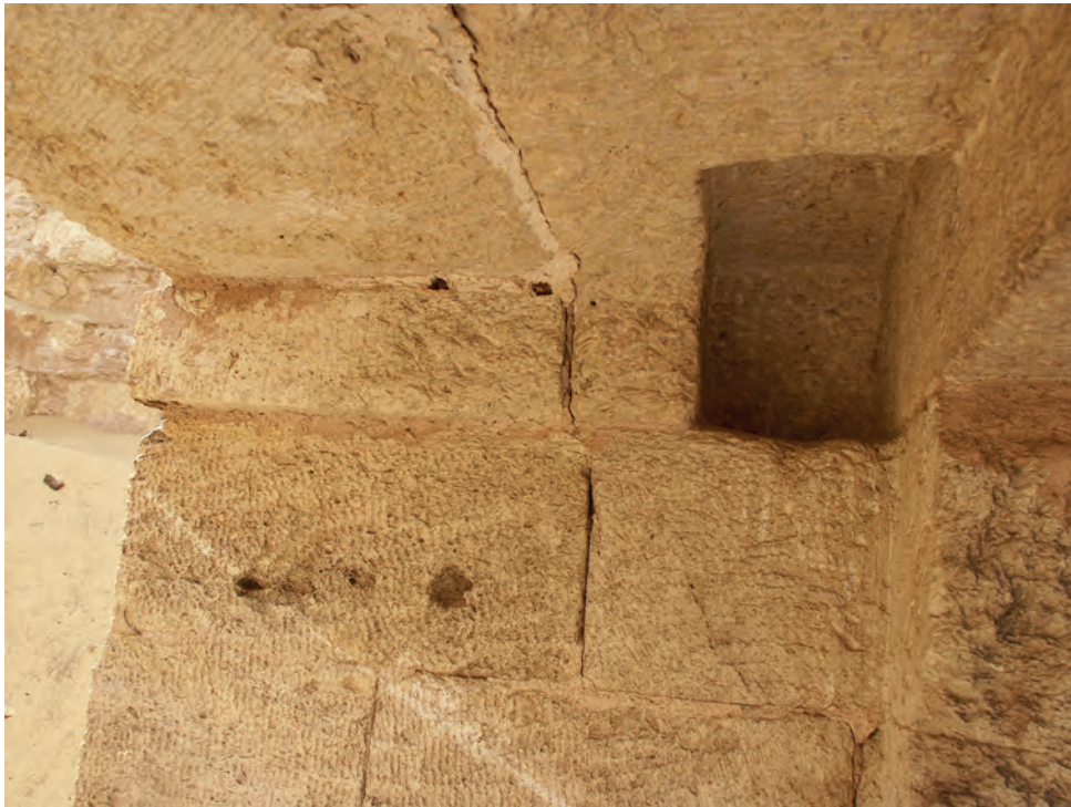
Abb. 13: Angelloch in der westlichen Ecke des Türsturzes; 2007
