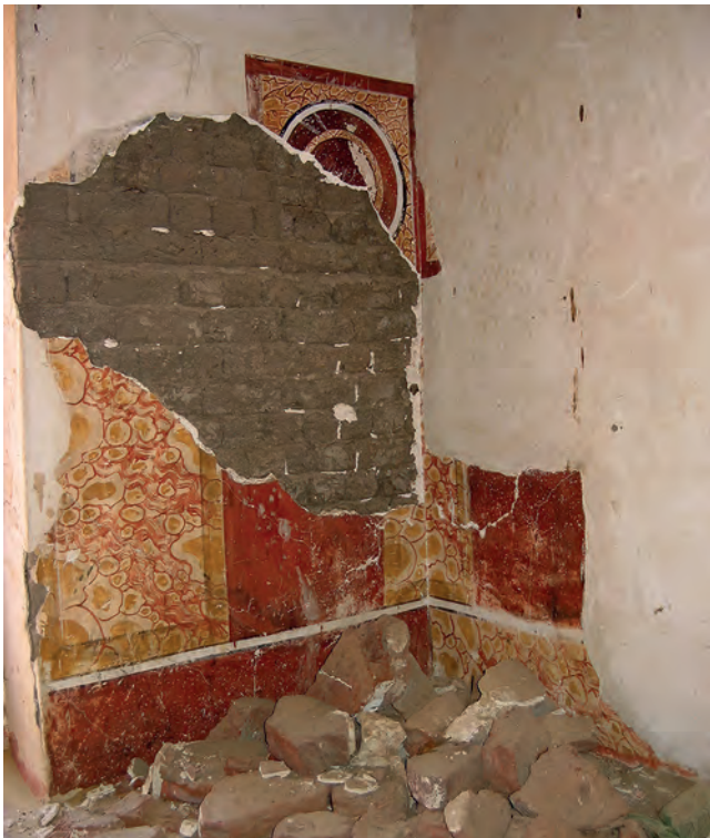
Abb. 33: GB 16, Obergeschoss, erster Raum, Nordostwand; 2005
