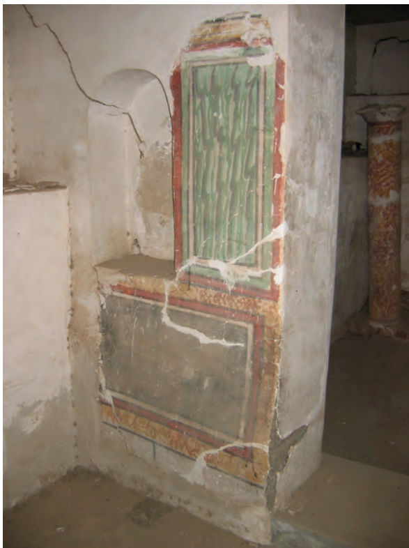
Abb. 11: GB 13, Obergeschoss, 1. Raum, östliche Süd- wand; 2006
