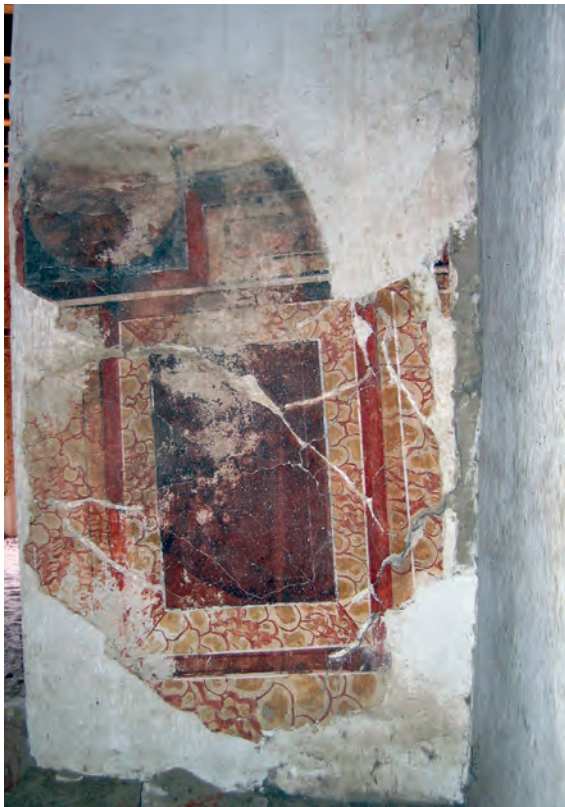
Abb. 41: GB 16, Obergeschoss, zweiter Raum, östliche Nordwand; 2005
