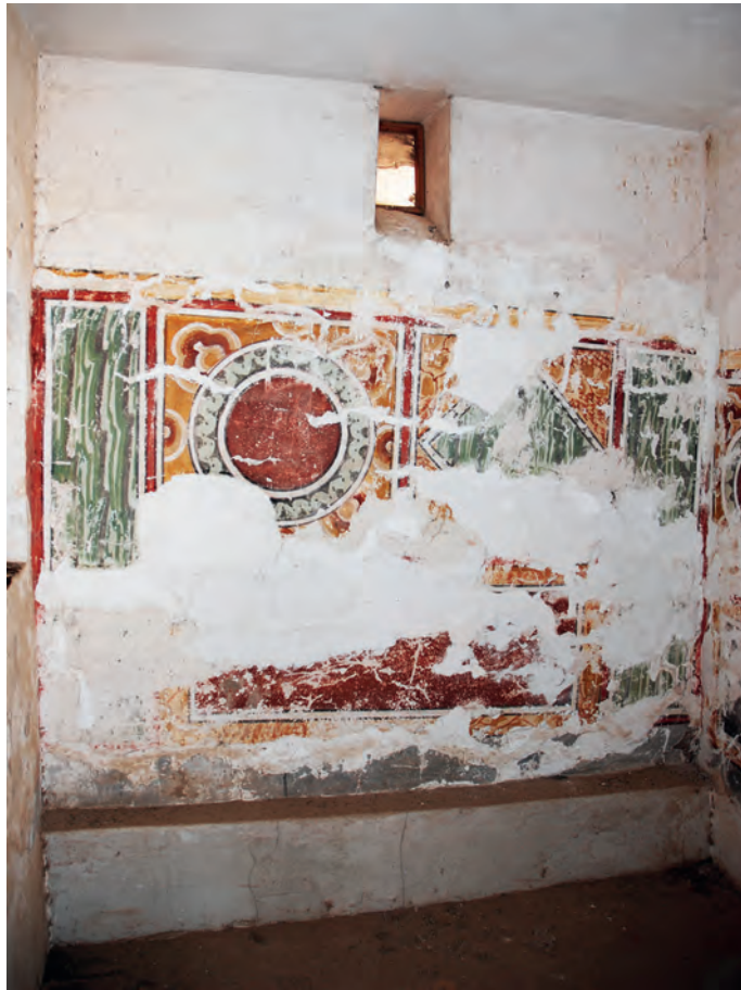
Abb. 15: GB 12, Obergeschoss, 1. Raum, Westwand; 2008
