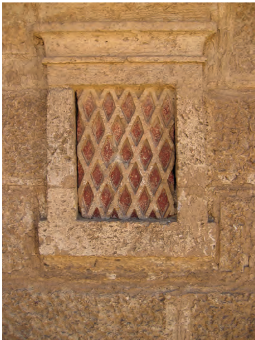
Abb. 8: Fassade, westliches Fenster; 2006
