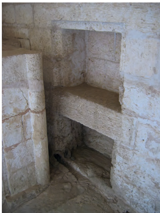
Abb. 16: GB 15, Innenraum, Westseite mit zwei übereinanderliegenden Nischen; 2007
