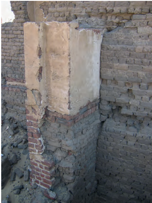
Abb. 4: Doppelstöckige Lehmziegelmauer vor dem Podium von GB 15; 2007
