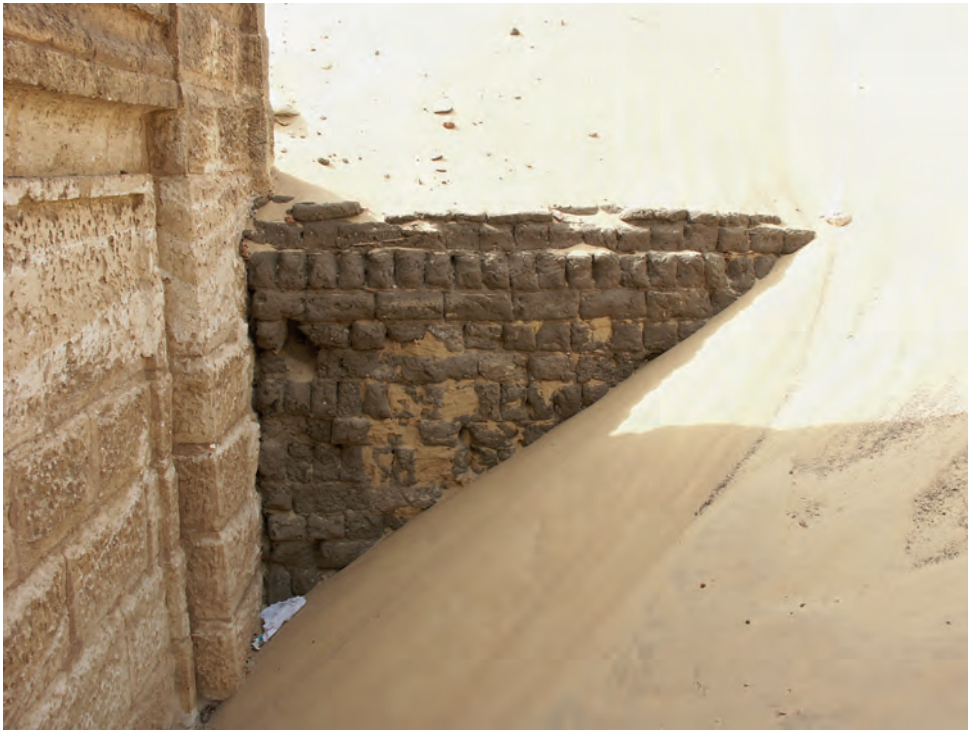
Abb. 14: Nordwestecke der Fassade mit angebaute Lehmziegelmauer; 2007
