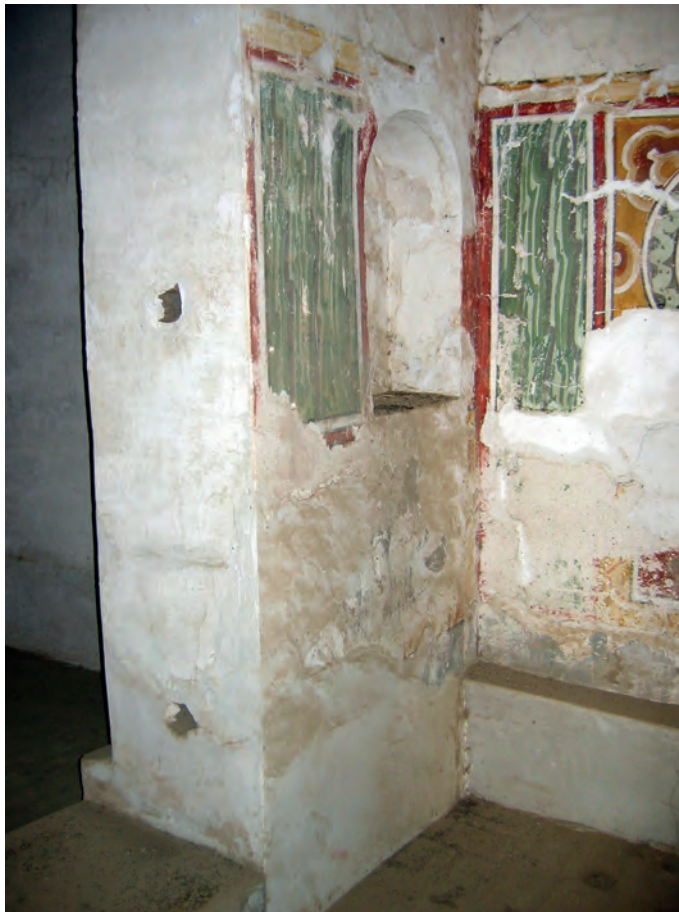
Abb. 16: GB 12, Obergeschoss, 1. Raum, westliche Südwand; 2006
