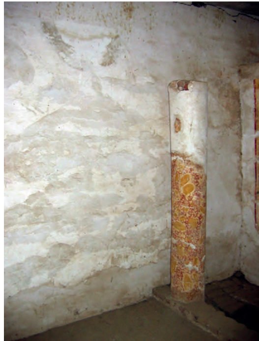
Abb. 27: GB 12, Obergeschoss, 2. Raum, Ostwand mit Girlande; 2006
