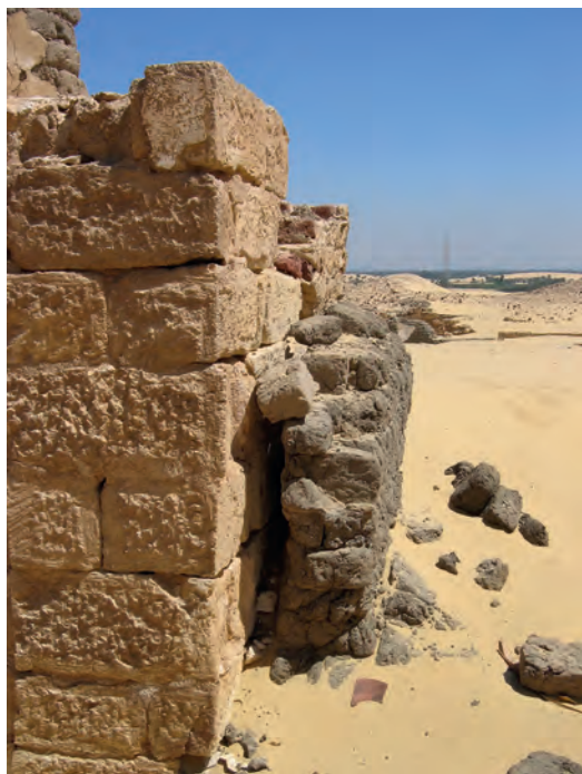
Abb. 9: Mauer aus ungebrannten Ziegeln vor der Südwand; 2005
