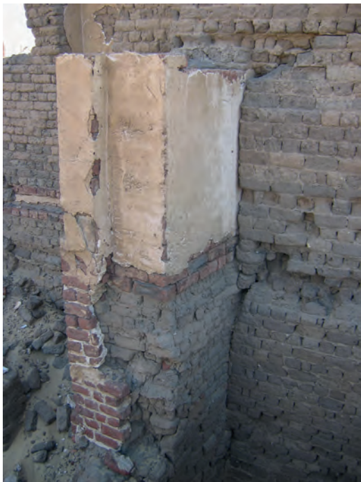
Abb. 4: Doppelstöckige Lehmziegelmauer vor dem Podium von GB 15; 2007
