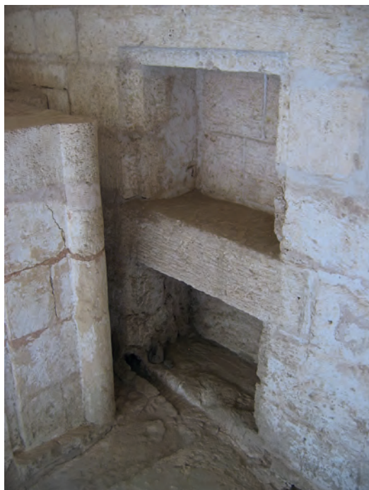
Abb. 16: GB 15, Innenraum, Westseite mit zwei übereinanderliegenden Nischen; 2007
