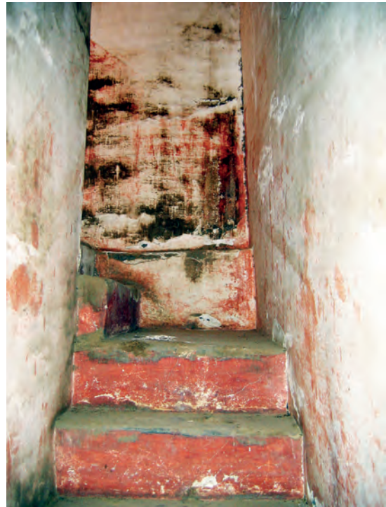
Abb. 24: GB 11, Untergeschoss, Treppe zum Obergeschoss; 2007
