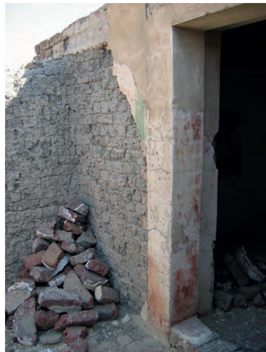
Abb. 28: GB 16, Obergeschoss, Nordwand, Reste von Wandmalerei östlich des Eingangs, Detail; 2005
