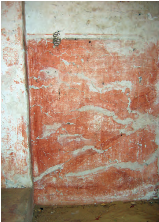
Abb. 23: GB 11, Untergeschoss, Eingangsbereich, Westwand; 2007
