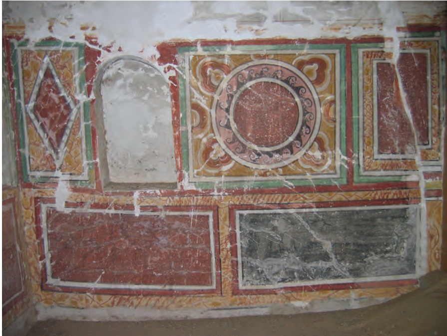
Abb. 8: GB 13, Obergeschoss, 1. Raum, Westwand; 2006
