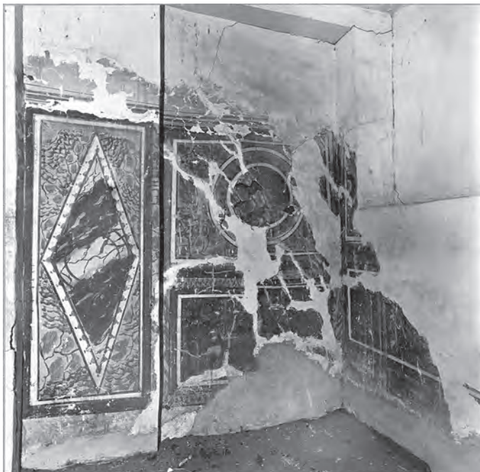
Abb. 7: GB 13, Obergeschoss, 1. Raum, Nordwand; 1973
