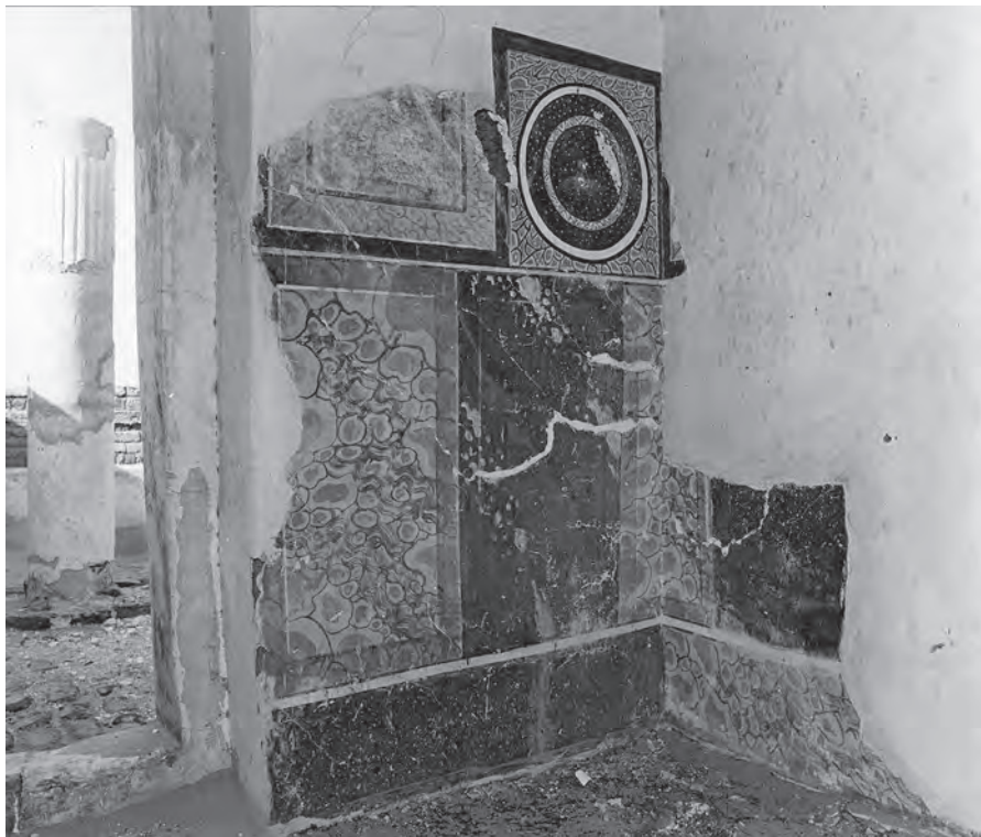
Abb. 32: GB 16, Obergeschoss, erster Raum, Nordostwand; 1973
