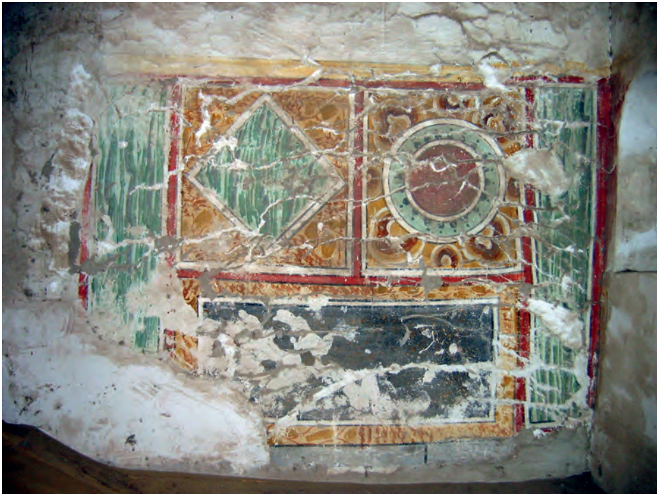
Abb. 17: GB 12, Obergeschoss, 1. Raum, Ostwand; 2008
