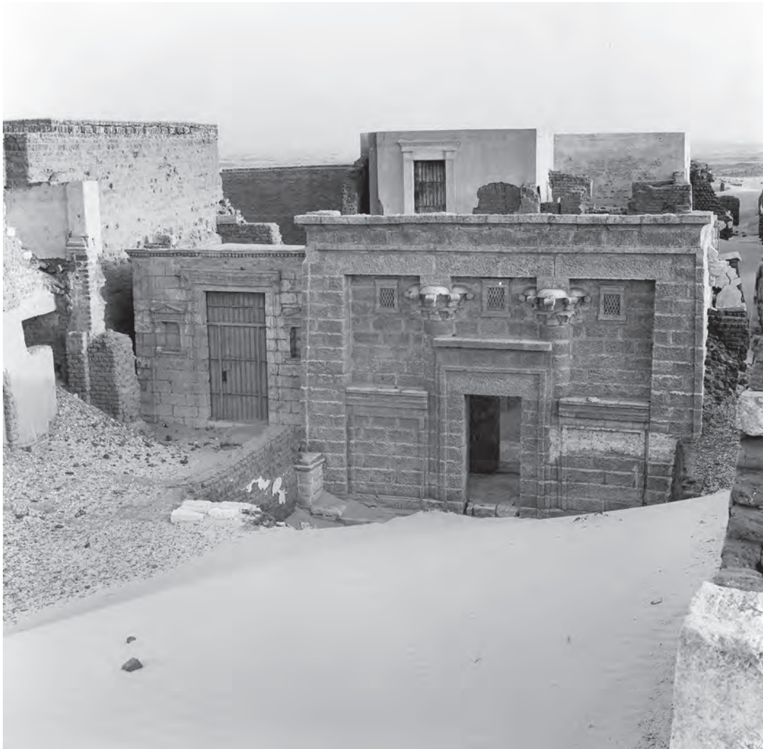
Abb. 3: Ansicht der Fassade; 1973
