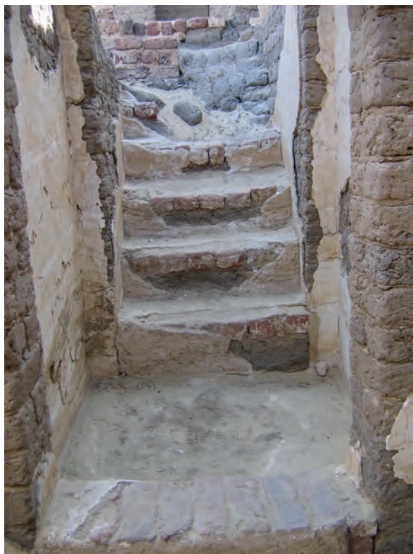
Abb. 21: GB 17, Treppe auf die Terrasse; 2006
