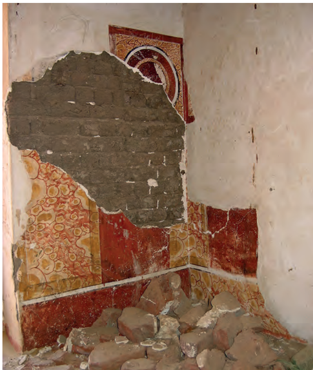
Abb. 33: GB 16, Obergeschoss, erster Raum, Nordostwand; 2005
