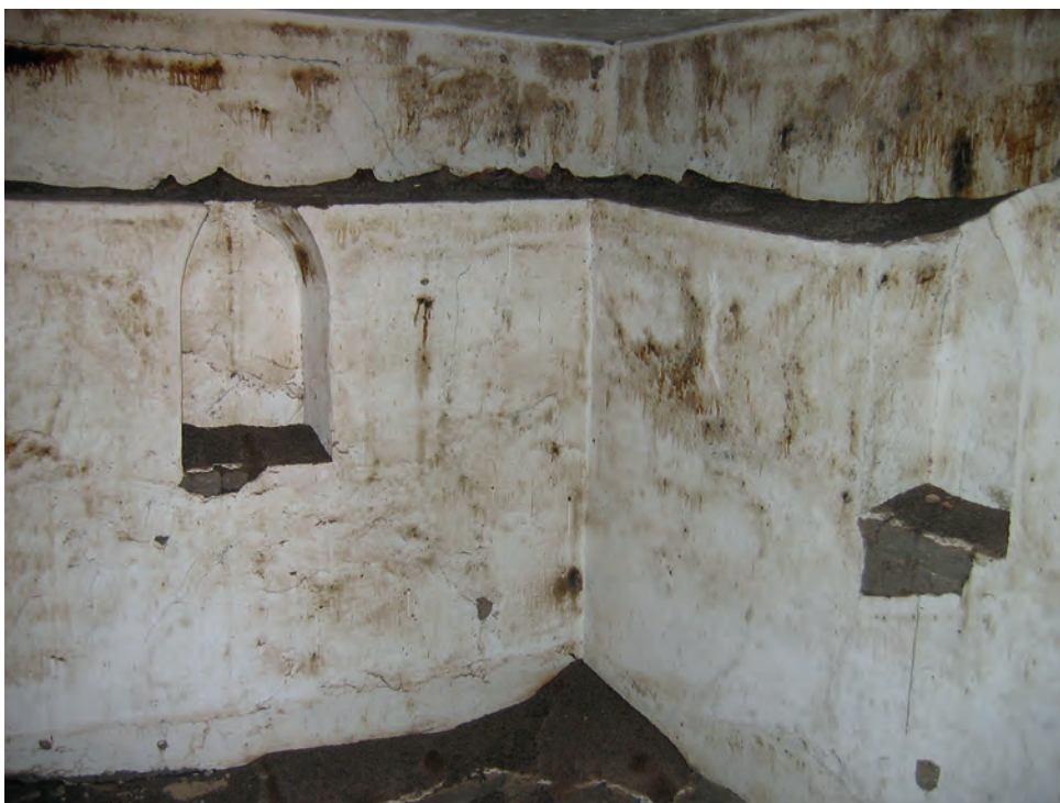
Abb. 22: GB 11, Obergeschoss, Raum mit Nischen; 2007
