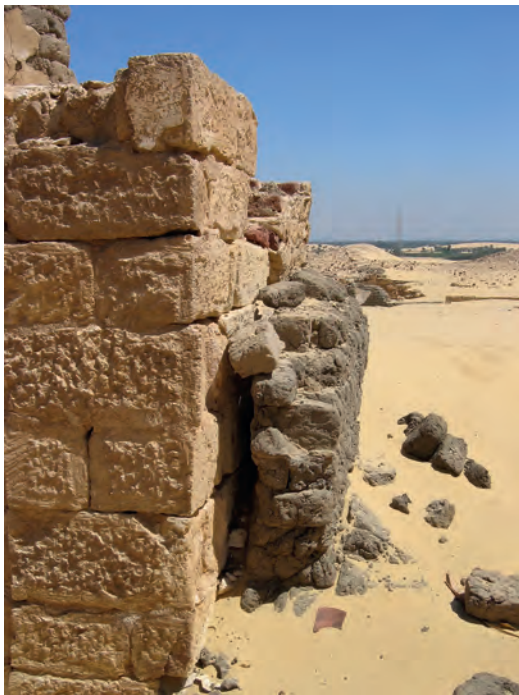
Abb. 9: Mauer aus ungebrannten Ziegeln vor der Südwand; 2005
