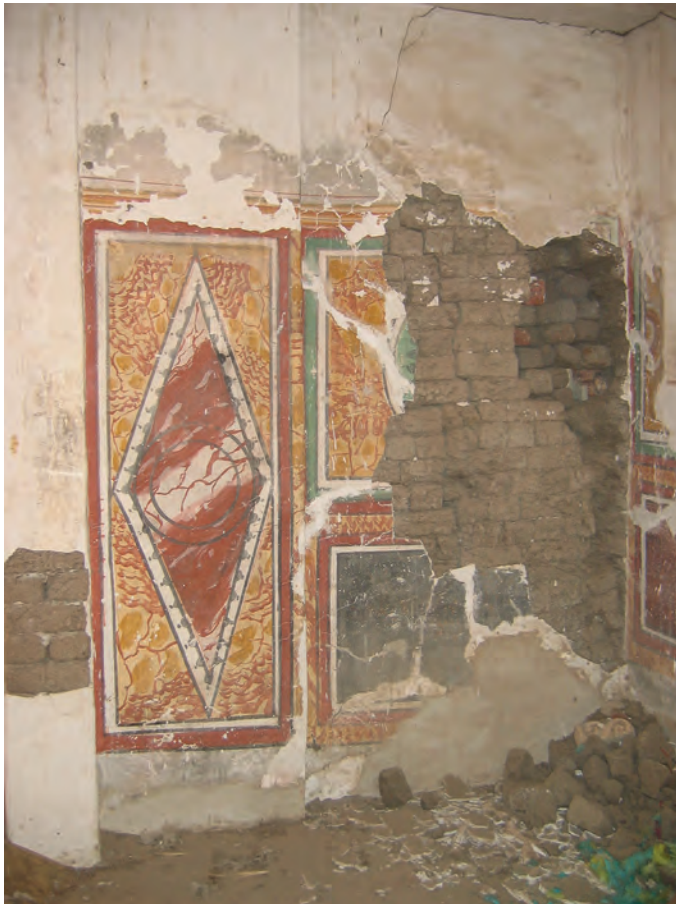
Abb. 6: GB 13, Obergeschoss, 1. Raum, Nordwand; 2006
