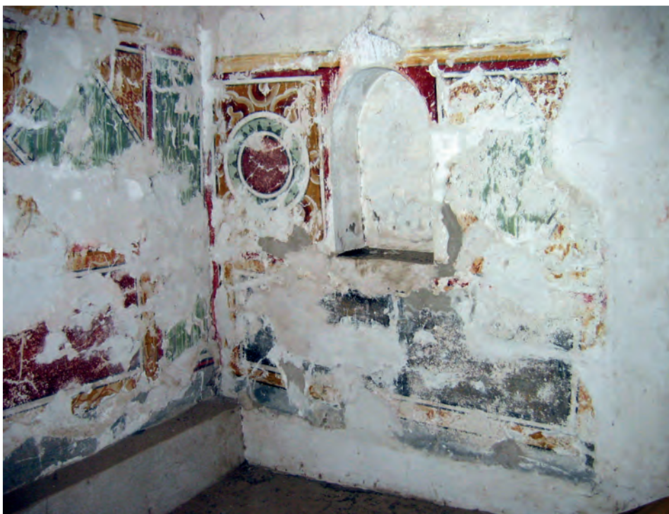
Abb. 14: GB 12, Obergeschoss, 1. Raum, Nordwand; 2006
