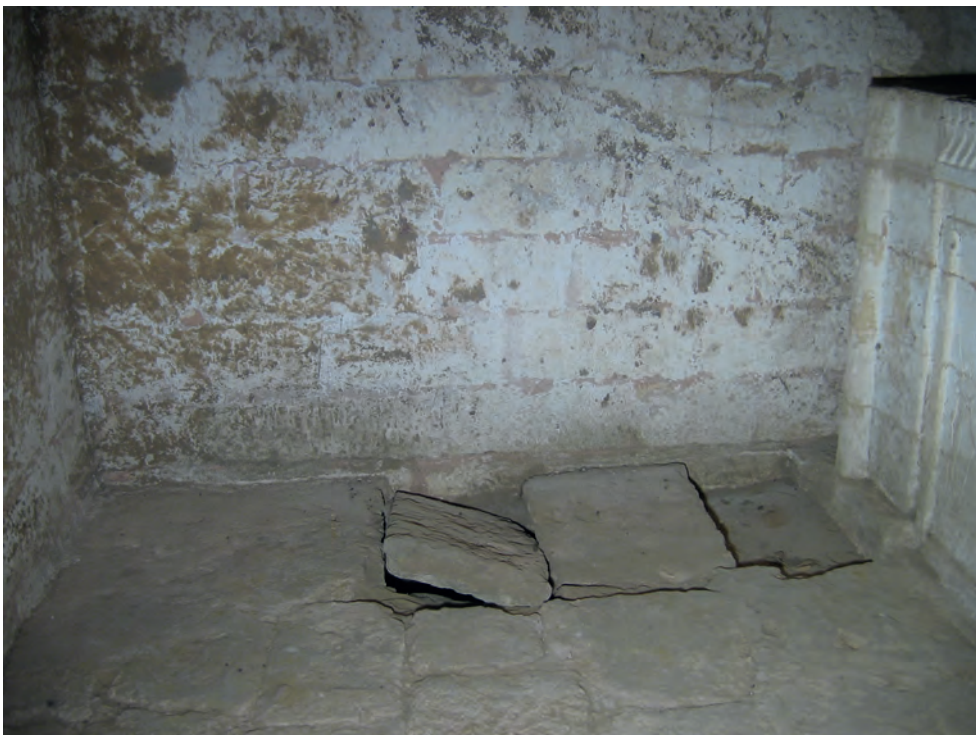
Abb. 15: GB 15, Innenraum, Ostseite mit Estrichresten und Grabgrube; 2007
