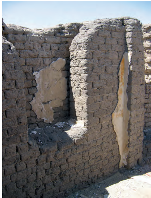
Abb. 26: GB 16, Obergeschoss, Vorhalle, Reste von Wandmalerei an der Nordwestecke; 2005
