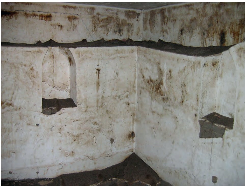
Abb. 22: GB 11, Obergeschoss, Raum mit Nischen; 2007
