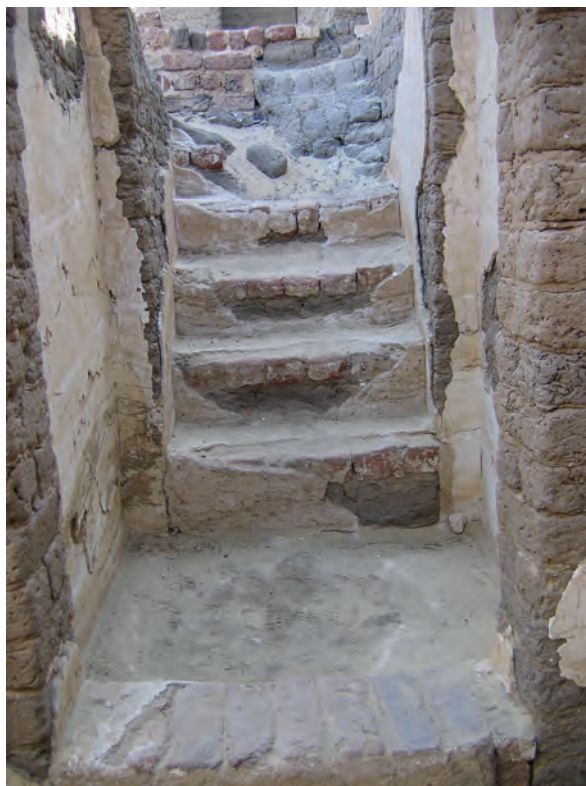
Abb. 21: GB 17, Treppe auf die Terrasse; 2006
