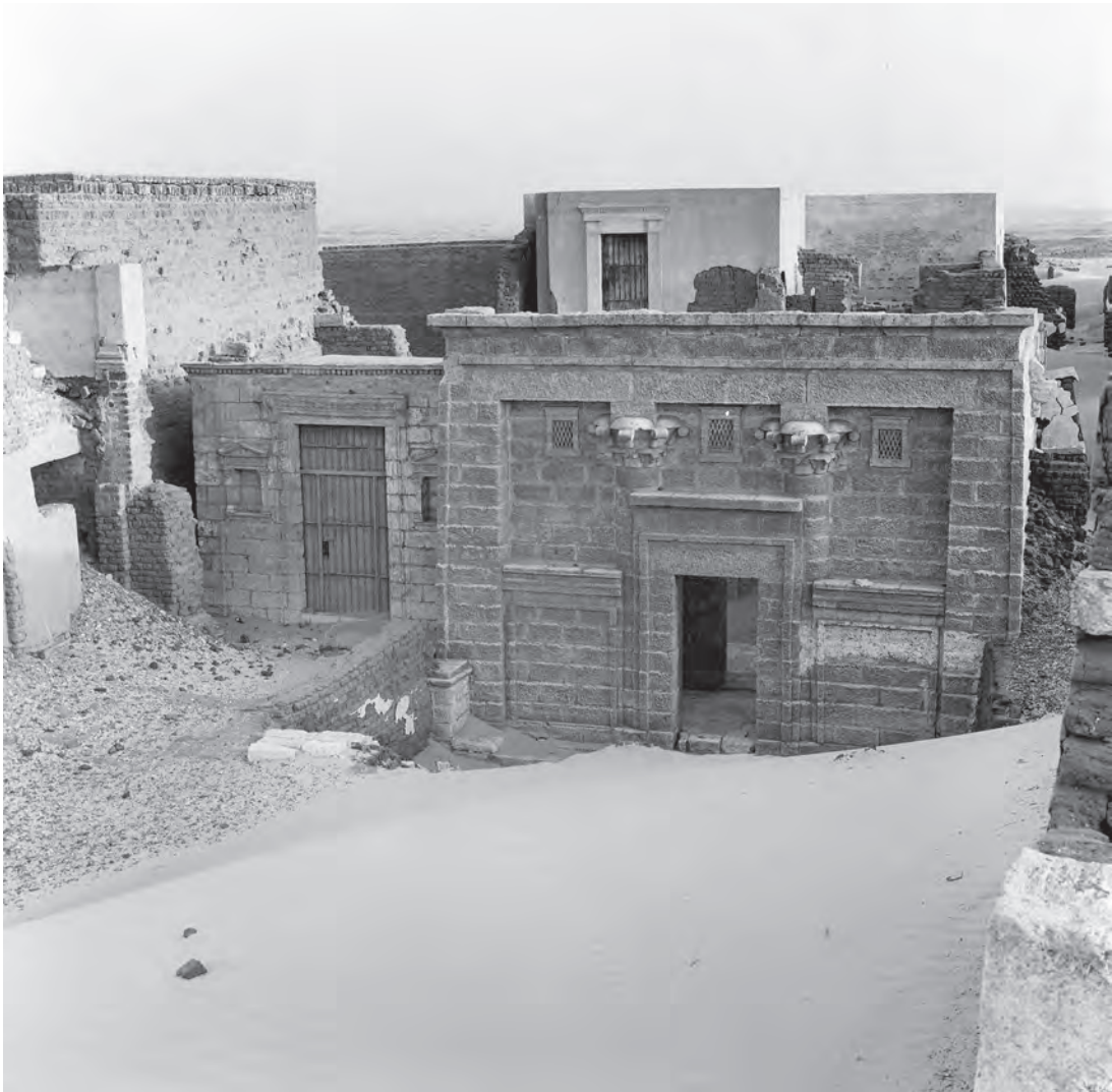
Abb. 3: Ansicht der Fassade; 1973
