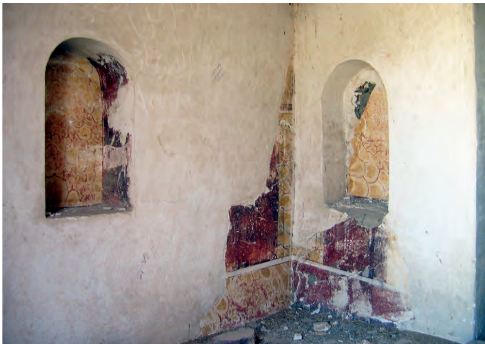
Abb. 36: GB 16, Obergeschoss, erster Raum, Ost- und östliche Südwand; 2005
