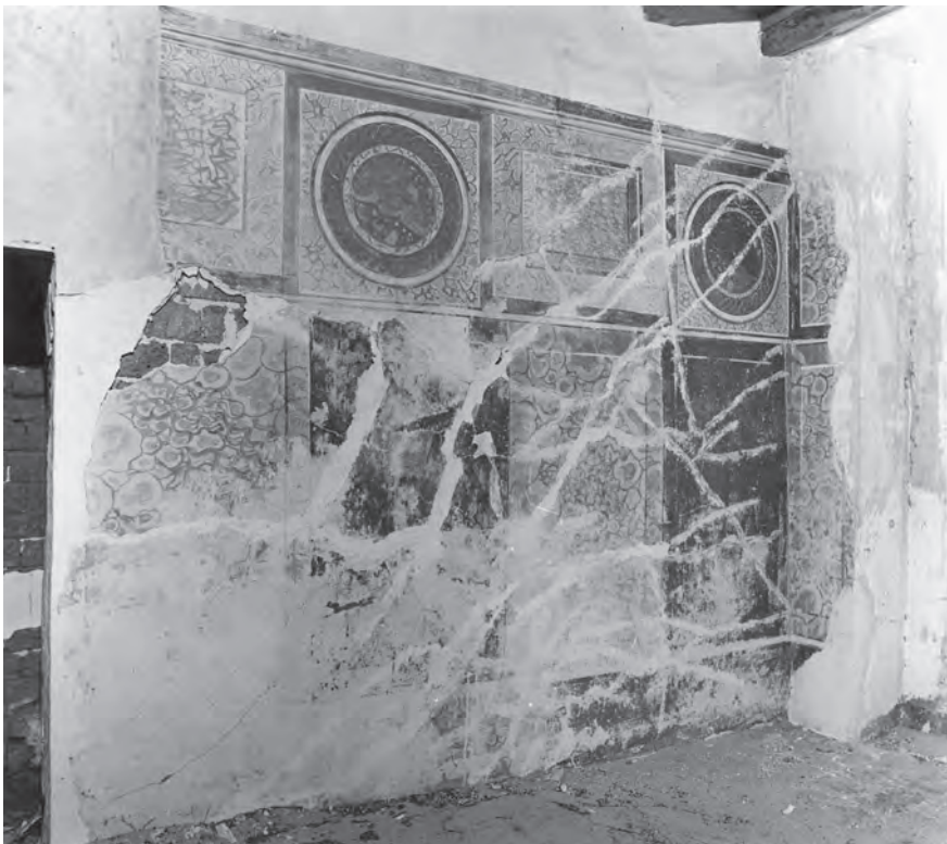
Abb. 3: GB 16, Obergeschoss, erster Raum, Westwand; 1973
