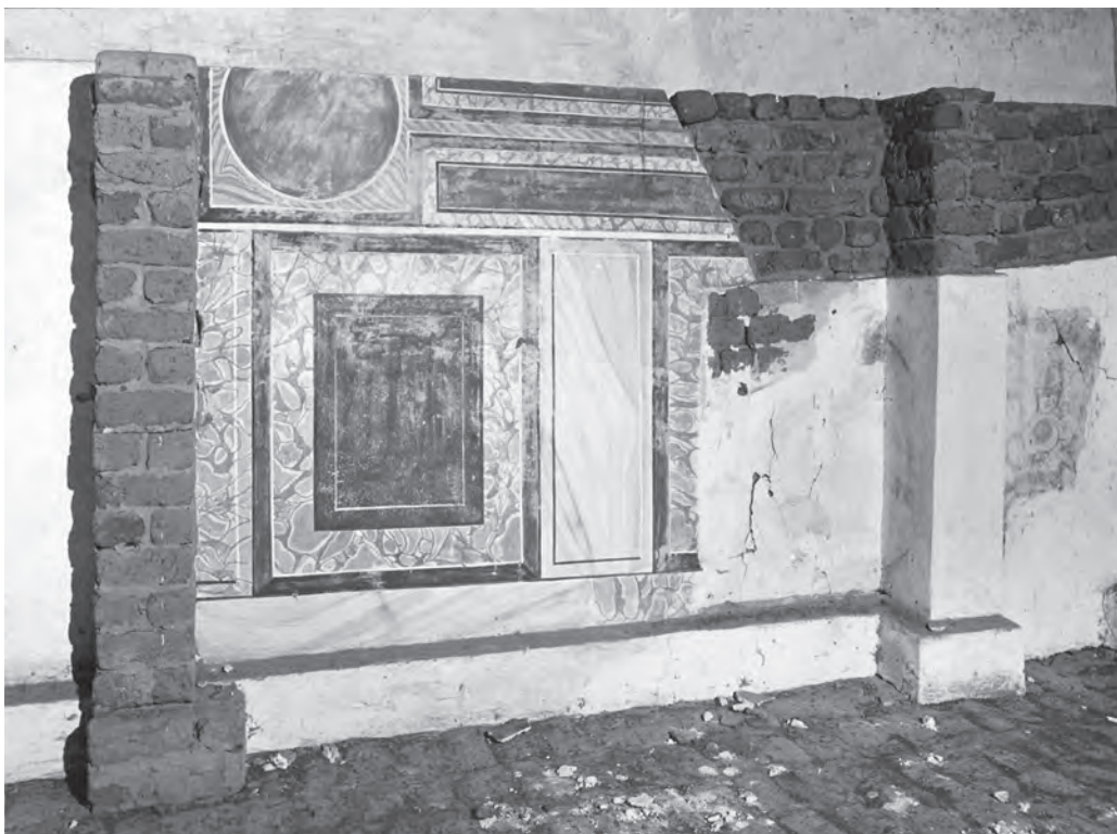
Abb. 46: GB 16, Obergeschoss, zweiter Raum, Südwand; 1973
