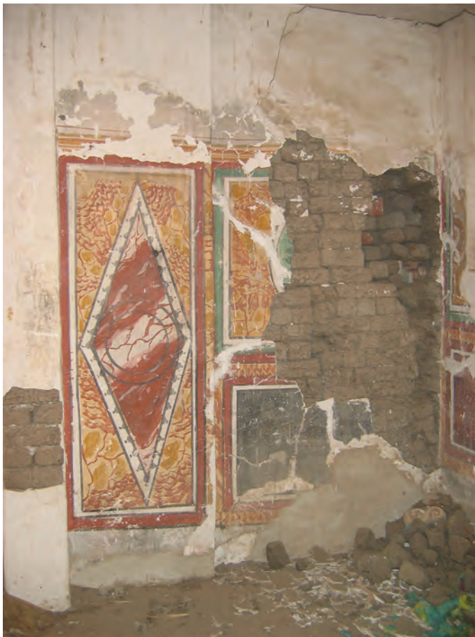
Abb. 6: GB 13, Obergeschoss, 1. Raum, Nordwand; 2006
