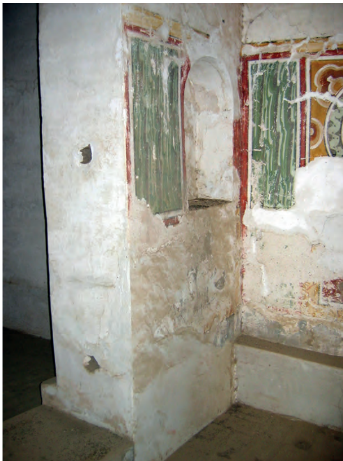
Abb. 16: GB 12, Obergeschoss, 1. Raum, westliche Südwand; 2006
