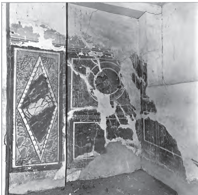
Abb. 7: GB 13, Obergeschoss, 1. Raum, Nordwand; 1973
