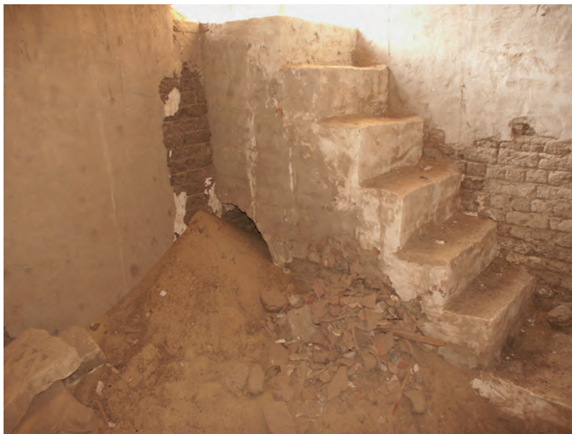
Abb. 11: GB 20, Grabfeiler des Hermokrates, Treppe an der westlichen Umfassungsmauer; 2006
