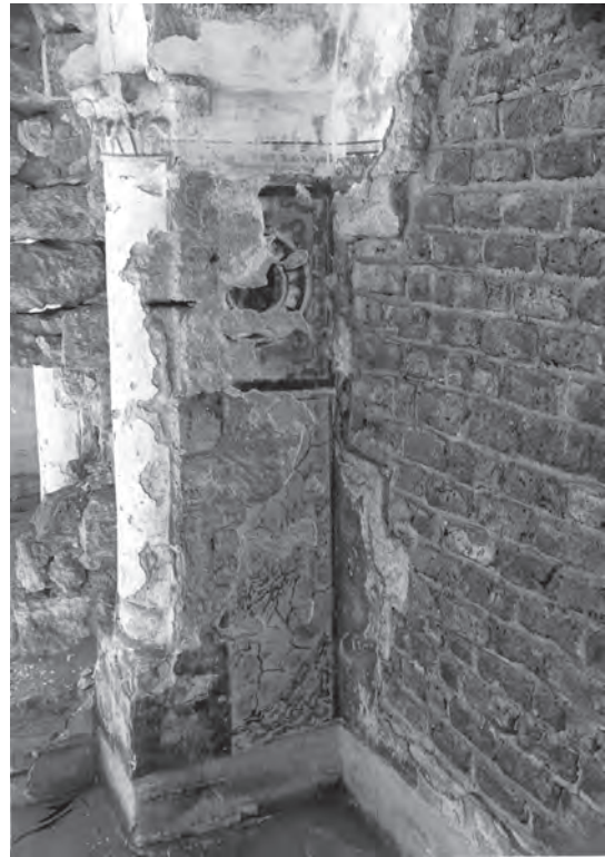
Abb. 15: Nördliches Arkosol, Nordseite des südlichen Pfeilers; 1986
