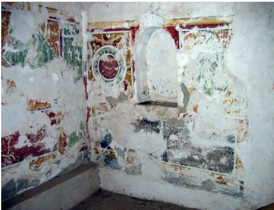
Abb. 14: GB 12, Obergeschoss, 1. Raum, Nordwand; 2006
