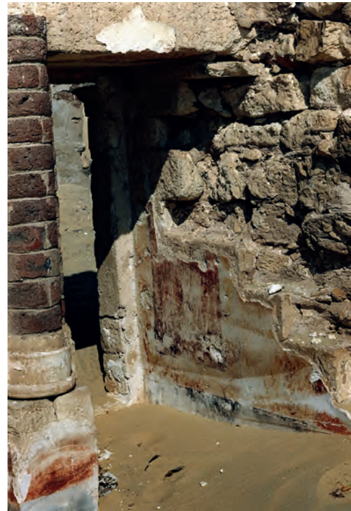
Abb. 12: Türbereich von Südosten; 1988
