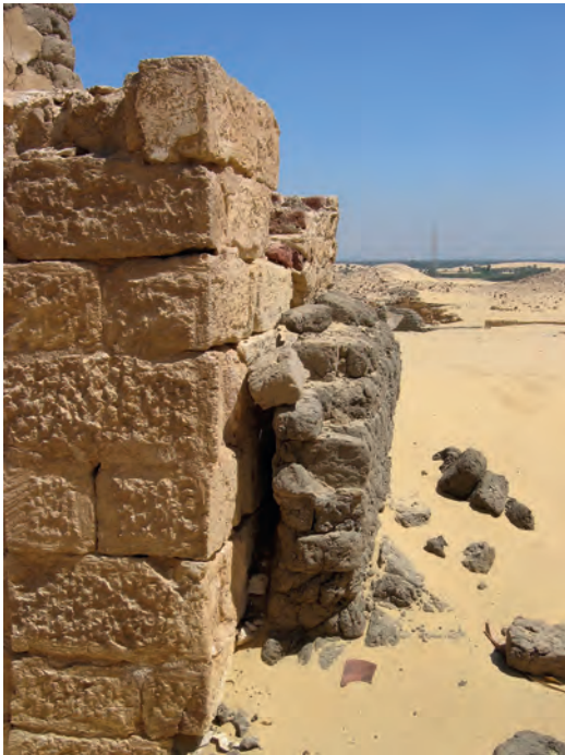
Abb. 9: Mauer aus ungebrannten Ziegeln vor der Südwand; 2005
