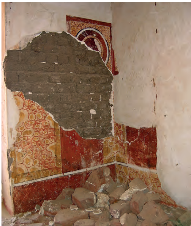
Abb. 33: GB 16, Obergeschoss, erster Raum, Nordostwand; 2005
