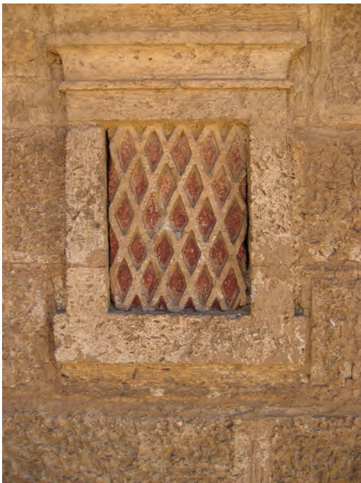
Abb. 8: Fassade, westliches Fenster; 2006
