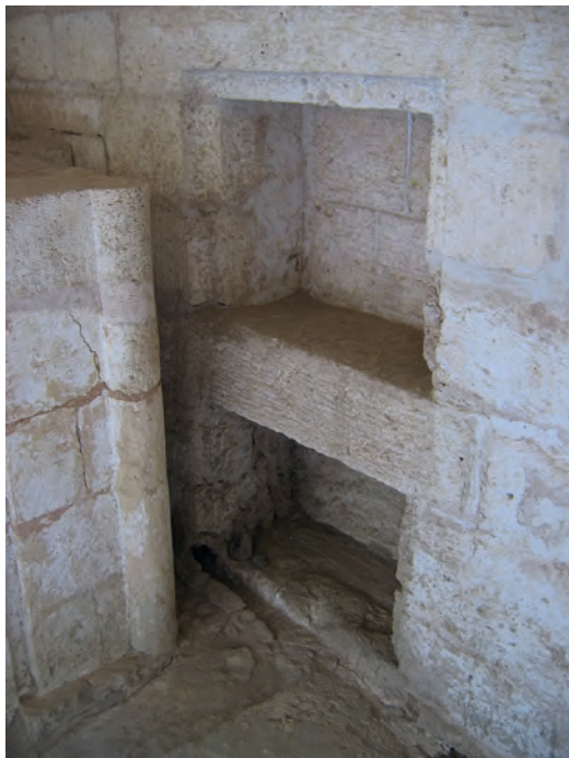
Abb. 16: GB 15, Innenraum, Westseite mit zwei übereinanderliegenden Nischen; 2007
