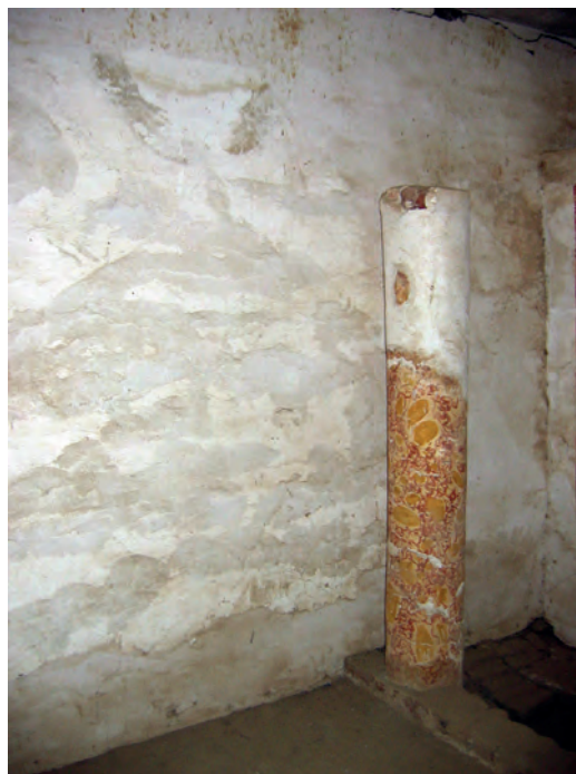
Abb. 27: GB 12, Obergeschoss, 2. Raum, Ostwand mit Girlande; 2006
