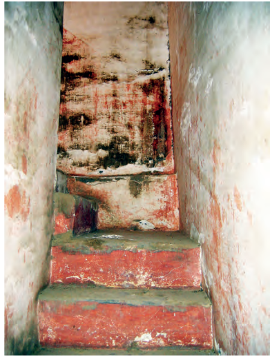
Abb. 24: GB 11, Untergeschoss, Treppe zum Obergeschoss; 2007
