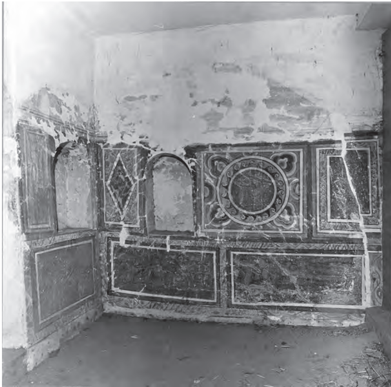
Abb. 10: GB 13, Obergeschoss, 1. Raum, Westwand und westliche Süd- wand; 1973
