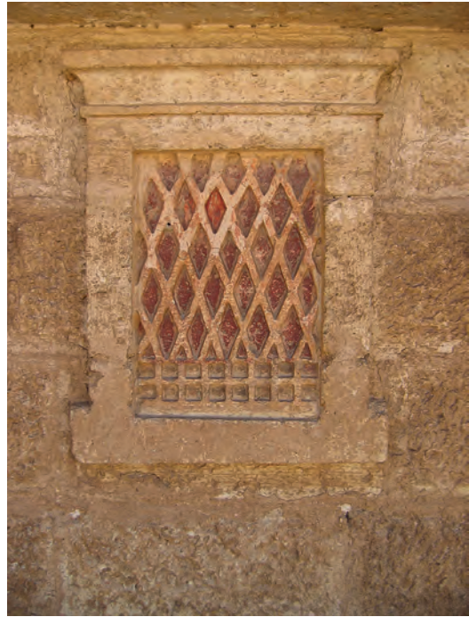
Abb. 7: Fassade, mittleres Fenster; 2006
