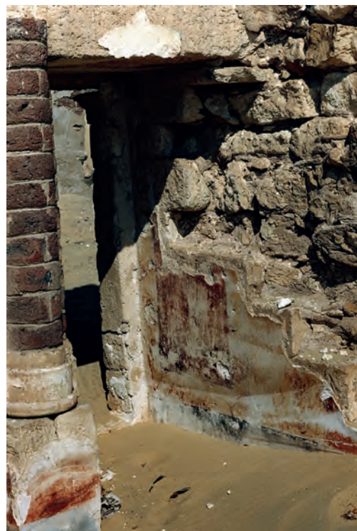
Abb. 12: Türbereich von Südosten; 1988
