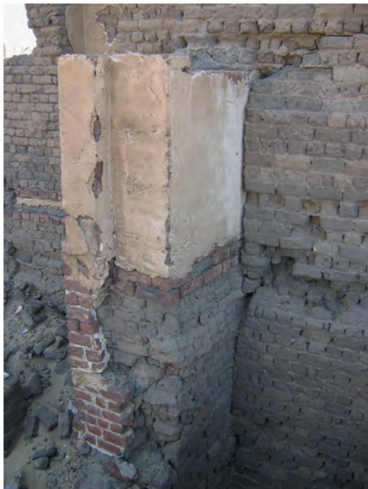
Abb. 4: Doppelstöckige Lehmziegelmauer vor dem Podium von GB 15; 2007
