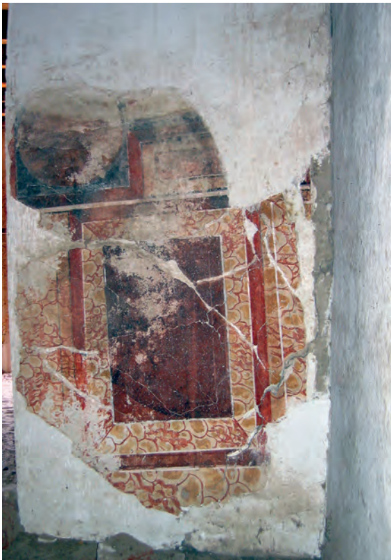
Abb. 41: GB 16, Obergeschoss, zweiter Raum, östliche Nordwand; 2005
