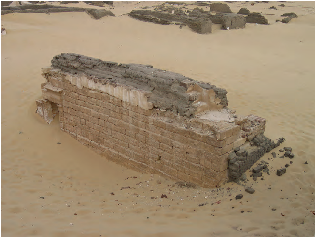
Abb. 10: Ansicht der Westwand von Südwesten; 2006
