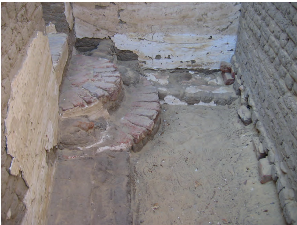
Abb. 13: GB 17, Bereich vor dem Eingang in das Treppenhaus nach Westen; 2006
