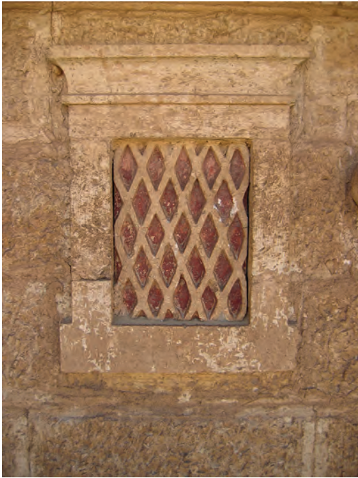
Abb. 6: Fassade, östliches Fenster; 2006
