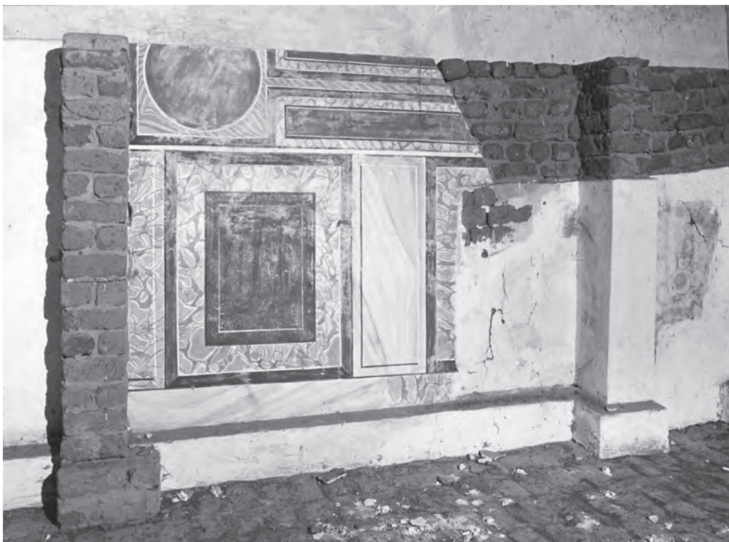
Abb. 46: GB 16, Obergeschoss, zweiter Raum, Südwand; 1973
