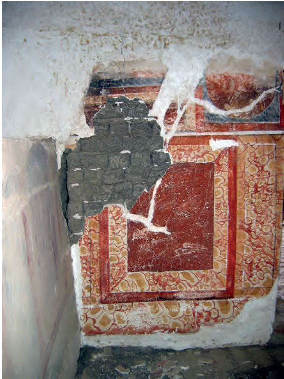
Abb. 40: GB 16, Obergeschoss, zweiter Raum, westliche Nordwand; 2005
