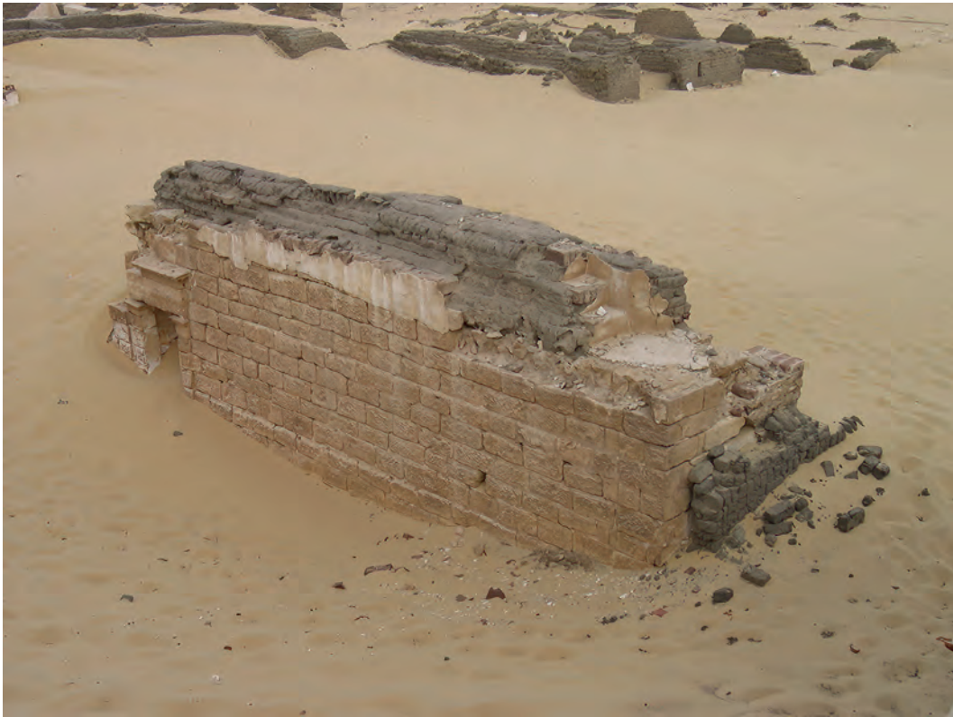
Abb. 10: Ansicht der Westwand von Südwesten; 2006
