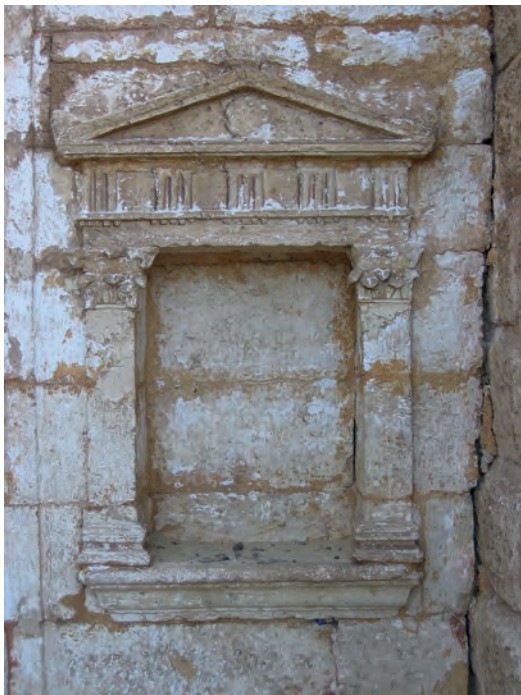
Abb. 8: GB 15, westliche Fassadennische; 2007
