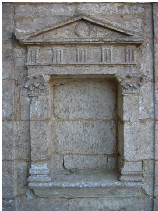
Abb. 9: GB 15, östliche Fassadennische; 2007
