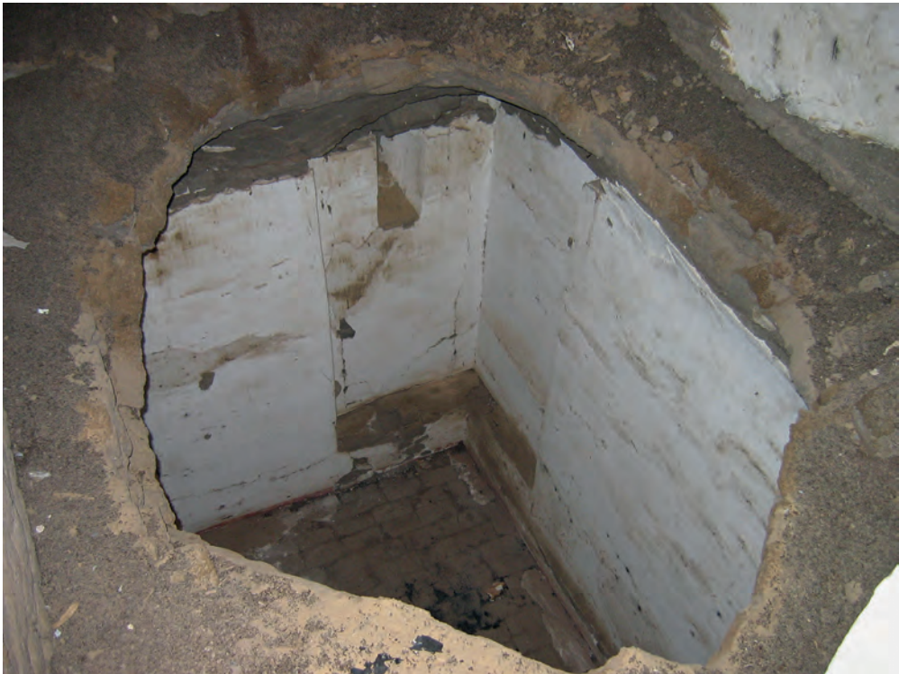
Abb. 25: GB 11, Untergeschoss, Raum; 2007
