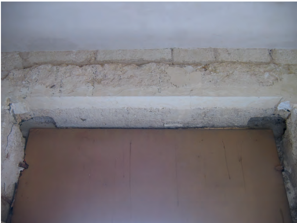
Abb. 13: GB 15, Türsturz mit Einlassungen für das Türgewinde; 2007
