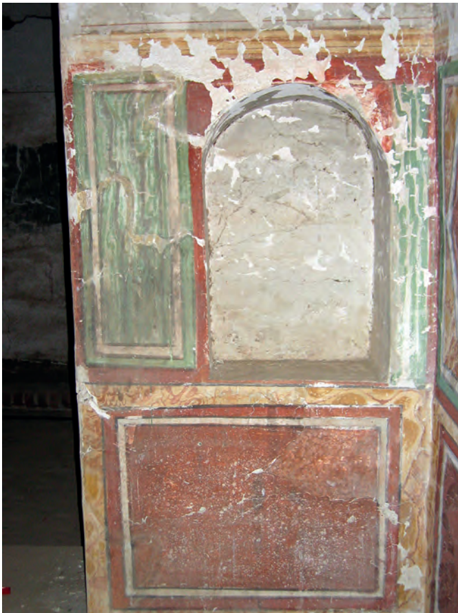
Abb. 9: GB 13, Obergeschoss, 1. Raum, westliche Südwand; 2006
