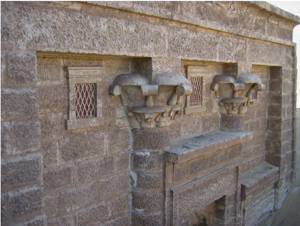
Abb. 4: Oberer Bereich der Fassade von Nordosten; 2007
