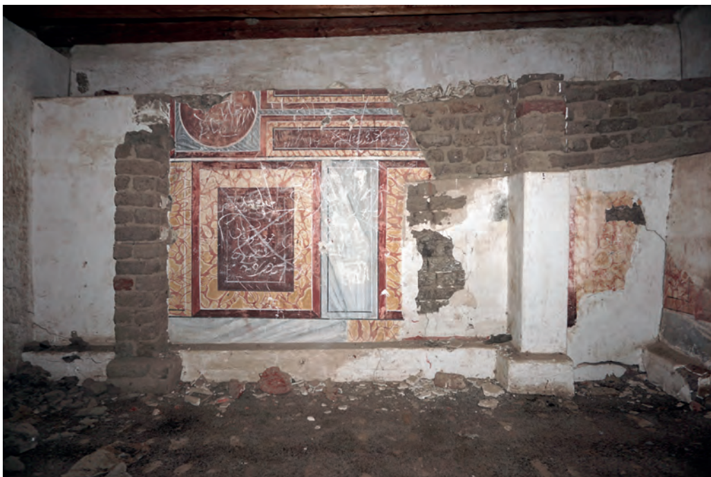
Abb. 47: GB 16, Obergeschoss, zweiter Raum, Südwand; 2019
