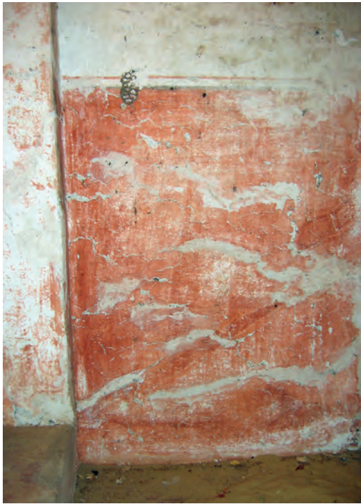
Abb. 23: GB 11, Untergeschoss, Eingangsbereich, Westwand; 2007
