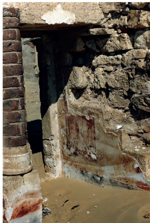
Abb. 12: Türbereich von Südosten; 1988
