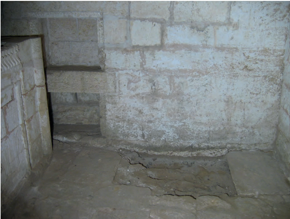
Abb. 14: GB 15, Innenraum, Westseite mit Grabgrube; 2007
