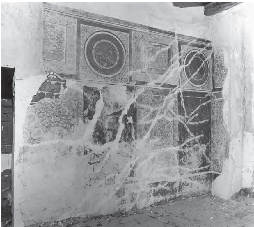
Abb. 3: GB 16, Obergeschoss, erster Raum, Westwand; 1973
