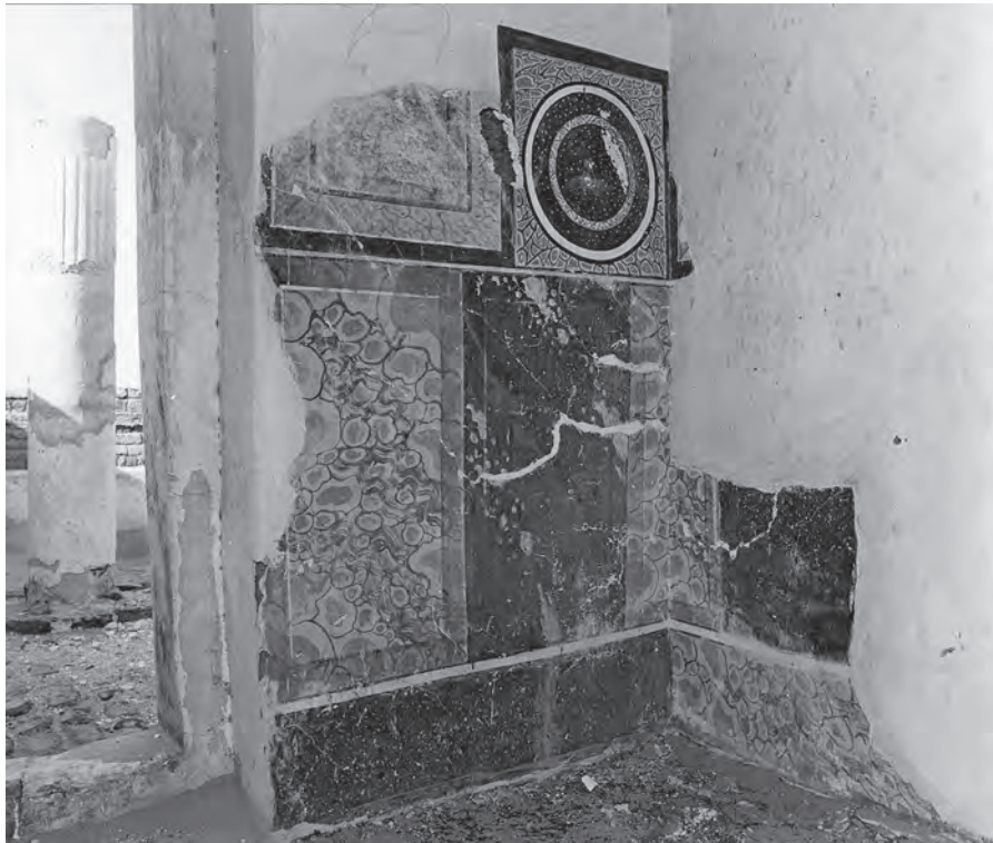
Abb. 32: GB 16, Obergeschoss, erster Raum, Nordostwand; 1973
