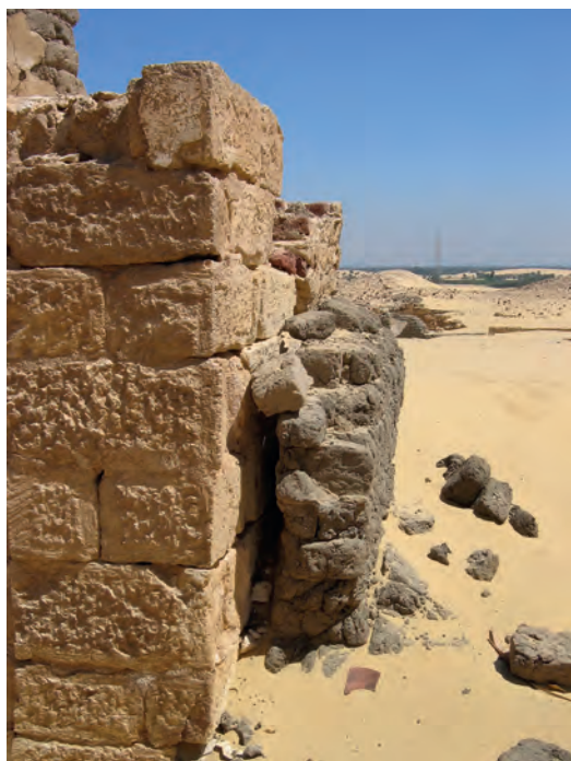
Abb. 9: Mauer aus ungebrannten Ziegeln vor der Südwand; 2005
