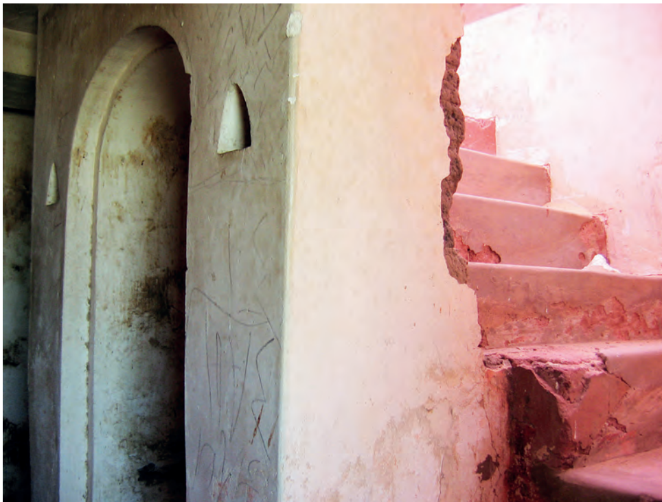
Abb. 21: GB 11, Obergeschoss, Eingangsbereich mit Nische und zum Dach führender Treppe; 2007
