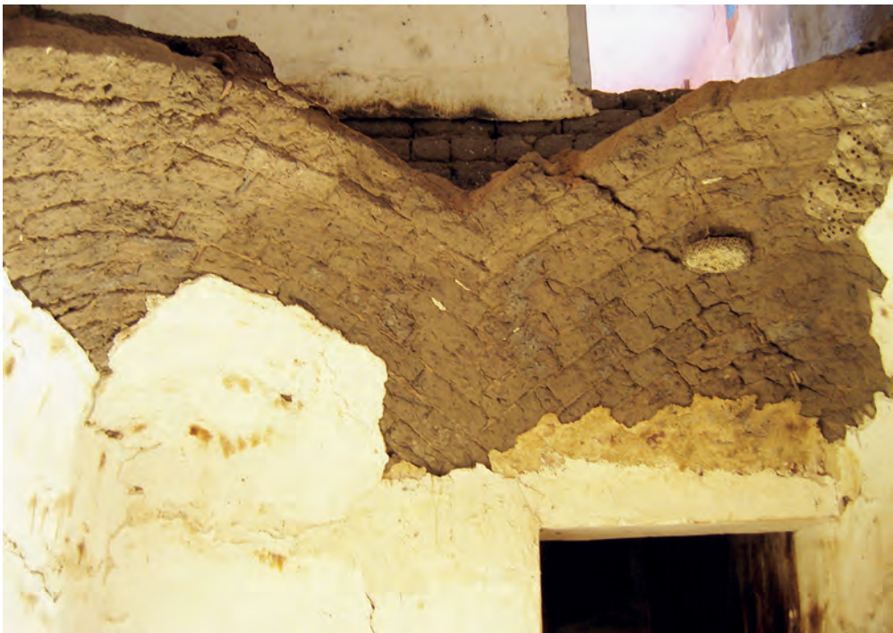
Abb. 26: GB 11, Untergeschoss, Raum mit Gewölbeansatz; 2007
