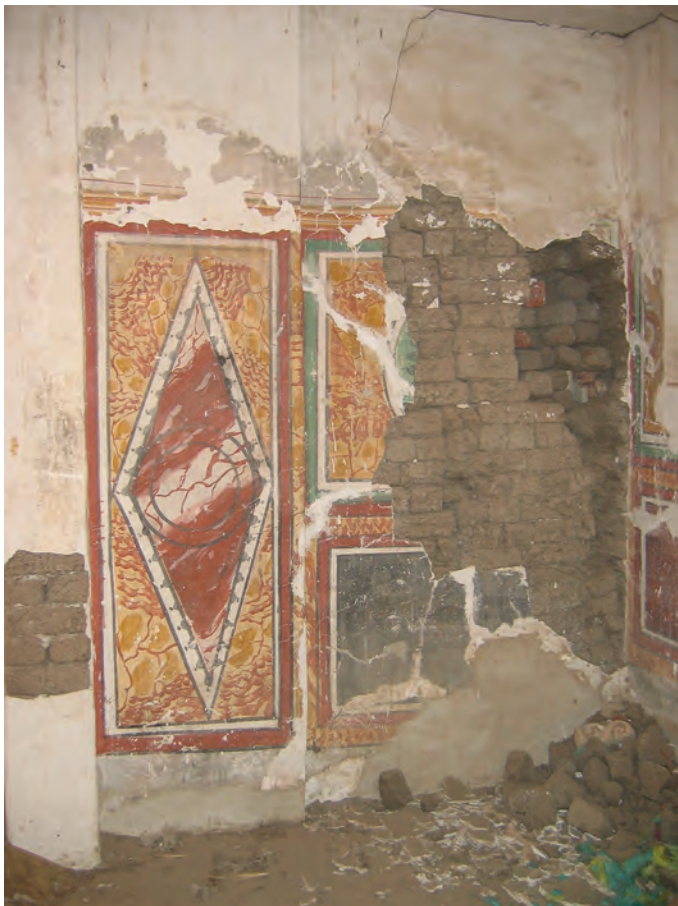
Abb. 6: GB 13, Obergeschoss, 1. Raum, Nordwand; 2006
