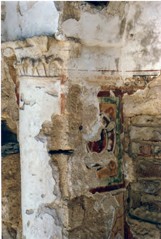
Abb. 14: Nördliches Arkosol, Nordseite des südlichen Pfeilers; 1986
