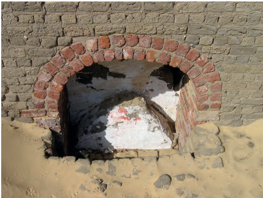
Abb. 20: GB 16, Erdgeschoss, Grabpfeiler an der östlichen Außenwand; 2007
