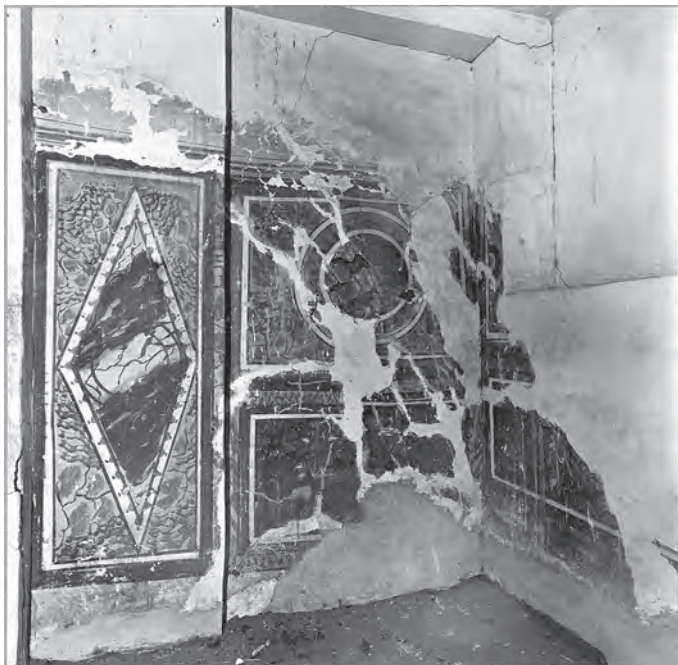
Abb. 7: GB 13, Obergeschoss, 1. Raum, Nordwand; 1973
