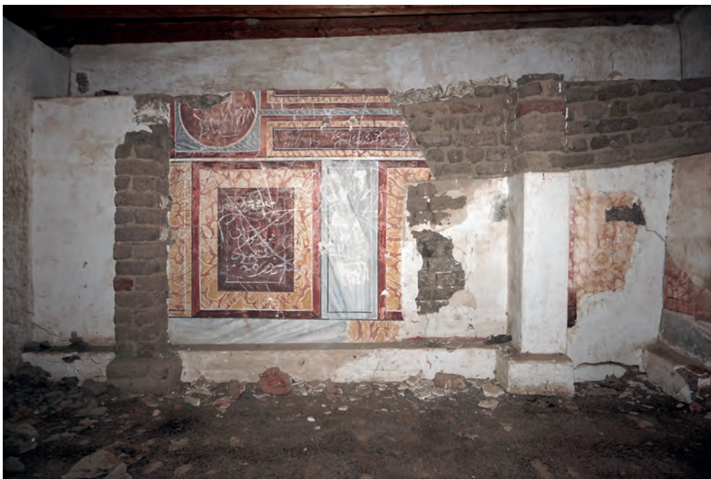
Abb. 47: GB 16, Obergeschoss, zweiter Raum, Südwand; 2019
