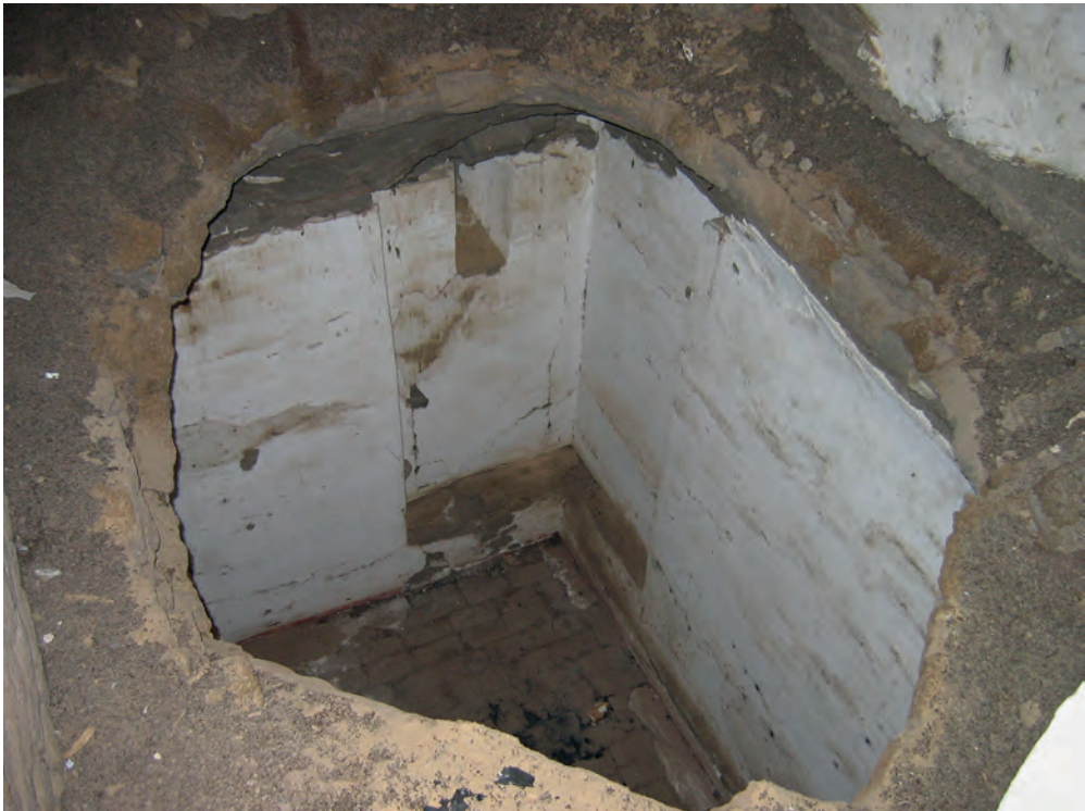
Abb. 25: GB 11, Untergeschoss, Raum; 2007
