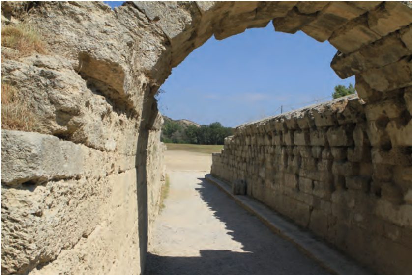
Abbildung 3: Der tunnelartige Zugang zum Stadion von Olympia
