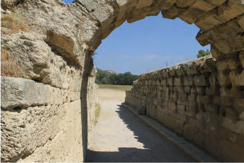
Abbildung 3: Der tunnelartige Zugang zum Stadion von Olympia
