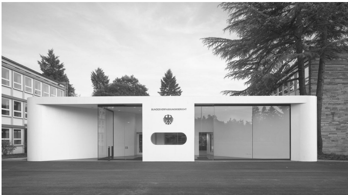
Abb. 44: Bundesverfassungsgericht, Dienstsitz Waldstadt (2011-2014), Eingangsbäude
