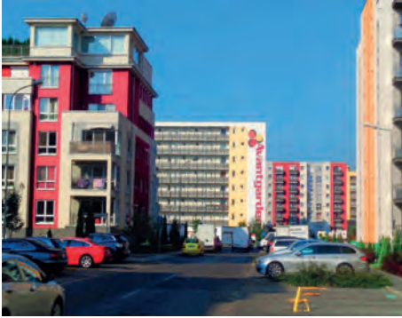
Abb.II.7.5 Neue Eigentumswohnungen am Stadtrand von Braşov/Kronstadt
