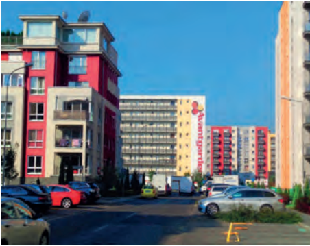
Abb.II.7.5 Neue Eigentumswohnungen am Stadtrand von Braşov/Kronstadt
