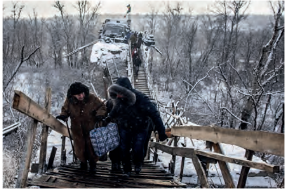
Abb.I.3.7 Zerstörte Brücken: Auswirkungen des Ukraine-Konfliktes auf die Infrastruktur in umkämpften Regionen.
