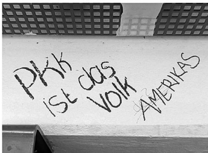
Abb. 9: UHG, Haupthalle, Galerie C1.
