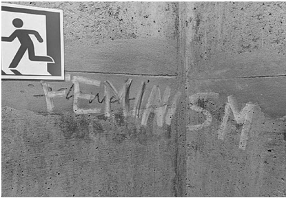
Abb. 10: UHG, Treppenturm D, Ebene 2.
