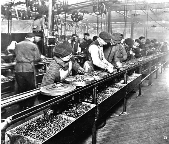
Abbildung 9: „Flywheel Magneto“-Montagelinie, Highland Park (1913)
