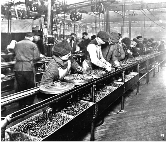
Abbildung 9: „Flywheel Magneto“-Montagelinie, Highland Park (1913)
