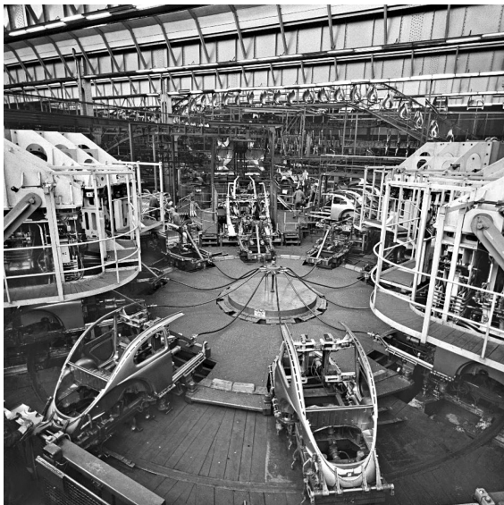
Abbildung 43: Hinterwagen-Karussell im Karosseriebau Werk Wolfsburg (1962)
