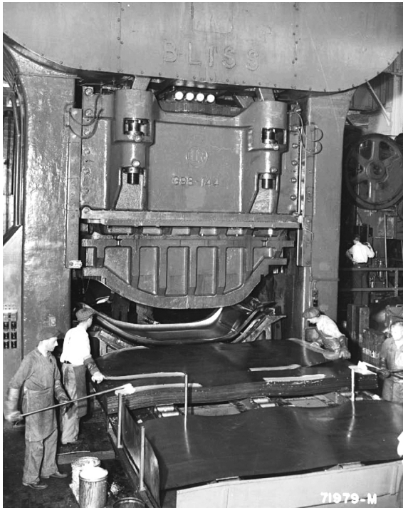
Abbildung 27: Pressen des Dachteils (1939)
