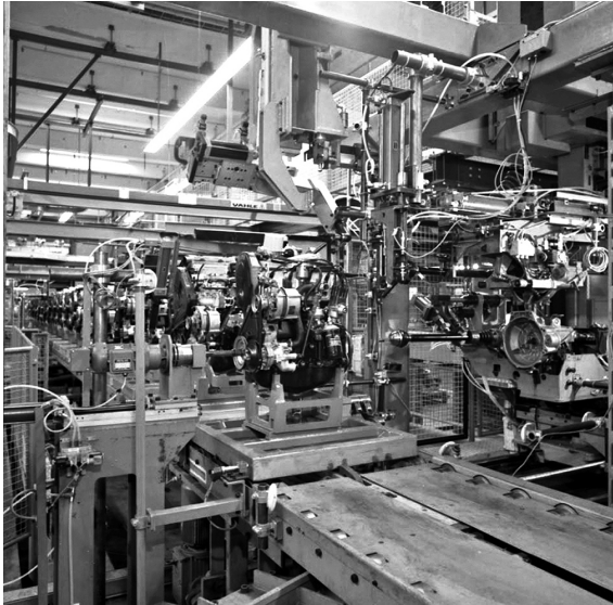
Abbildung 52: Automatisierte Triebatzmontage in Halle 54 (1984)
