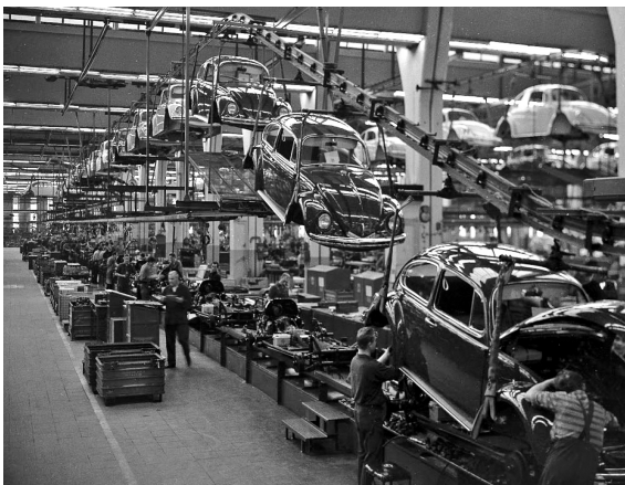
Abbildung 45: Montagearbeit im Vorderwagen im Werk Wolfsburg (1962)
