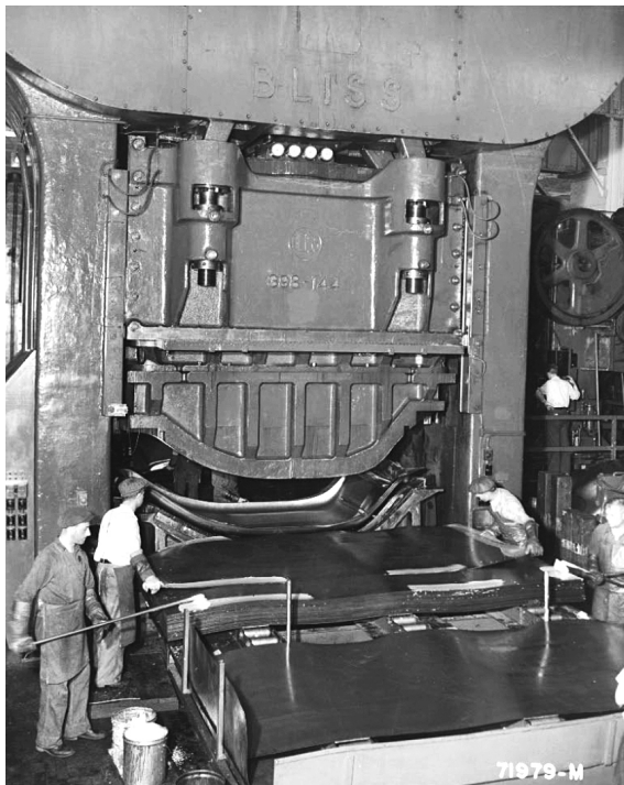
Abbildung 27: Pressen des Dachteils (1939)
