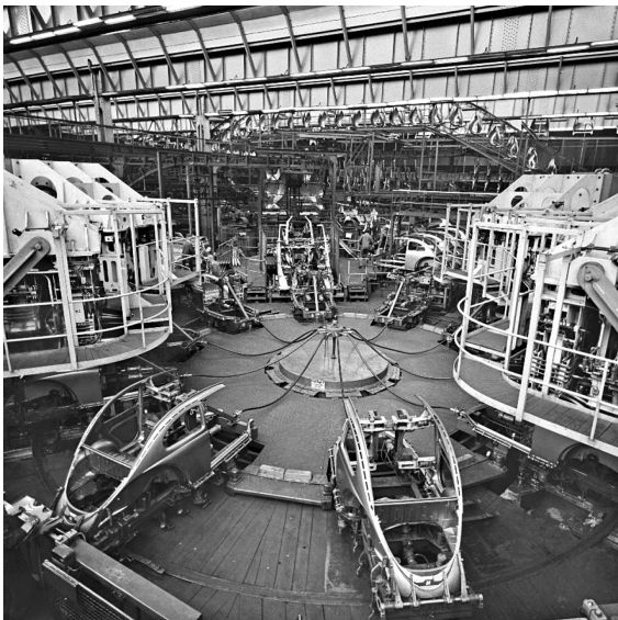
Abbildung 43: Hinterwagen-Karussell im Karosseriebau Werk Wolfsburg (1962)
