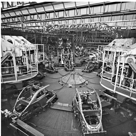
Abbildung 43: Hinterwagen-Karussell im Karosseriebau Werk Wolfsburg (1962)
