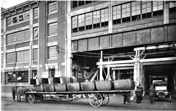
Abbildung 14: Ford-Modell-T-Karosserien bei der Anlieferung im Highland-Park-Werk (1913/14)
